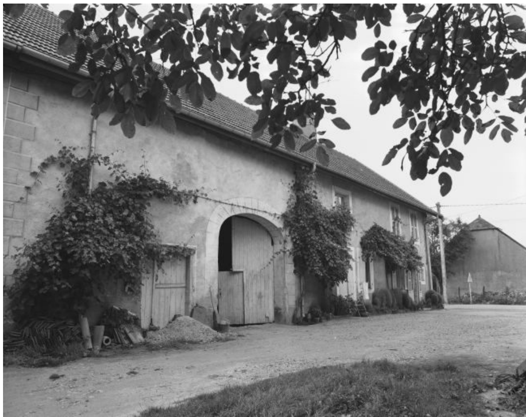
Vue d'ensemble de la façade antérieure.
