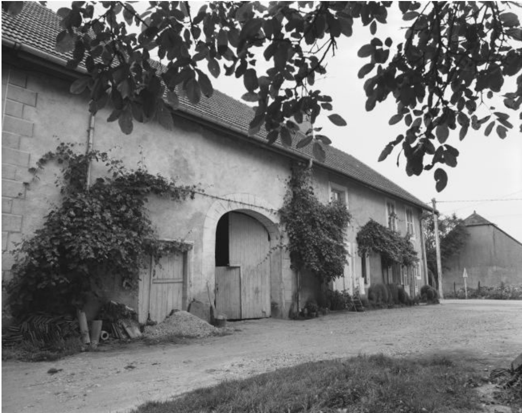
Vue d'ensemble de la façade antérieure.
