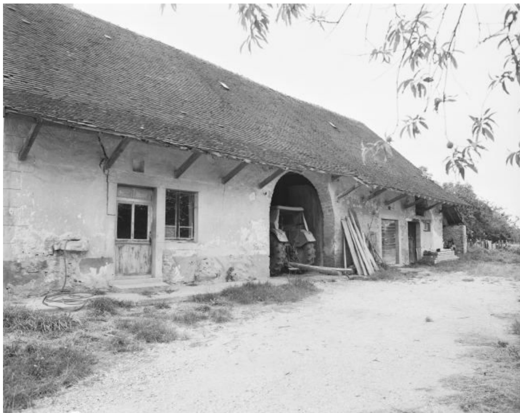
Vue d'ensemble de la façade antérieure.
