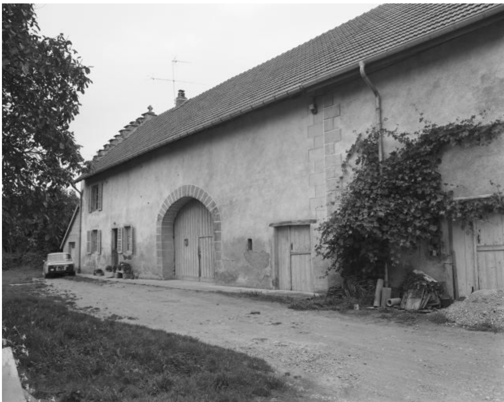
Vue d'ensemble de la façade antérieure.
