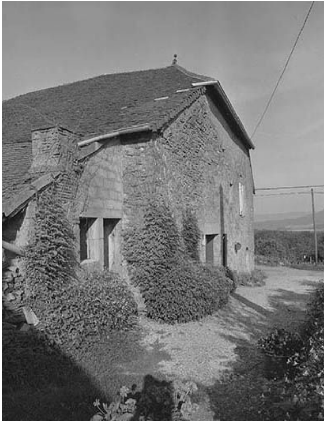
Face gauche, vue de trois quarts droit. 39, Toulouse-le-Château rue de l' Eglise
