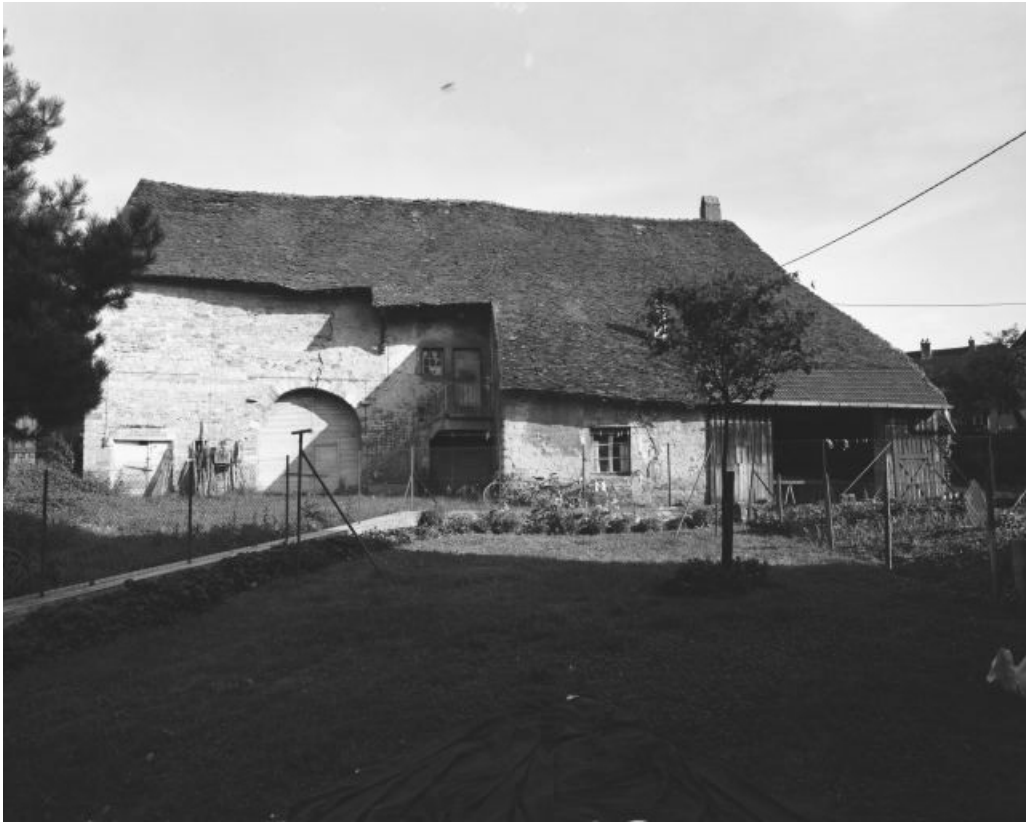
Façade antérieure vue de face.
