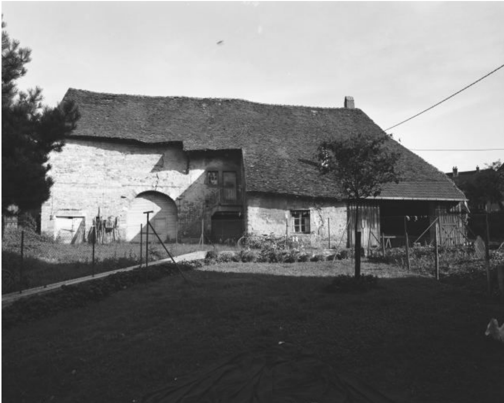
Façade antérieure vue de face.
