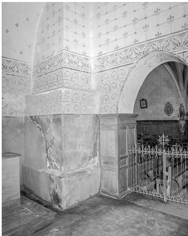
Intérieur : angle antérieur gauche de la nef.
