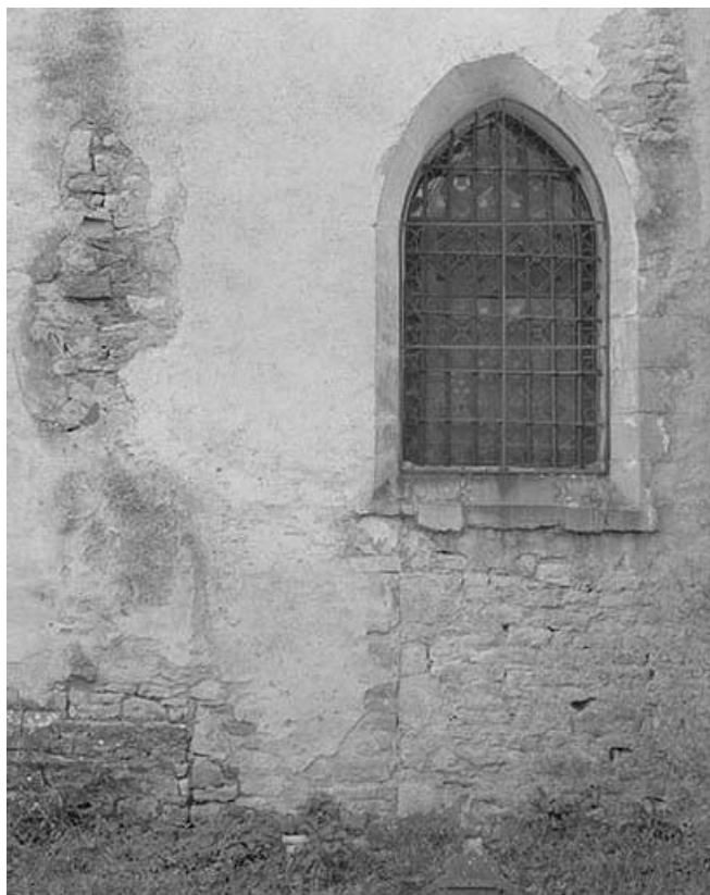
Façade latérale gauche : baie de la partie droite du chœur.
