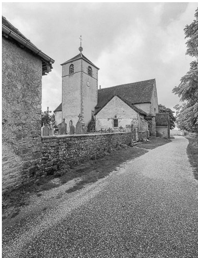
Façade latérale gauche, vue de l'ouest.
