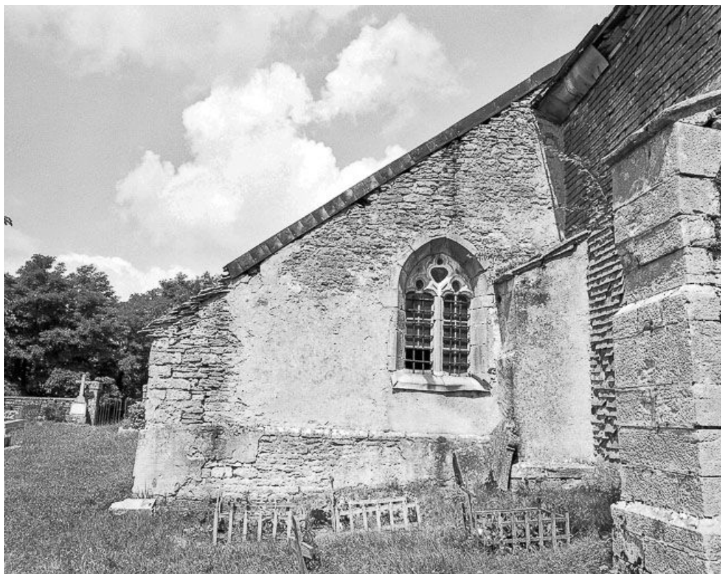
Façade latérale droite : mur postérieur de la sacristie. 39, Toulouse-le-Château rue de l' Eglise, lieudit : au Château
