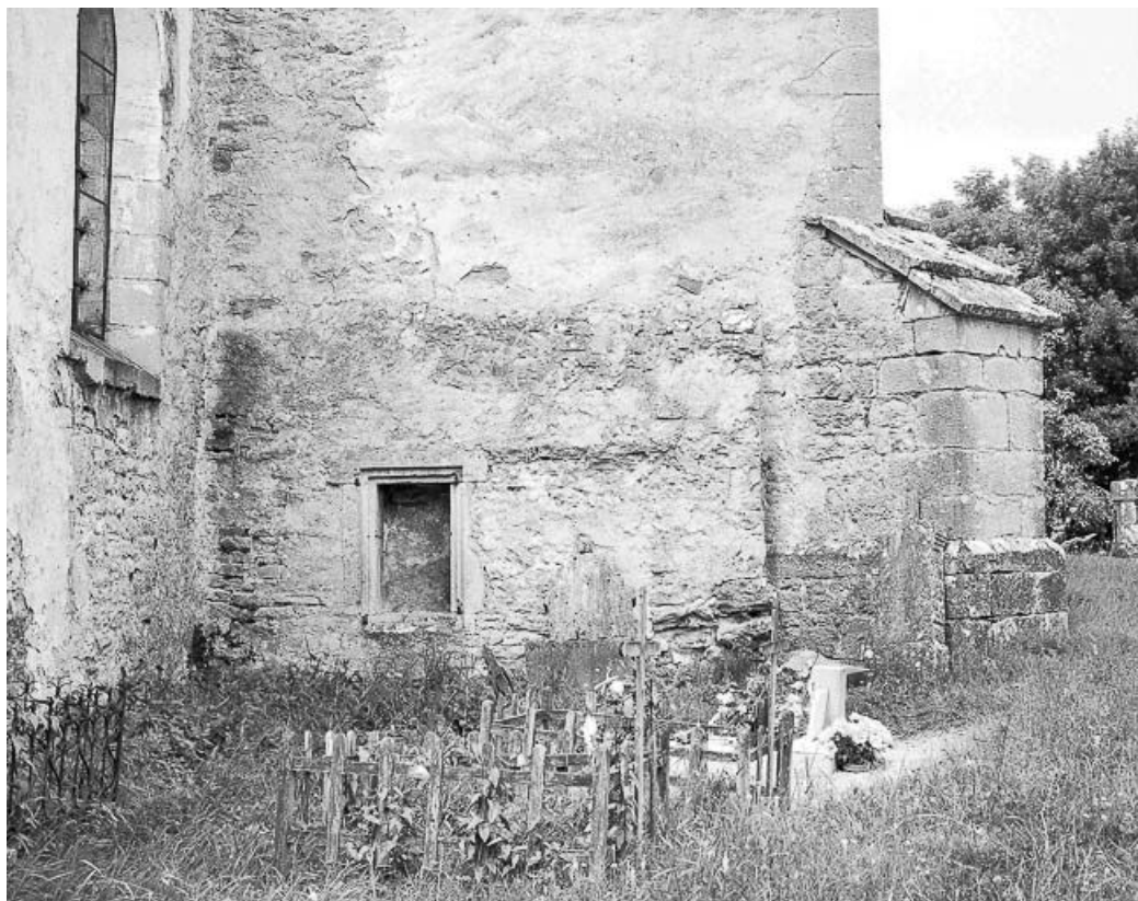
Tour-clocher : base de la face Est.
