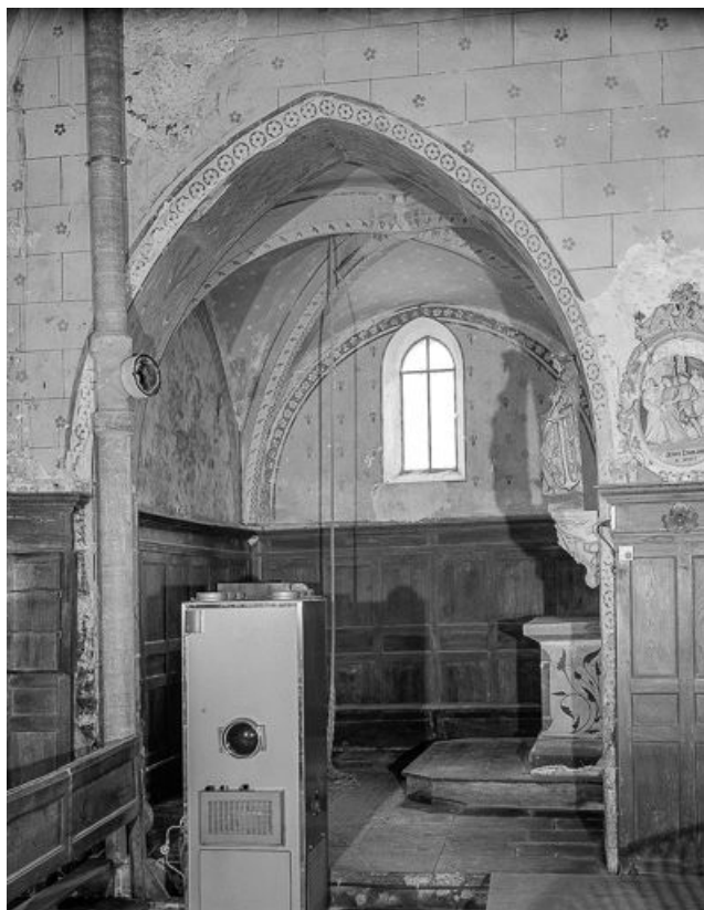
Intérieur : arc d'entrée de la seconde chapelle gauche.
