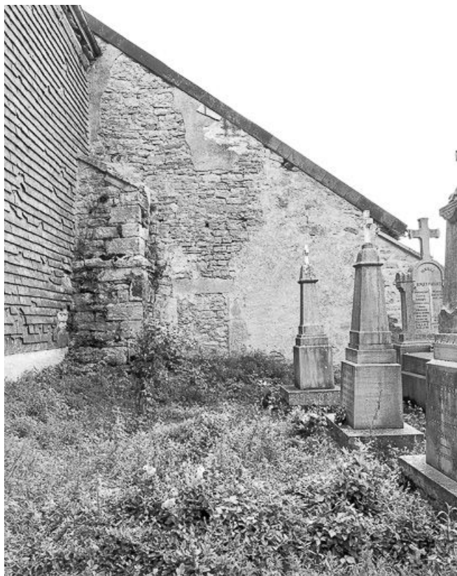
Façade latérale droite : détail du mur antérieur de la sacristie.
