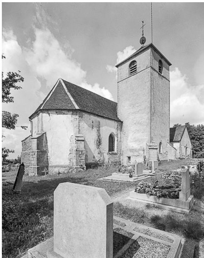
Façade latérale gauche vue depuis l'est.
