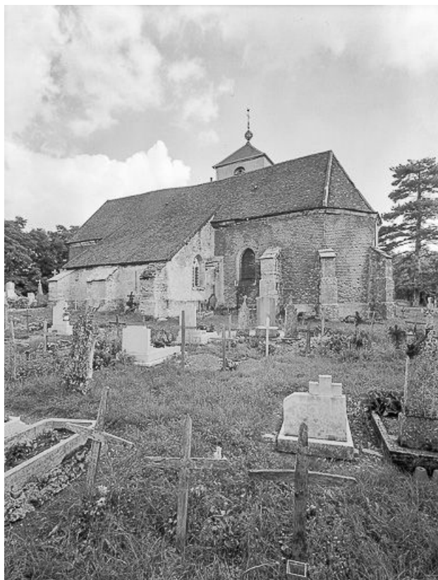
Façade latérale droite vue depuis l'est.
