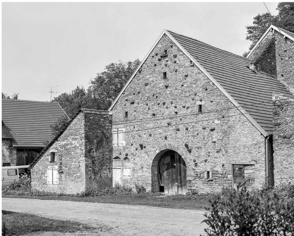
Ferme située rue de l'Eglise, cadastrée 1958 AE 219 : vue d'ensemble. 39, Toulouse-le-Château
