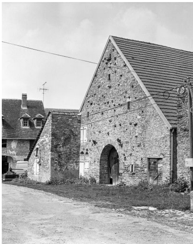
Ferme située rue de l'Eglise, cadastrée 1958 AE 219 : vue de trois quarts droit. 39, Toulouse-le-Château
