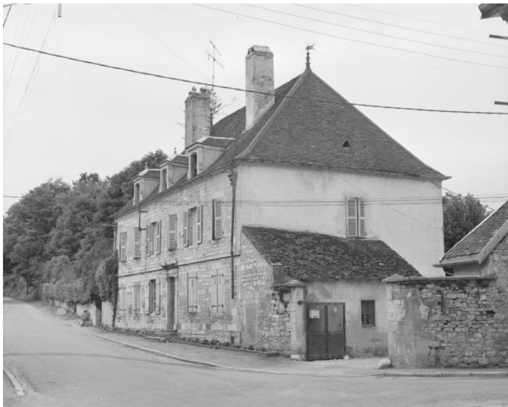
Façades antérieure et latérale droite.
