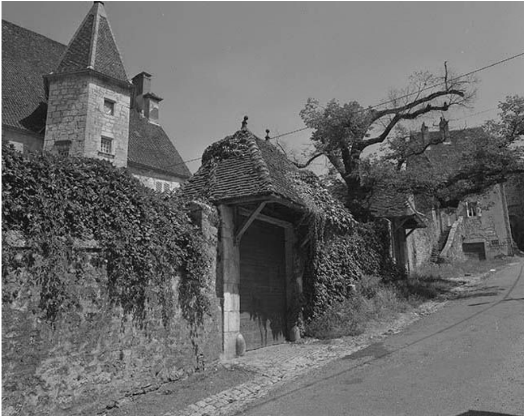
Le mur d'enceinte de la cour.
