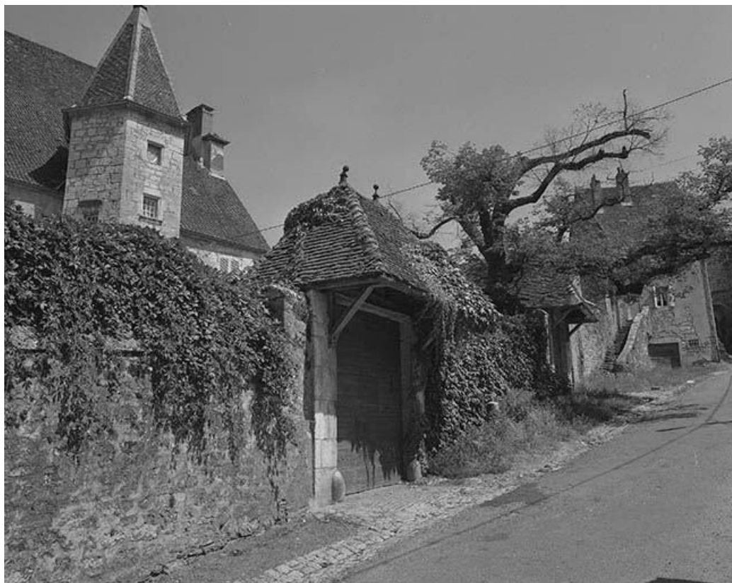
Le mur d'enceinte de la cour.
