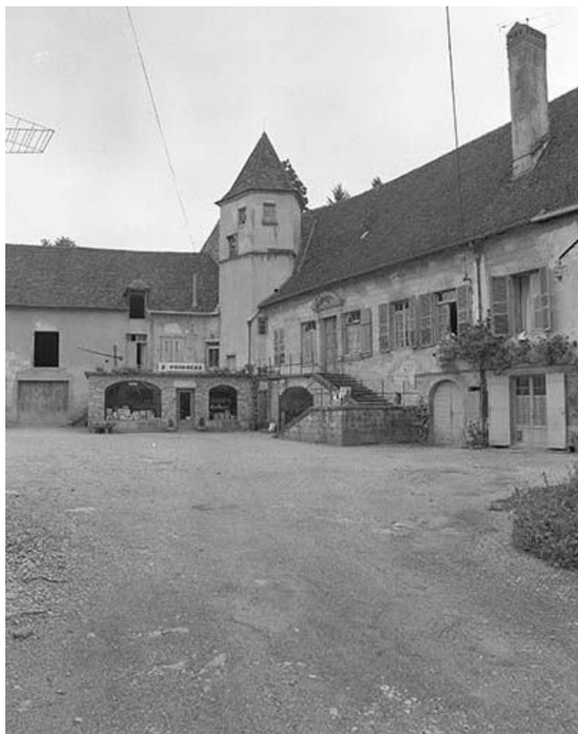
Angle sud de la cour.
