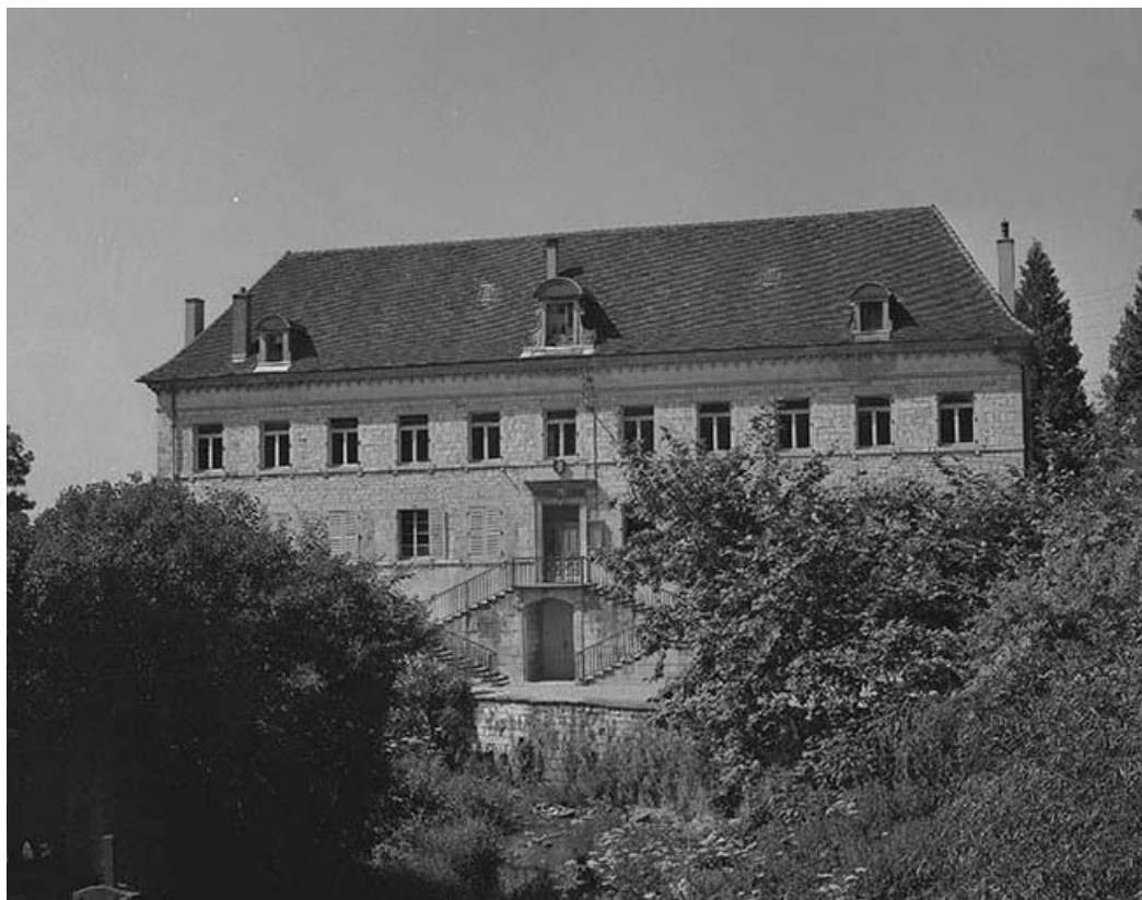
Façade antérieure, vue de face.
