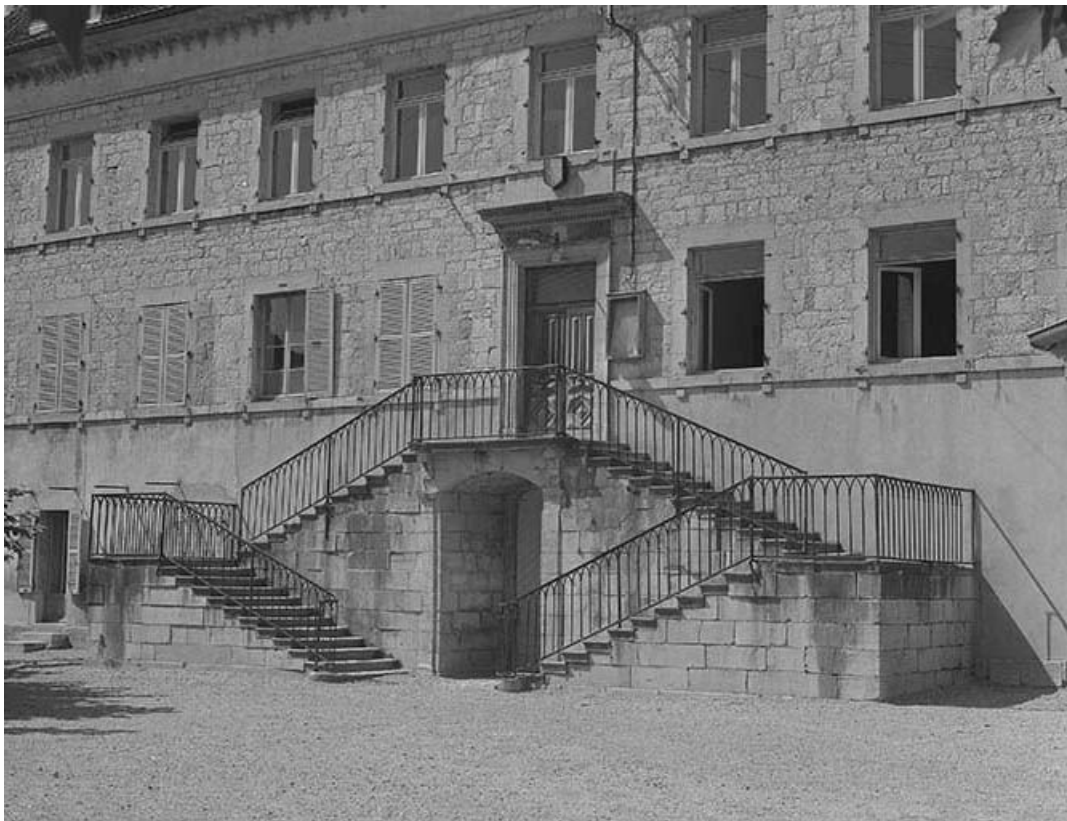
Façade antérieure, l'escalier.
