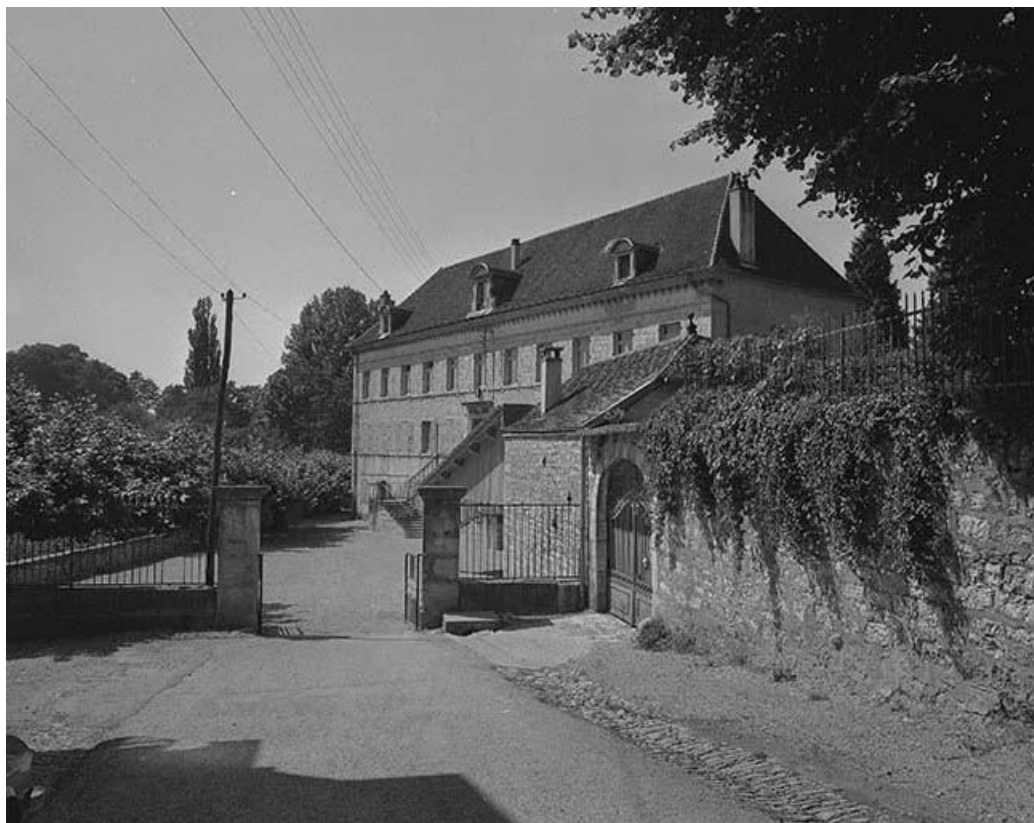
Vue générale depuis l'entrée de la cour.
