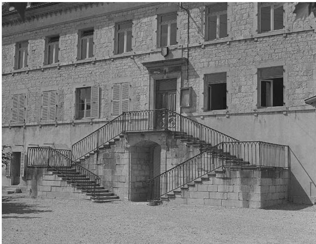
Façade antérieure, l'escalier.
