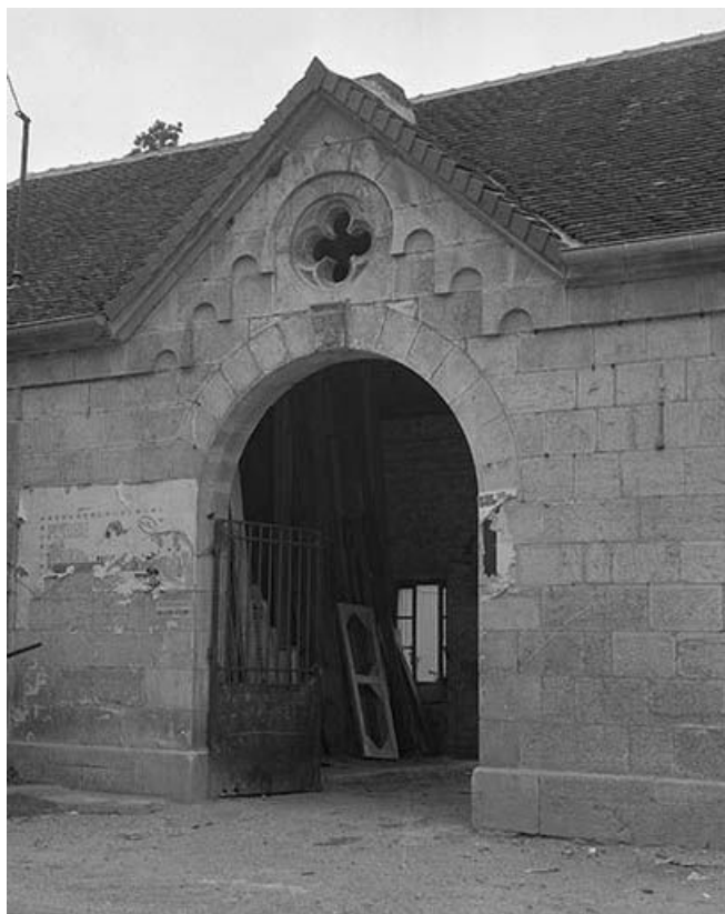
Façade est, passage d'entrée.
