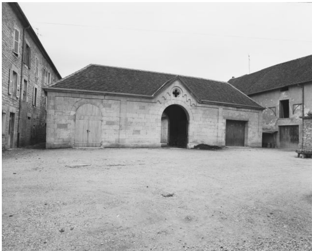
Vue générale de la façade ouest.
