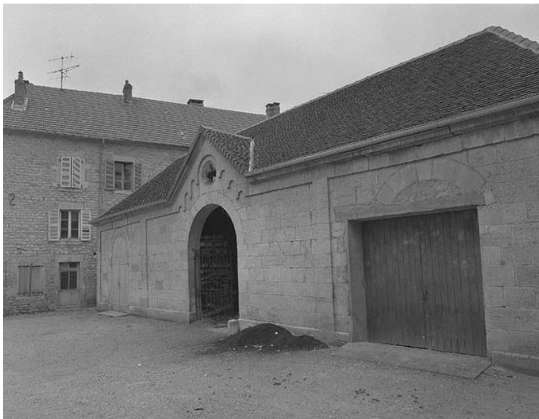
Façade ouest, vue générale de trois quarts droit.
