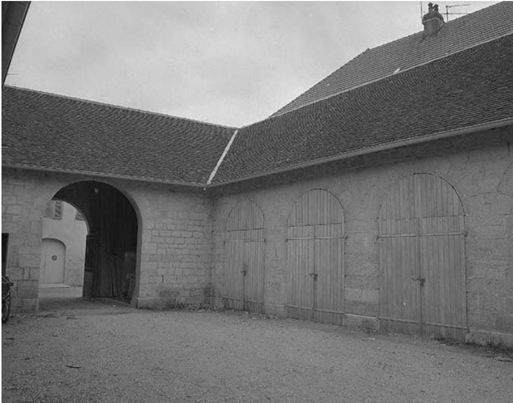
Cour intérieure, angle nord-est.
