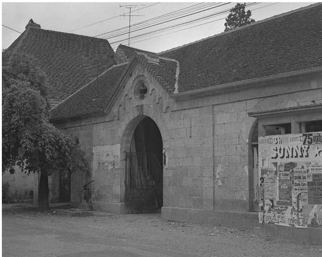
Façade est, vue de trois quarts droit.
