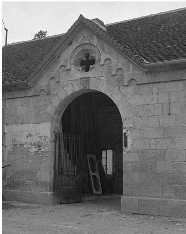
Façade est, passage d'entrée.
