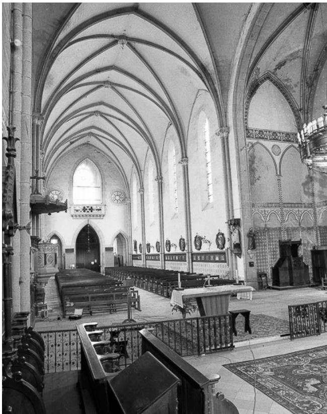
Extérieur : nef, élévation gauche vue du chœur.
