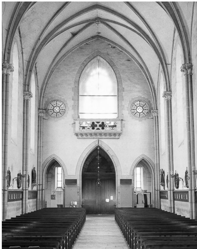
Extérieur : nef vue du chœur.
