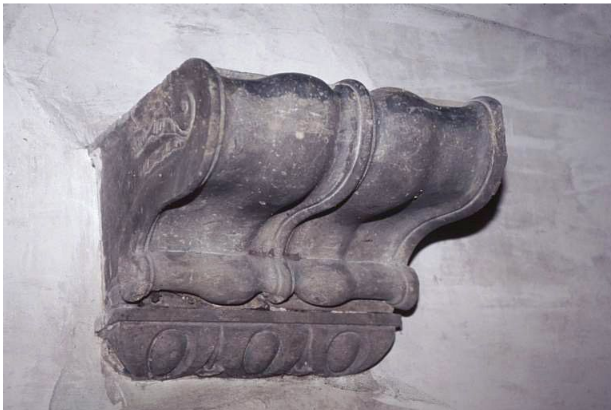
Console de la sacristie nord vue de trois quarts droit.
