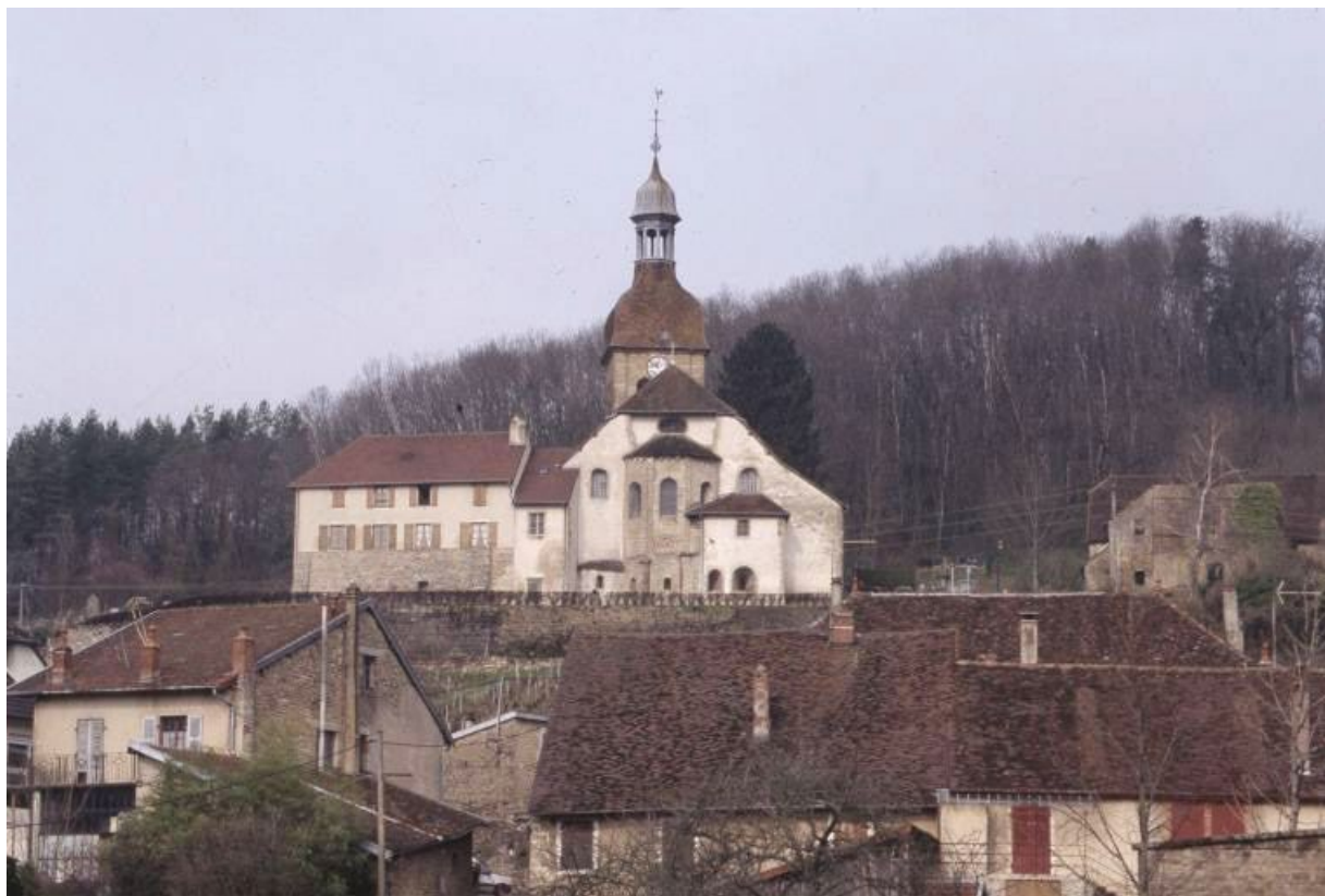
Vue générale du chevet de l'église et de la façade est du prieuré, vue éloignée. 39, Saint-Lothain
