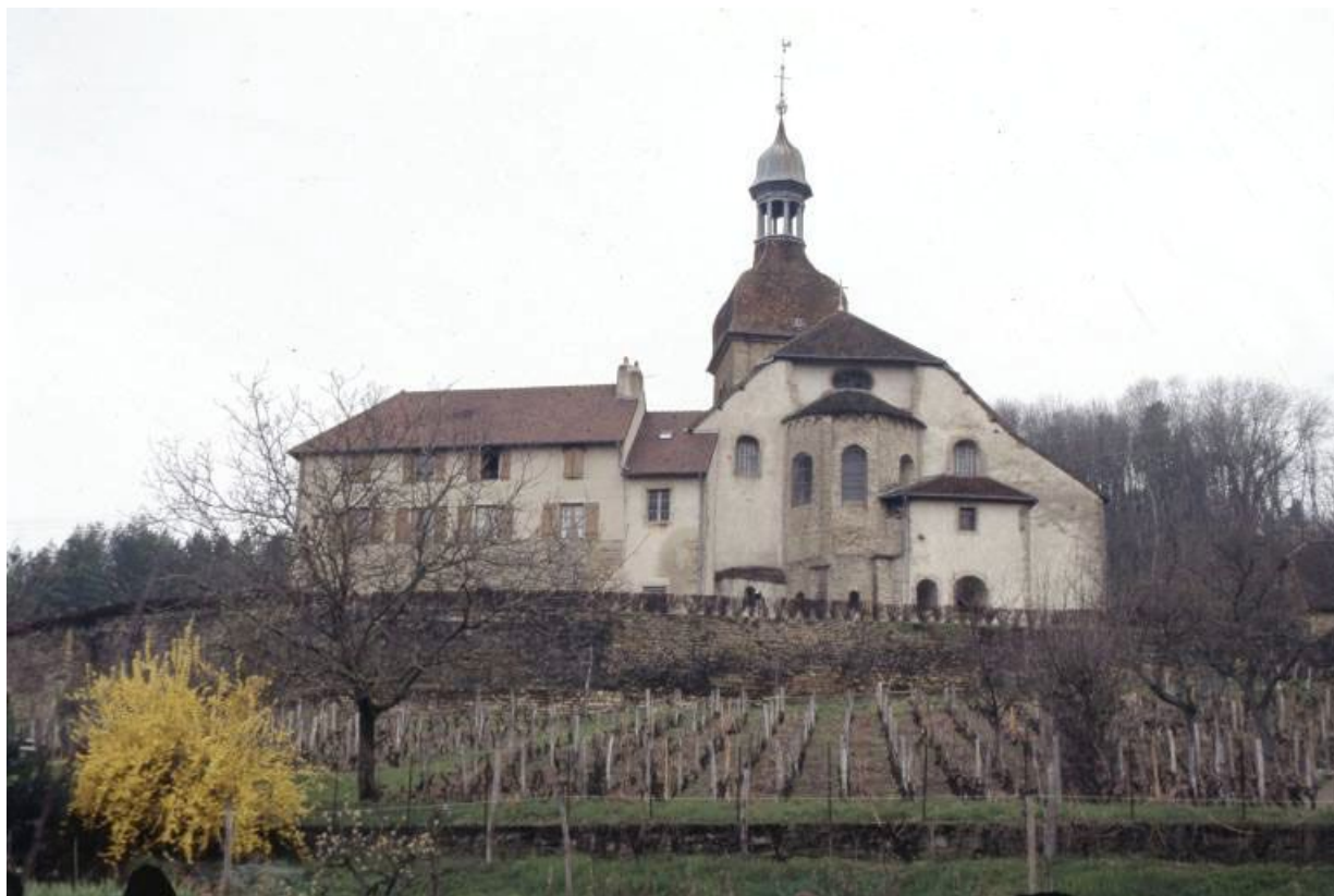
Vue générale du chevet de l'église et de la façade est du prieuré.
