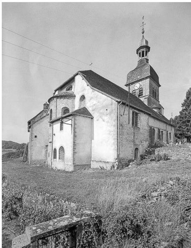
Eglise : façades postérieure et latérale gauche. 39, Saint-Lothain
