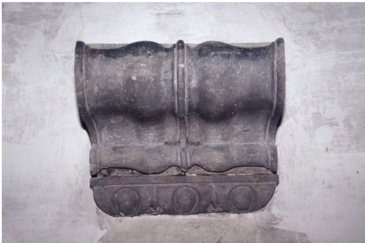
Console de la sacristie nord vue de face.
