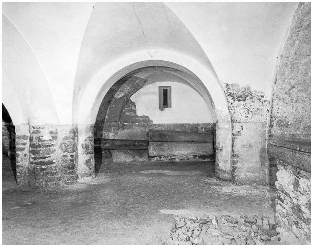
Intérieur : crypte, vaisseau central, 2e travée, élévation gauche. 39, Saint-Lothain
