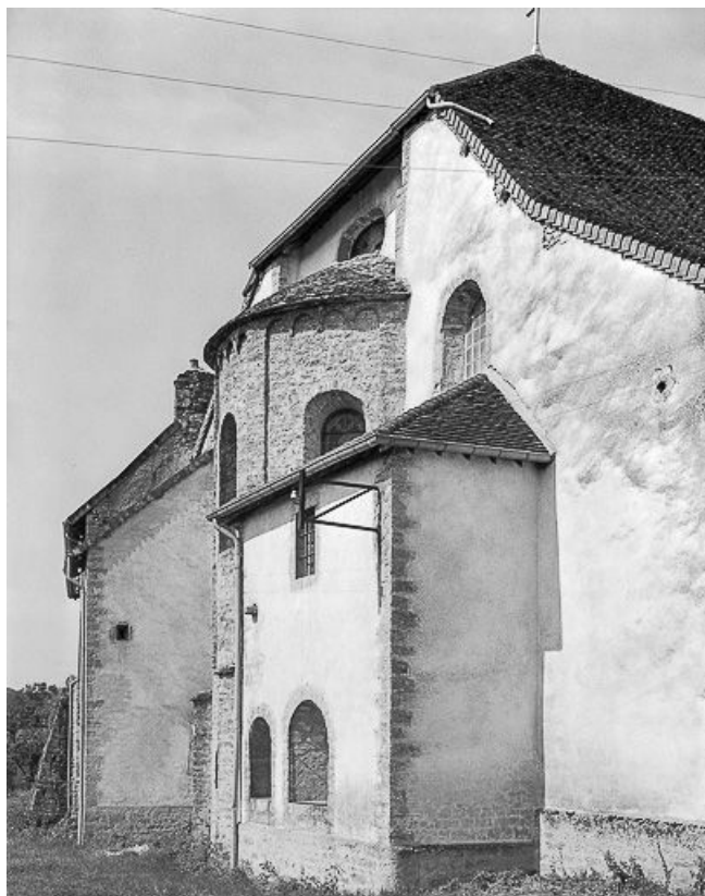
Eglise : abside et sacristie. 39, Saint-Lothain
