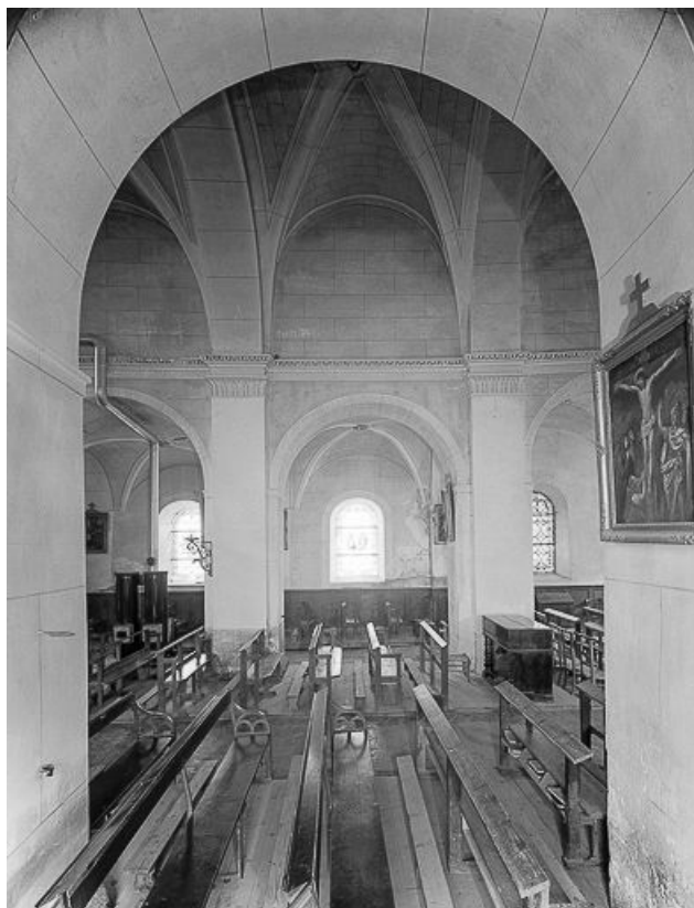
Intérieur : vaisseau central, 3e travée, élévation gauche. 39, Saint-Lothain
