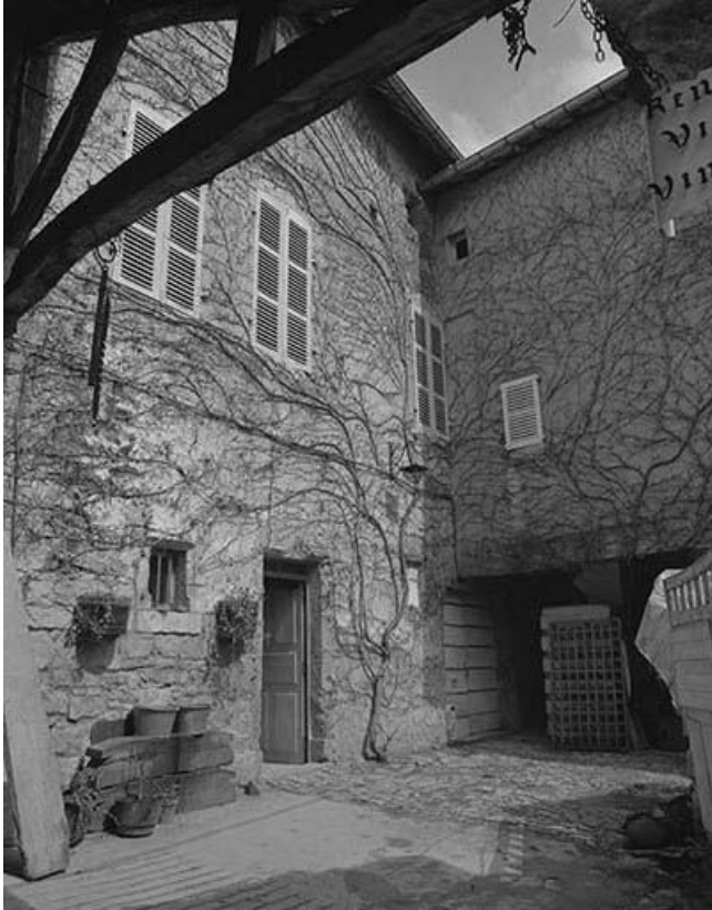
Façade sur la cour.
