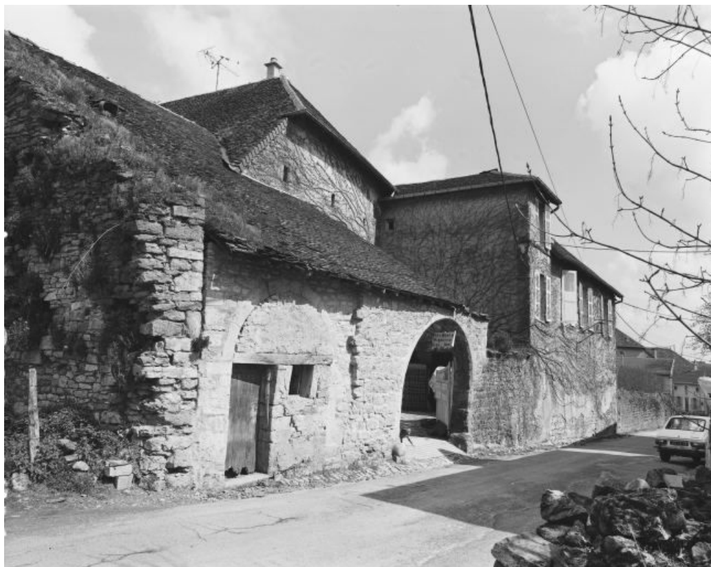
Vue générale depuis la rue. 39, Saint-Lothain
