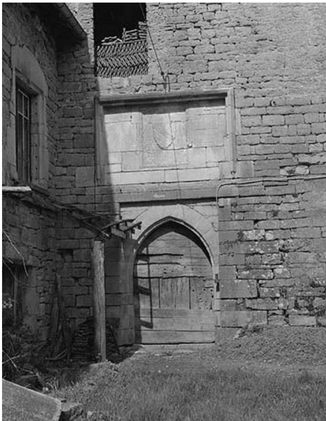
Porte du corps de bâtiment au fond de la cour. 39, Saint-Lothain
