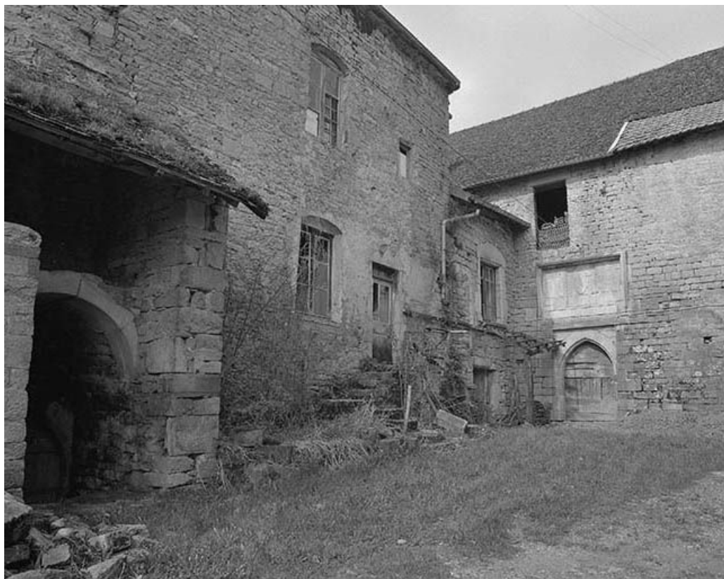
L'aile gauche, élévation sur la cour. 39, Saint-Lothain
