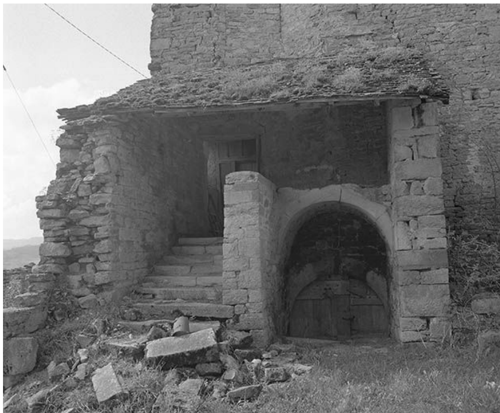
L'aile gauche, ruine de la tourelle d'escalier.
