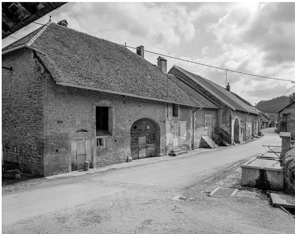
Ferme situées rue du Dessous : façades sur rue. 39, Saint-Lothain
