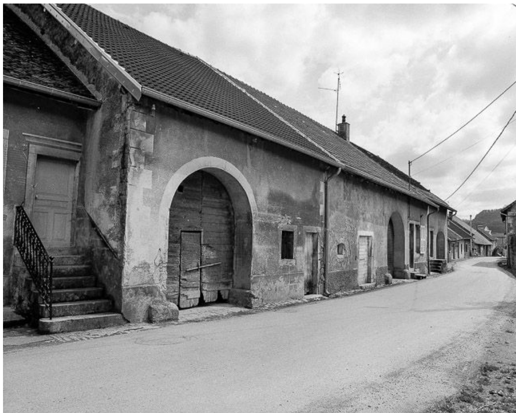
Ferme situées rue du Dessous : façades sur rue.
