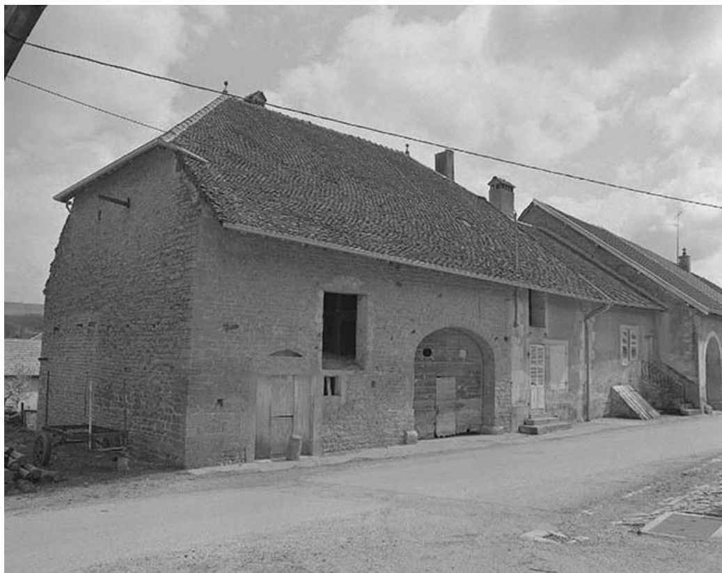
Ferme à trois travées située rue du Dessous : façade antérieure. 39, Saint-Lothain
