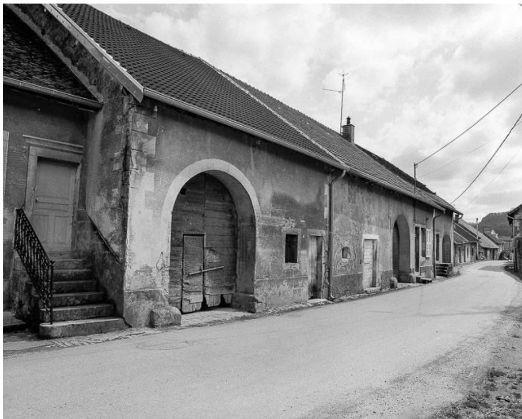
Ferme situées rue du Dessous : façades sur rue. 39, Saint-Lothain
