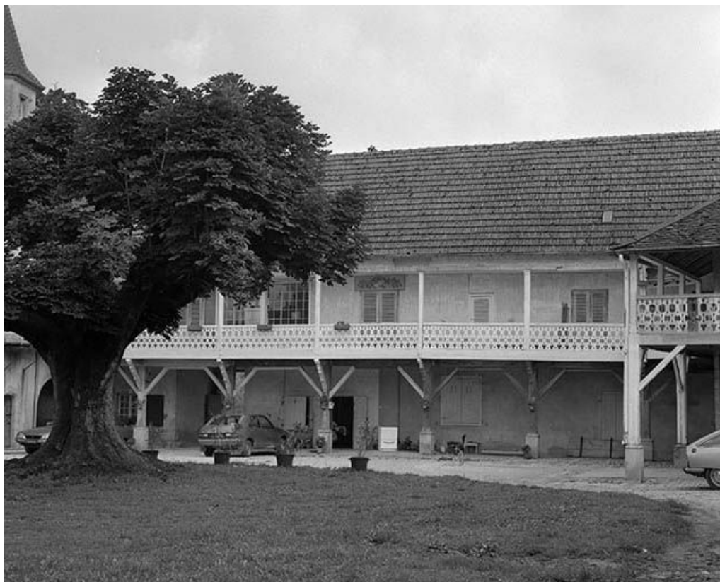
Les communs, élévation sur la cour, partie droite
