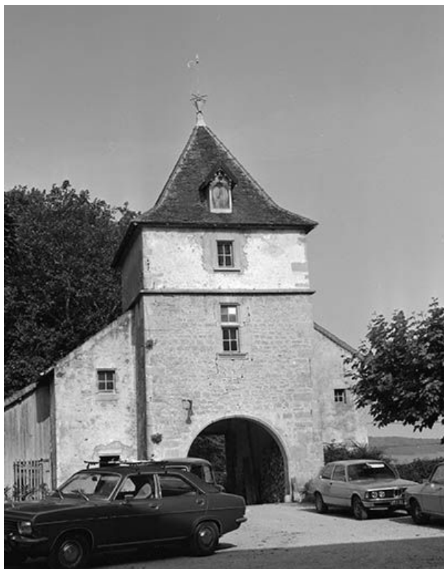
Le corps d'entrée. élévation sur la cour, de face.
