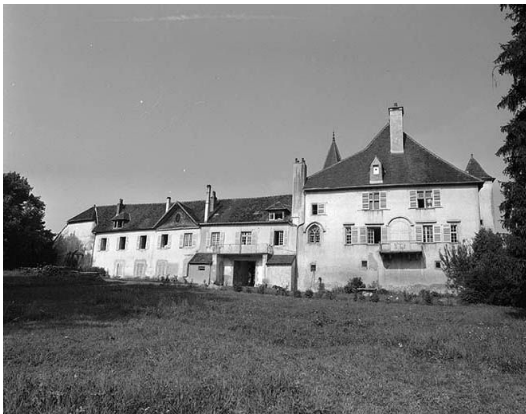
Façade orientale, vue générale.
