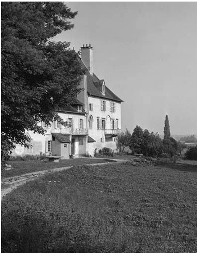
Le corps de logie, façade orientale.
