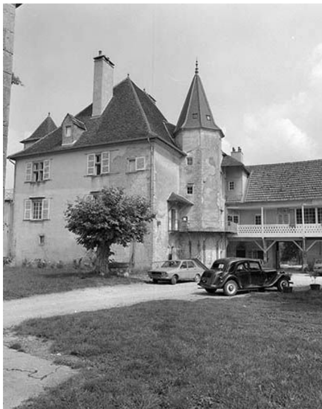
Le corps de logis, élévation sur la cour. 39, Saint-Lamain route des Longuevernes
