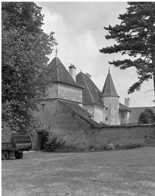
Le corps d'entrée et le corps du logis vus depuis le sud-ouest.
