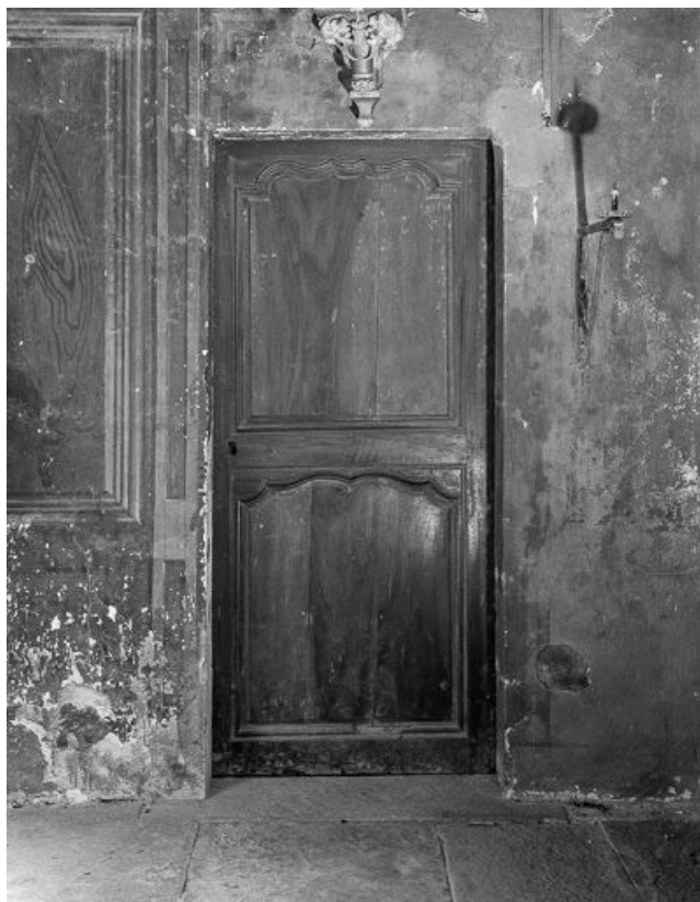
Intérieur : chœur : porte de la sacristie.
