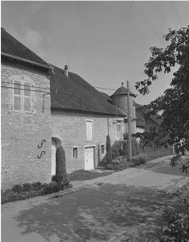
Façade sur rue, partie gauche.
