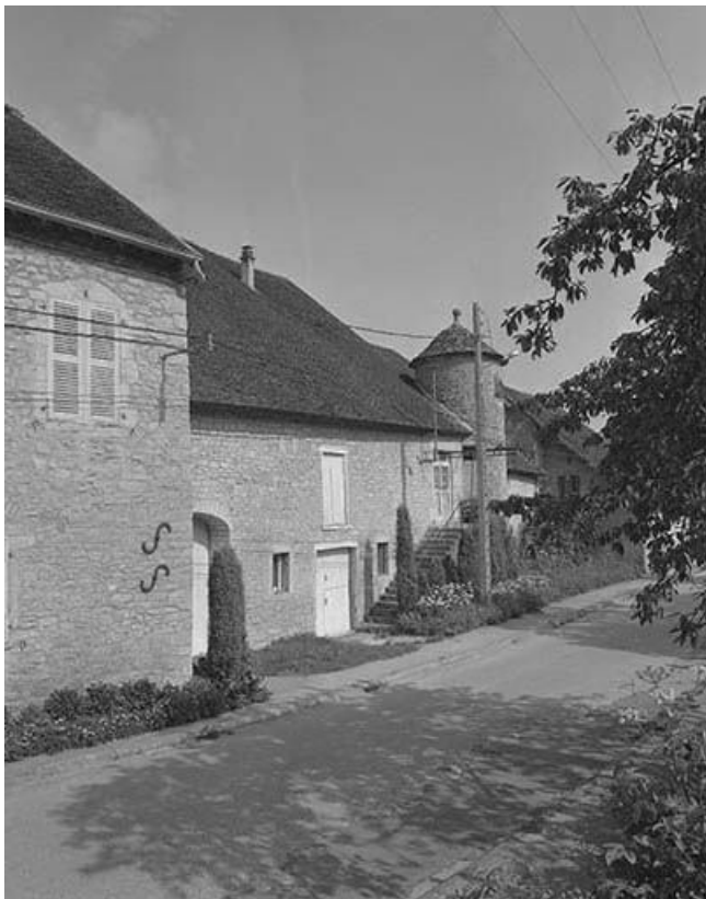
Façade sur rue, partie gauche.
