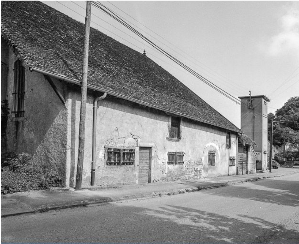
Façade sur rue, partie droite.
