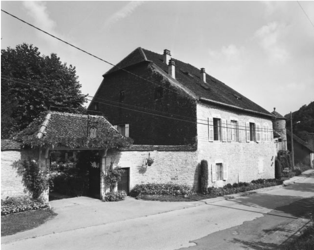
Bâtiment d'habitation vu depuis la rue. 39, Passenans Grande Rue
