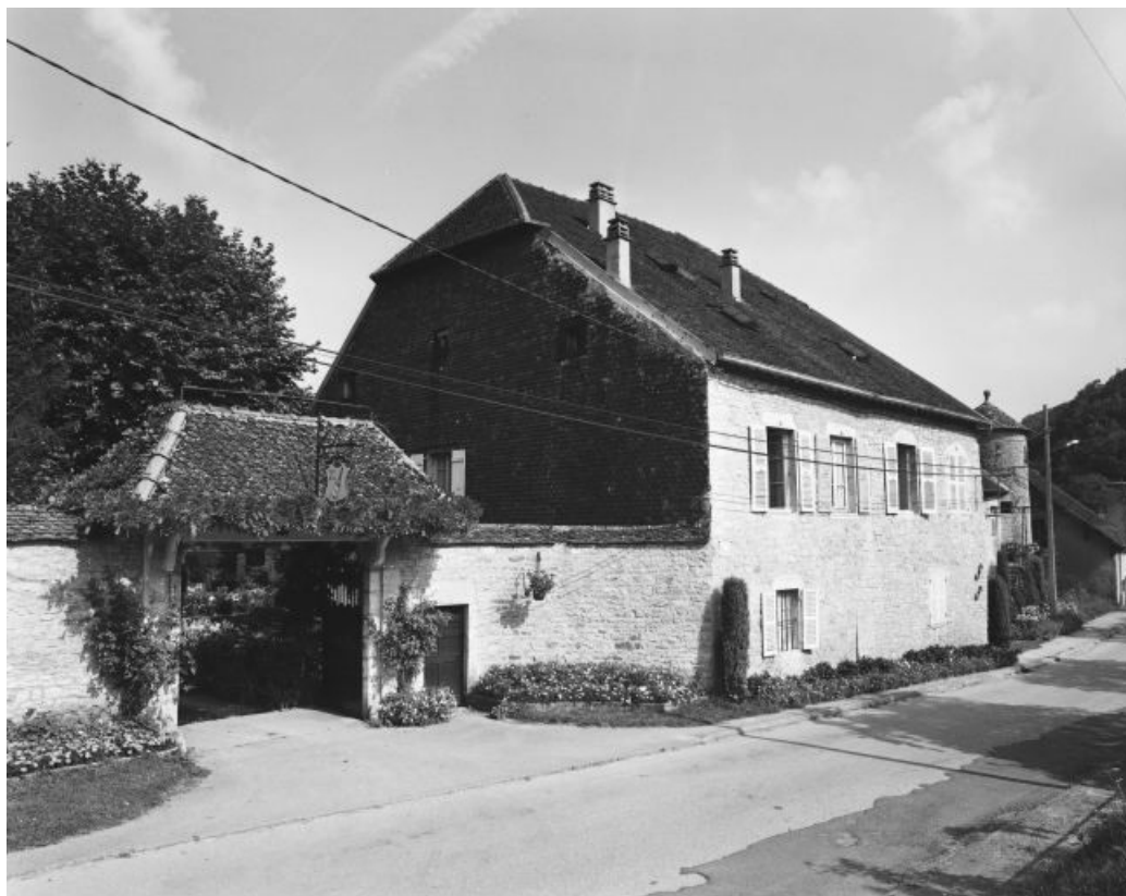
Bâtiment d'habitation vu depuis la rue.
