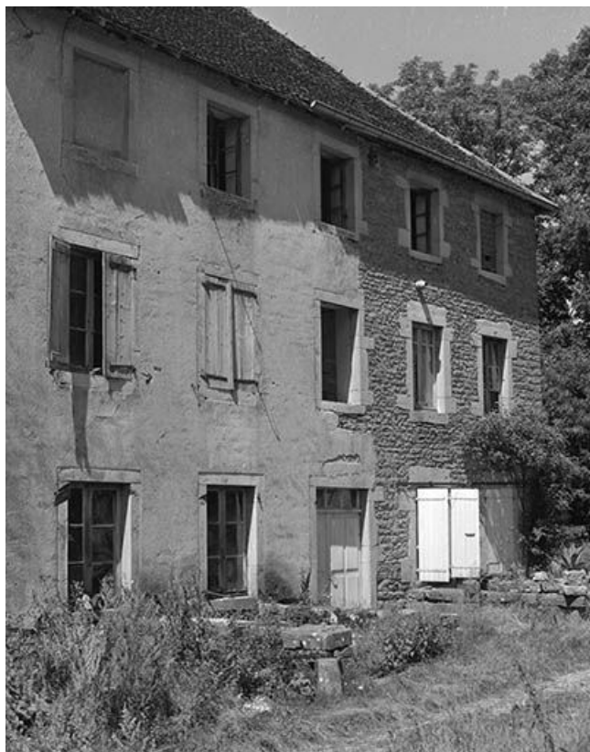
L'habitation : façade sur cour, détail.
