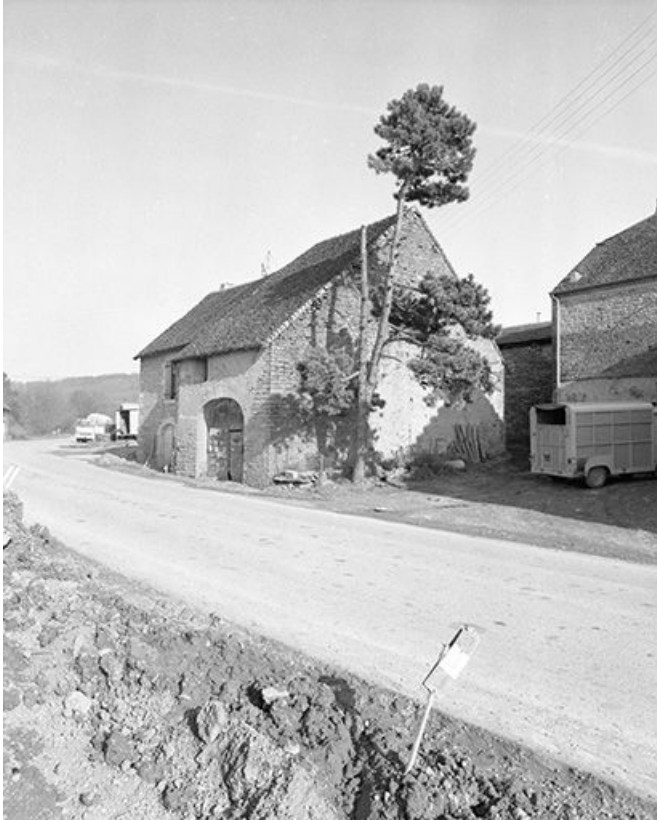
Ferme cadastrée 1959 AI 92 : vue de trois quarts droit. 39, Mantry
