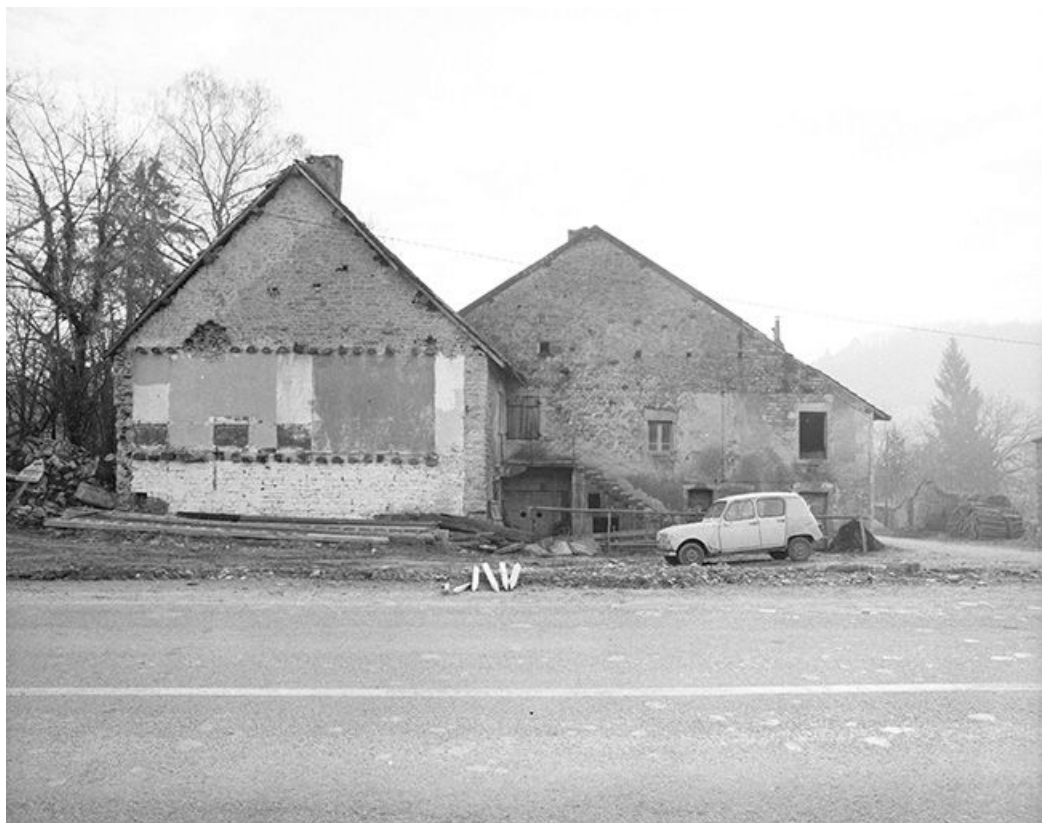
Ferme située au lieudit Montchauvrot, cadastrée 1959 AC 94 : façade sur rue prise au cours des travaux routiers de l'hiver 1974-1975.
