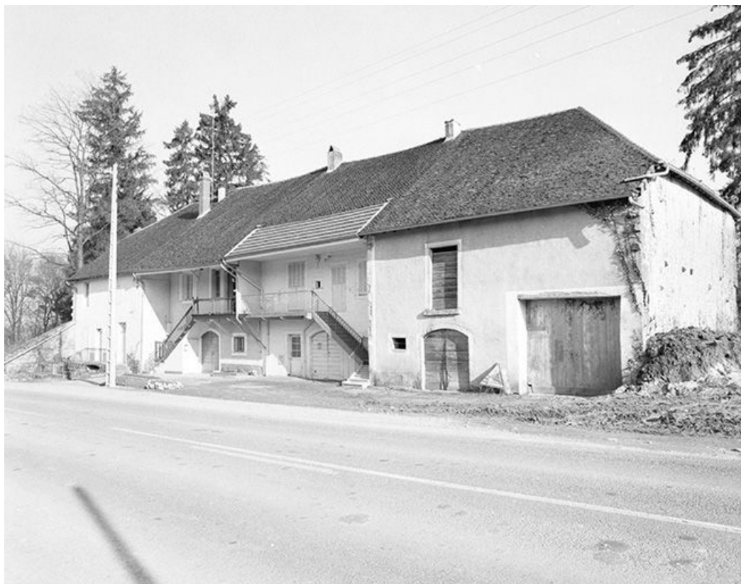
Ferme situées au lieudit Montchauvrot, cadastrée 1959 AC 58 : vue d'ensemble. 39, Mantry
