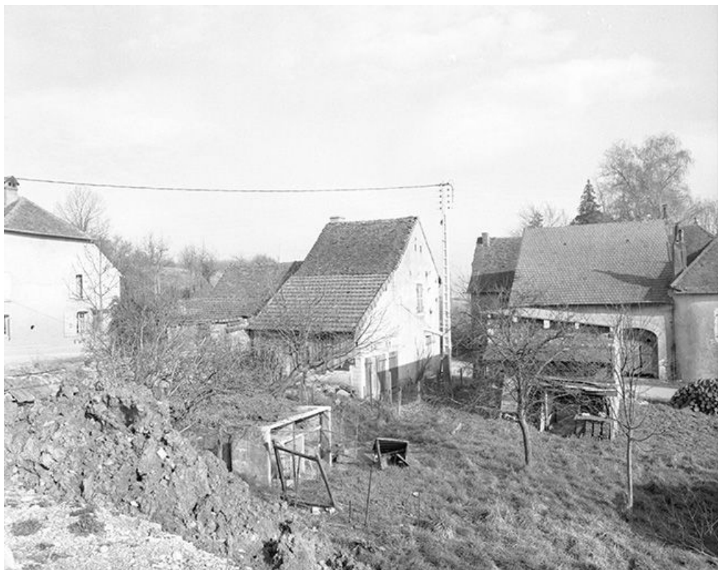
Ferme située au lieudit Montchauvrot, cadastrée 1959 AC 140-141 : façade postérieure. 39, Mantry
