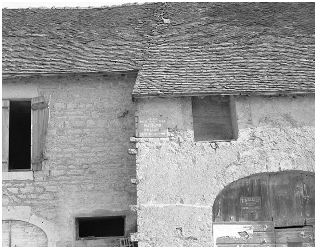
Ferme cadastrée 1959 AI 92 : détail de la façade antérieure. 39, Mantry
