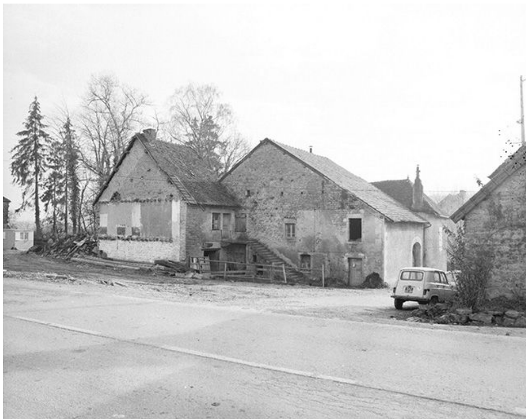
Ferme située au lieudit Montchauvrot, cadastrée 1959 AC 94 : vue de trois quarts droit, prise au cours des travaux routiers de l'hiver 1974-1975.
