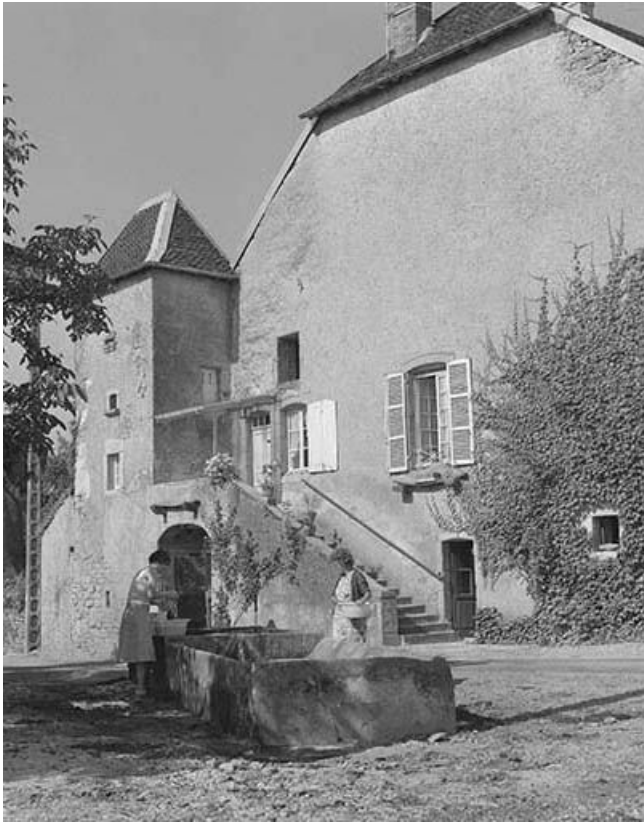
Élévation sur la rue : partie gauche.
