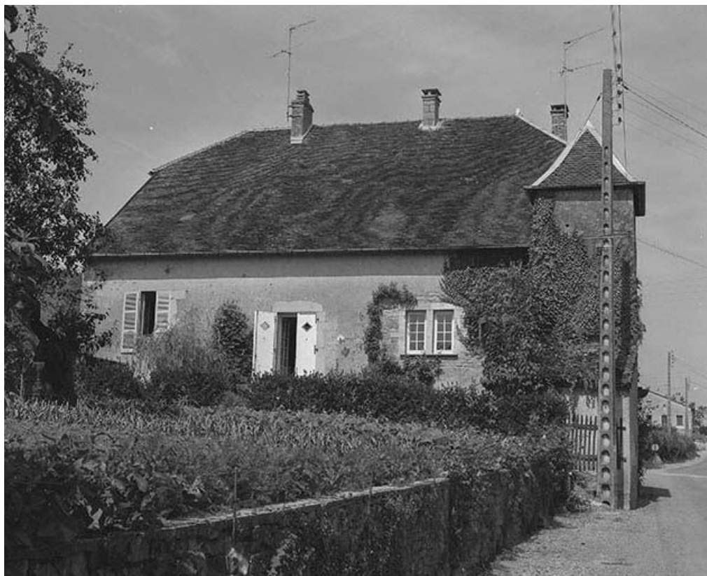
Élévation sur la rue : vue de trois quarts droit.
