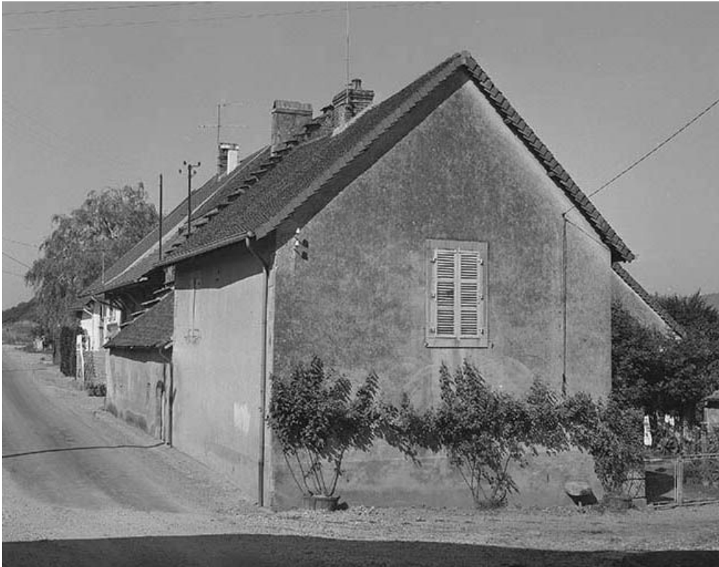
Pignon de l'habitation.
