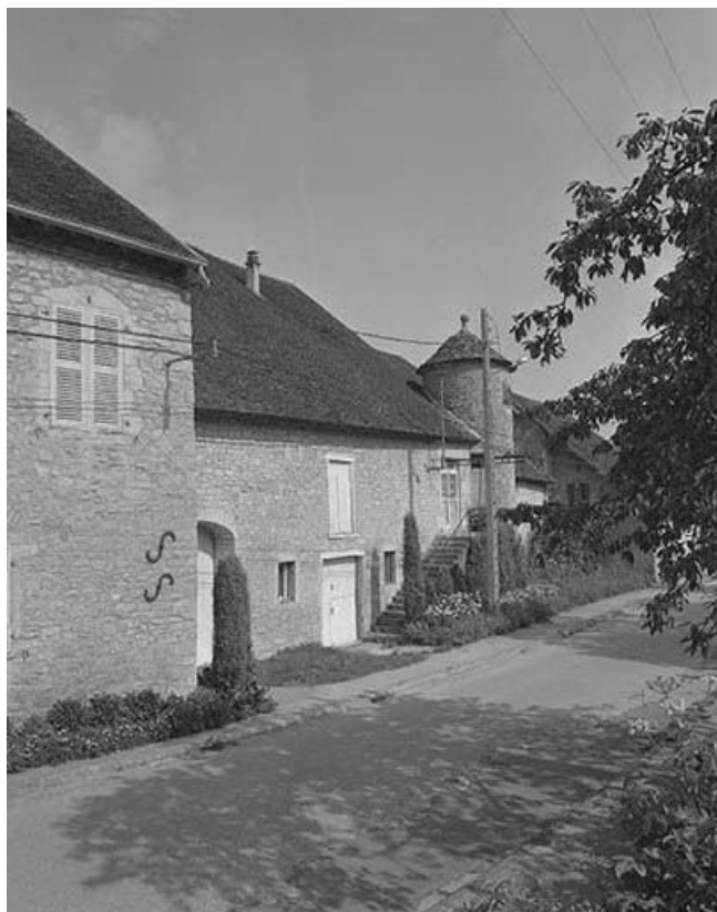
Façade sur rue, partie gauche.
