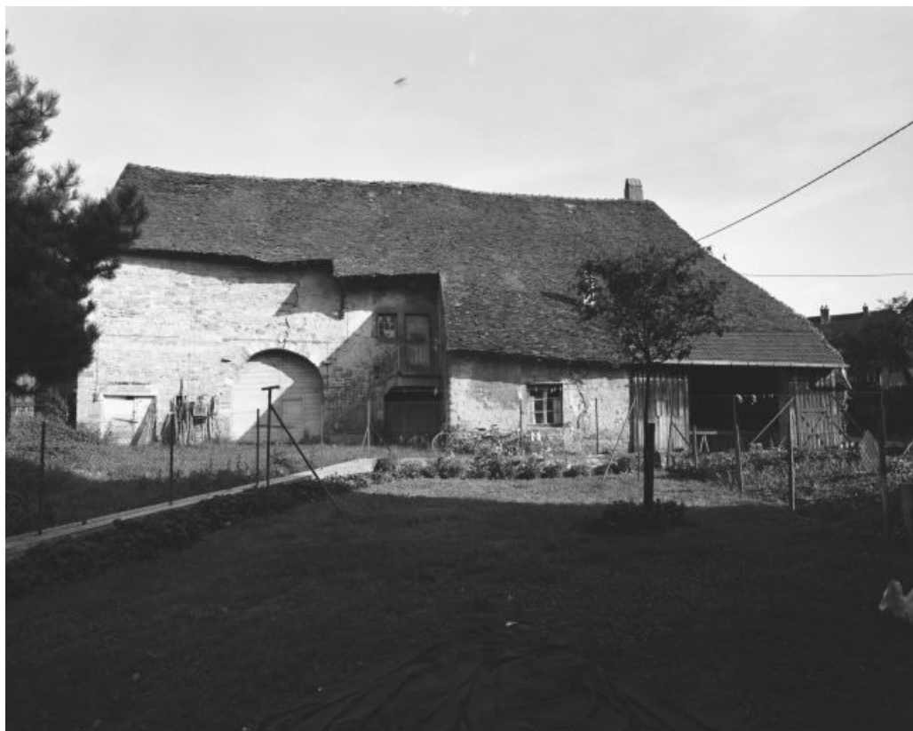
Façade antérieure vue de face.
