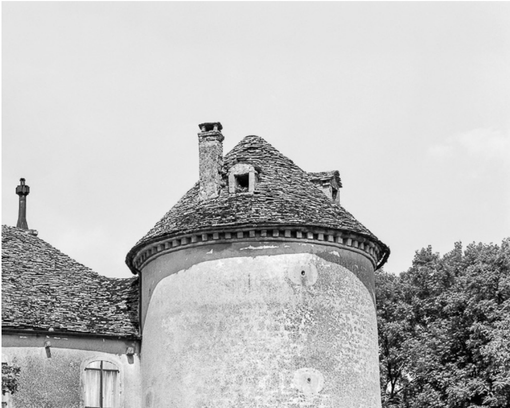
Tour de l'angle sud-est : partie supérieure.
