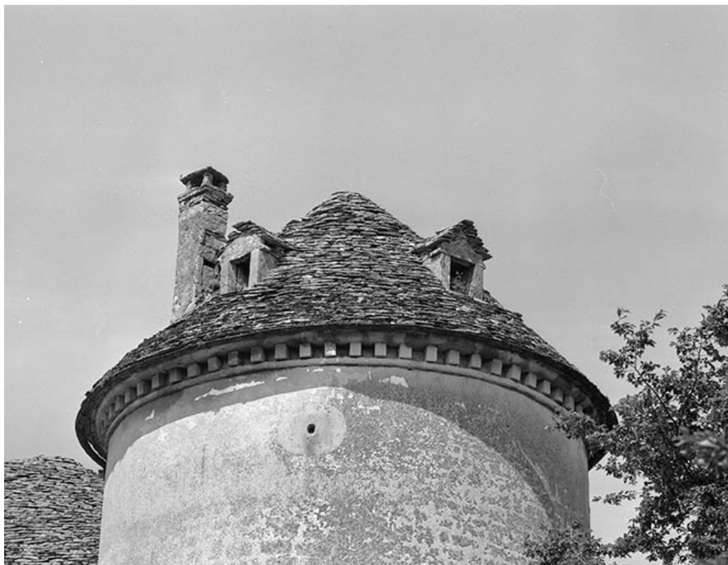
Tour de l'angle Sud-Est, partie supérieure.
