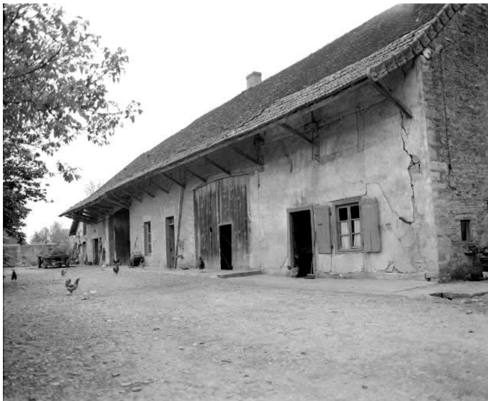
Façade antérieure, vue générale.
