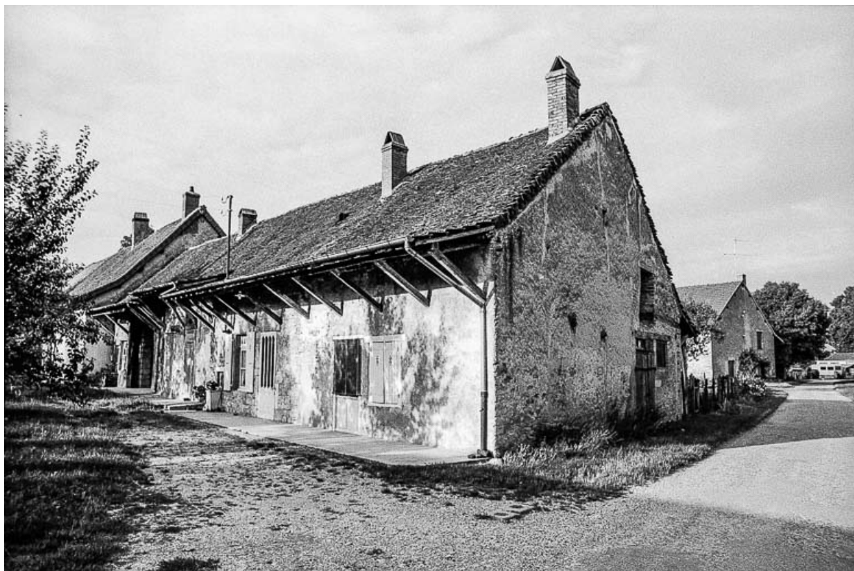
Ferme cadastrée 1949 B1 91 : façades antérieure et latérale droite. 39, Villevieux
