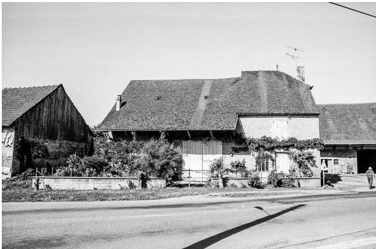
Ferme cadastrée 1949 B1 305 : façade antérieure. 39, Villevieux
