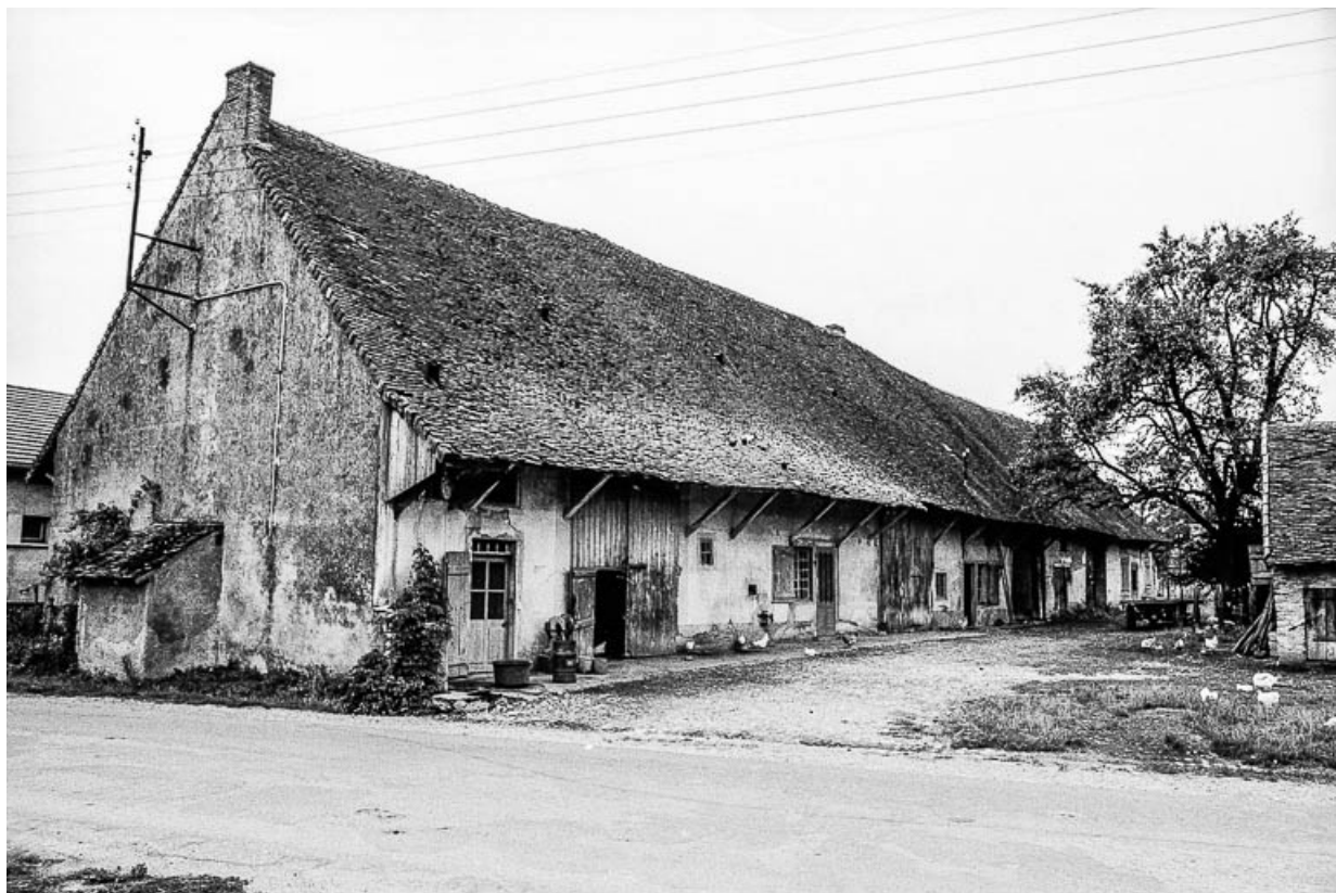
Ferme cadastrée 1949 B1 299 et 301 : façade postérieure. 39, Villevieux
