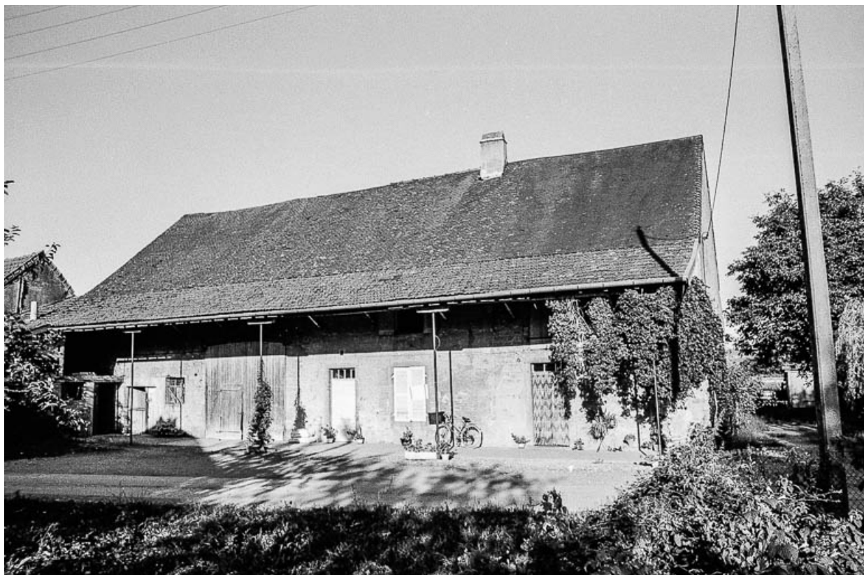
Ferme cadastrée 1949 B1 70 située impasse de la Seillette (?) : façade antérieure. 39, Villevieux
