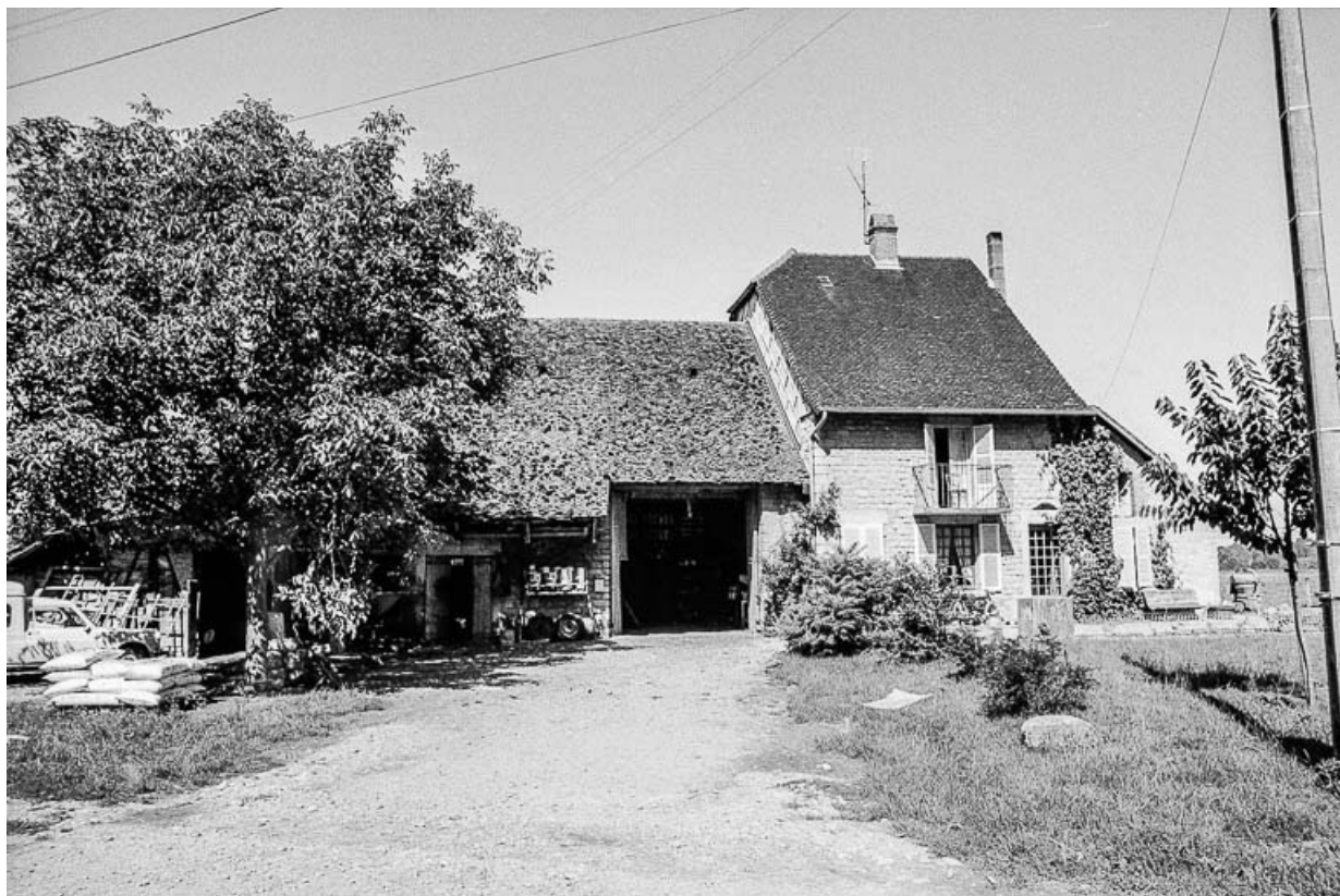
Ferme située rue le Pont Boudot : façade antérieure. 39, Villevieux
