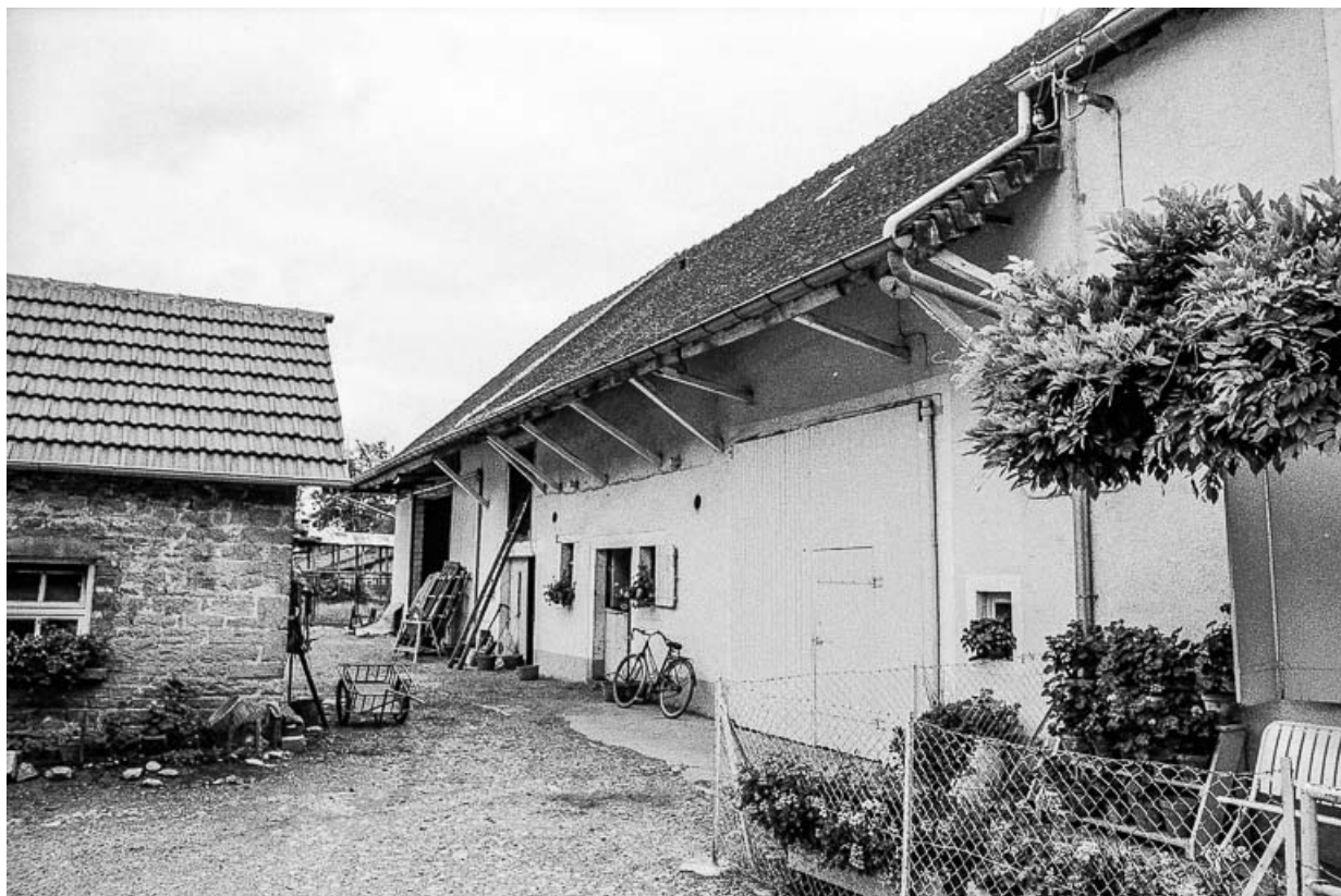
Ferme cadastrée 1949 B1 258, située rue du Bout du Gué : façade antérieure (partie gauche). 39, Villevieux
