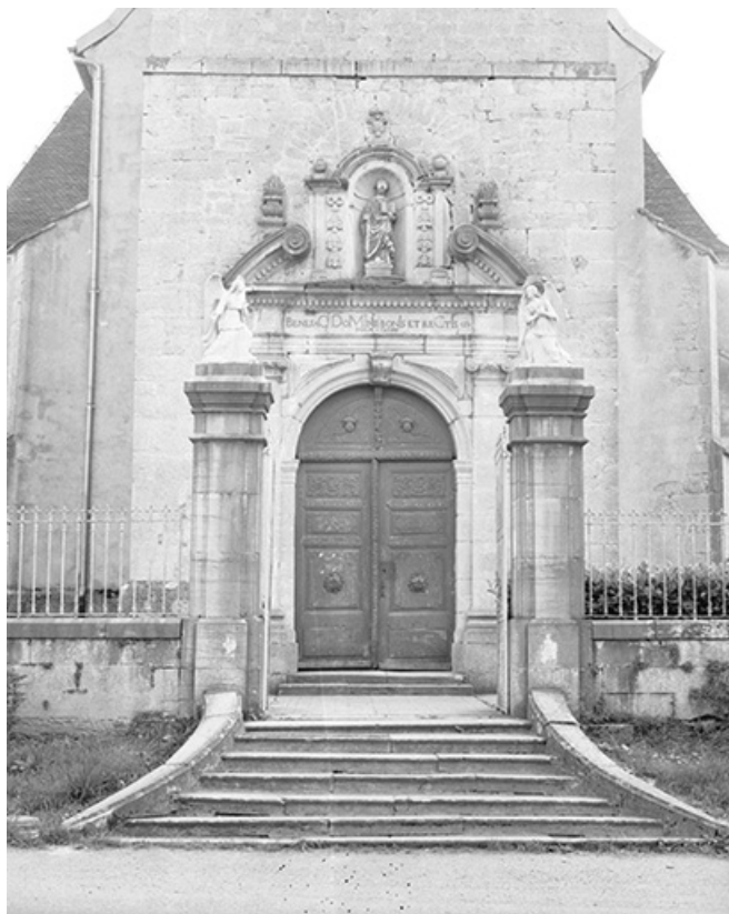
Façade antérieure et portail.
