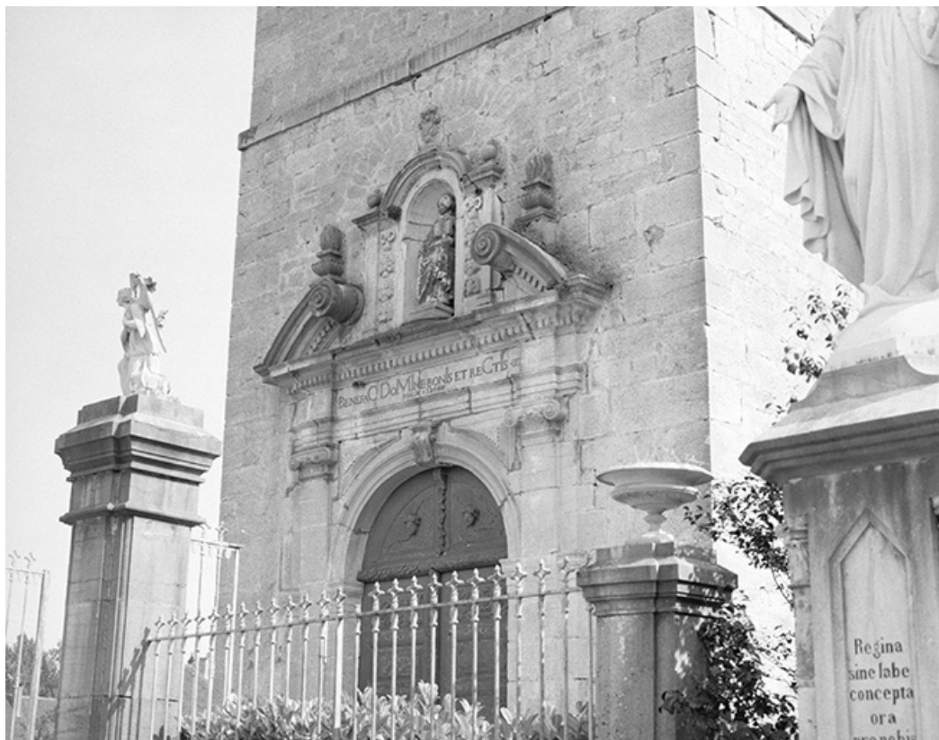
Façade antérieure, portail, partie supérieure.
