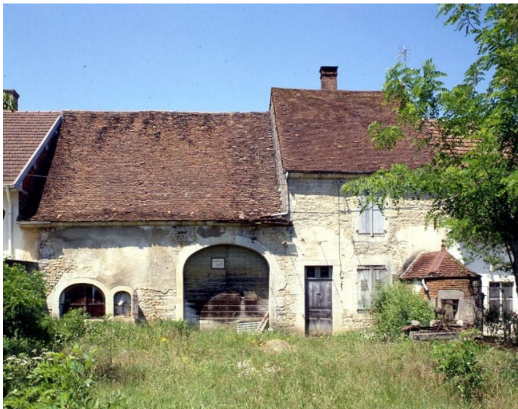
Façade antérieure vue de face en 1990.
