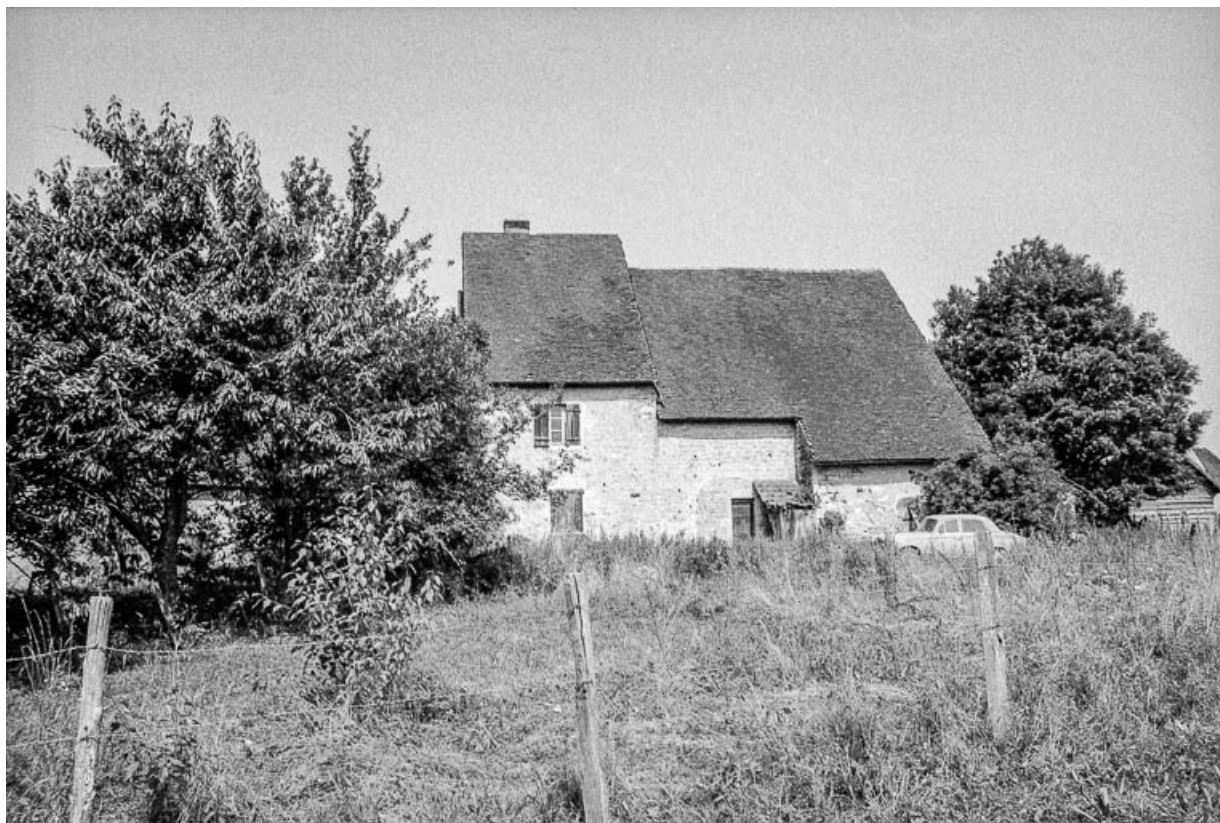
Façade postérieure en 1975.
