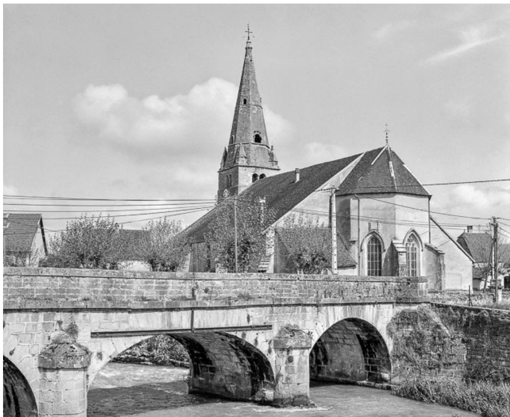
Extérieur : face latérale sud et abside.
