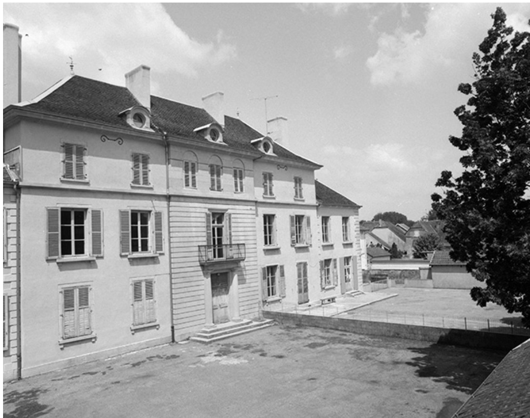
Façade postérieure en 1990.
