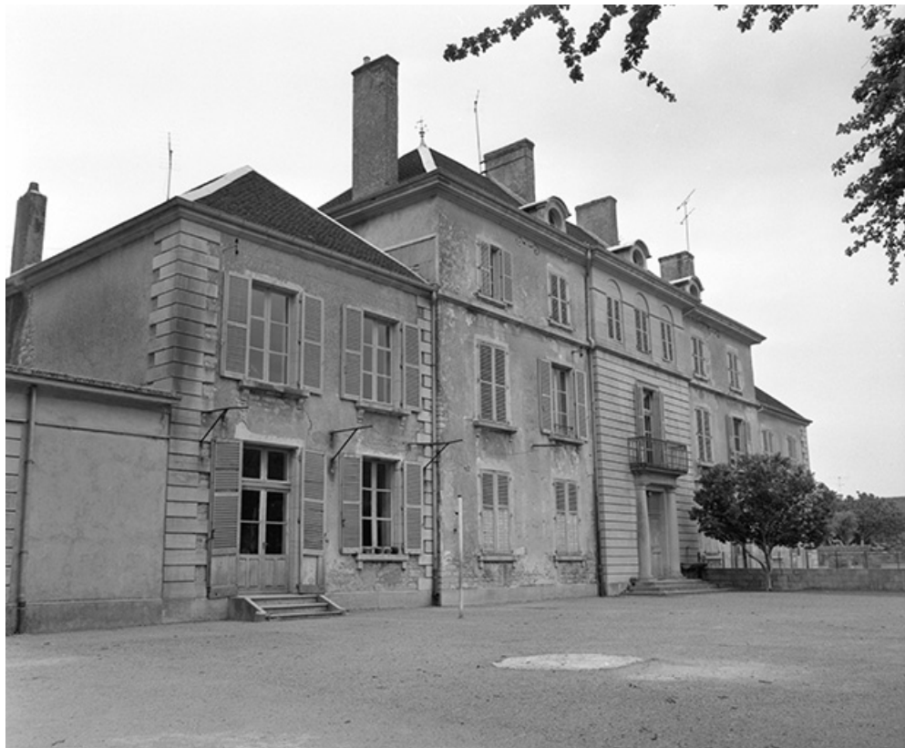
Façade postérieure en 1979.
