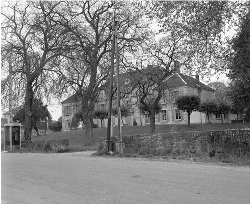
Façade postérieure en 1979.
