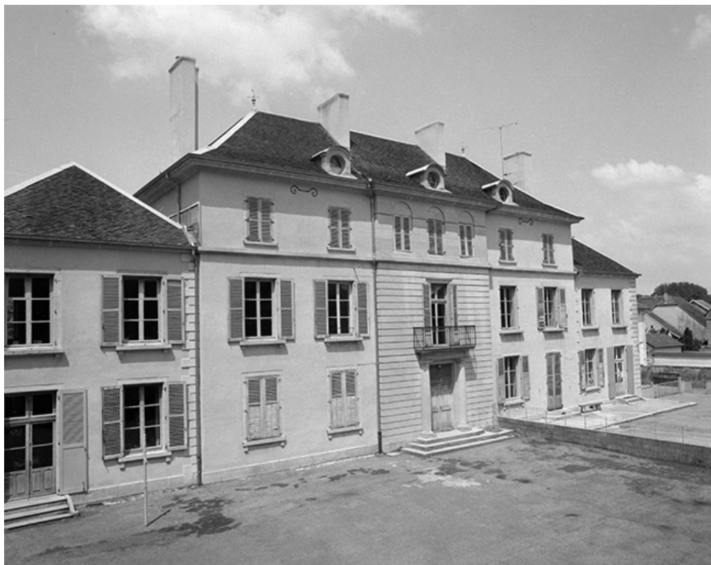
Façade postérieure en 1990.
