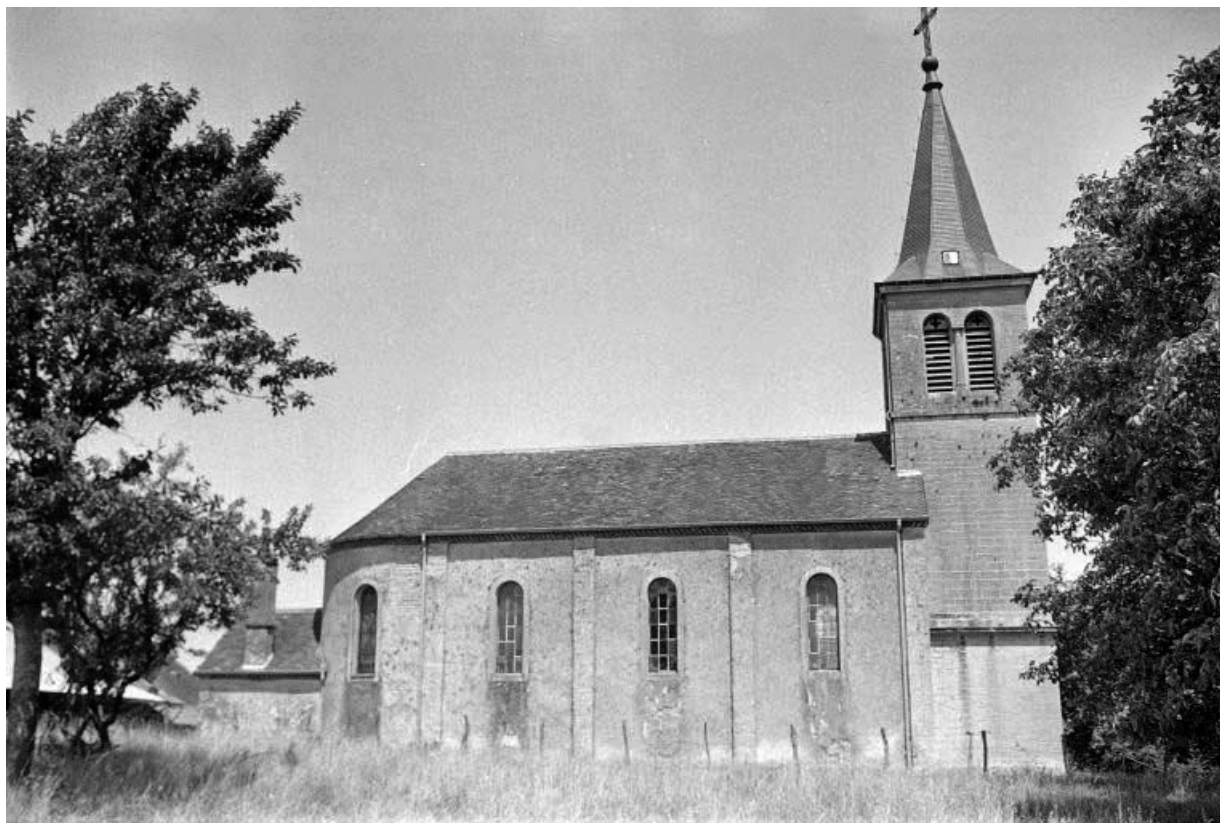
Façade latérale gauche : vue rapprochée.
