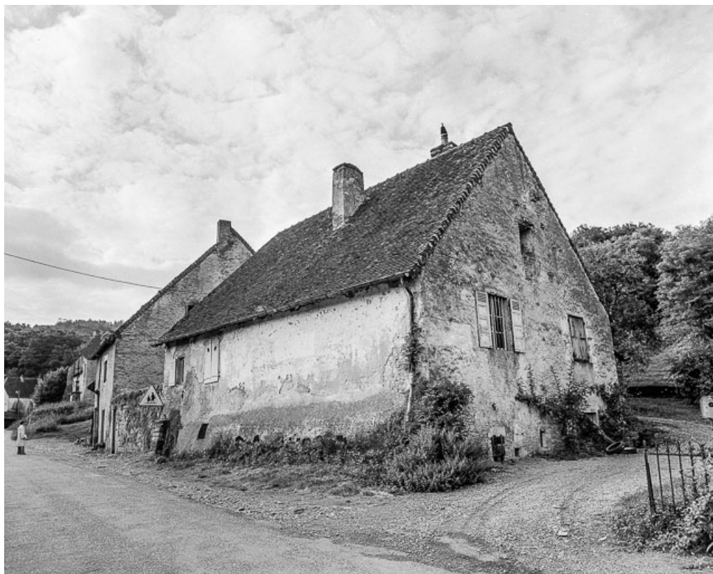
Façades postérieure et latérale gauche.
