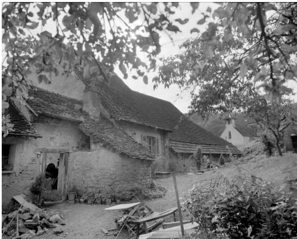
Partie droite de la façade postérieure.
