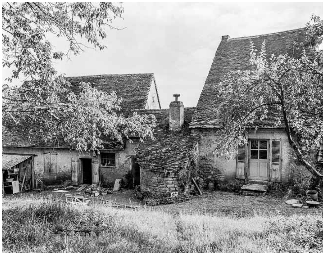
Partie gauche de la façade postérieure.
