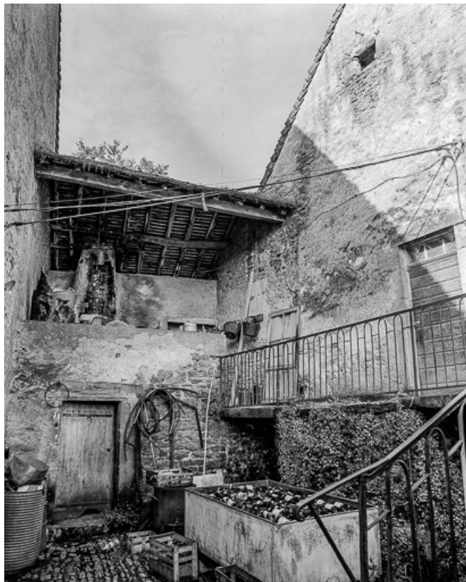
La cour entre les deux bâtiments.
