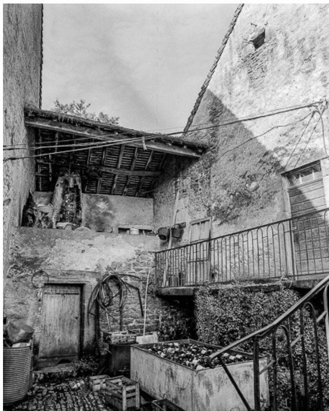
La cour entre les deux bâtiments.
