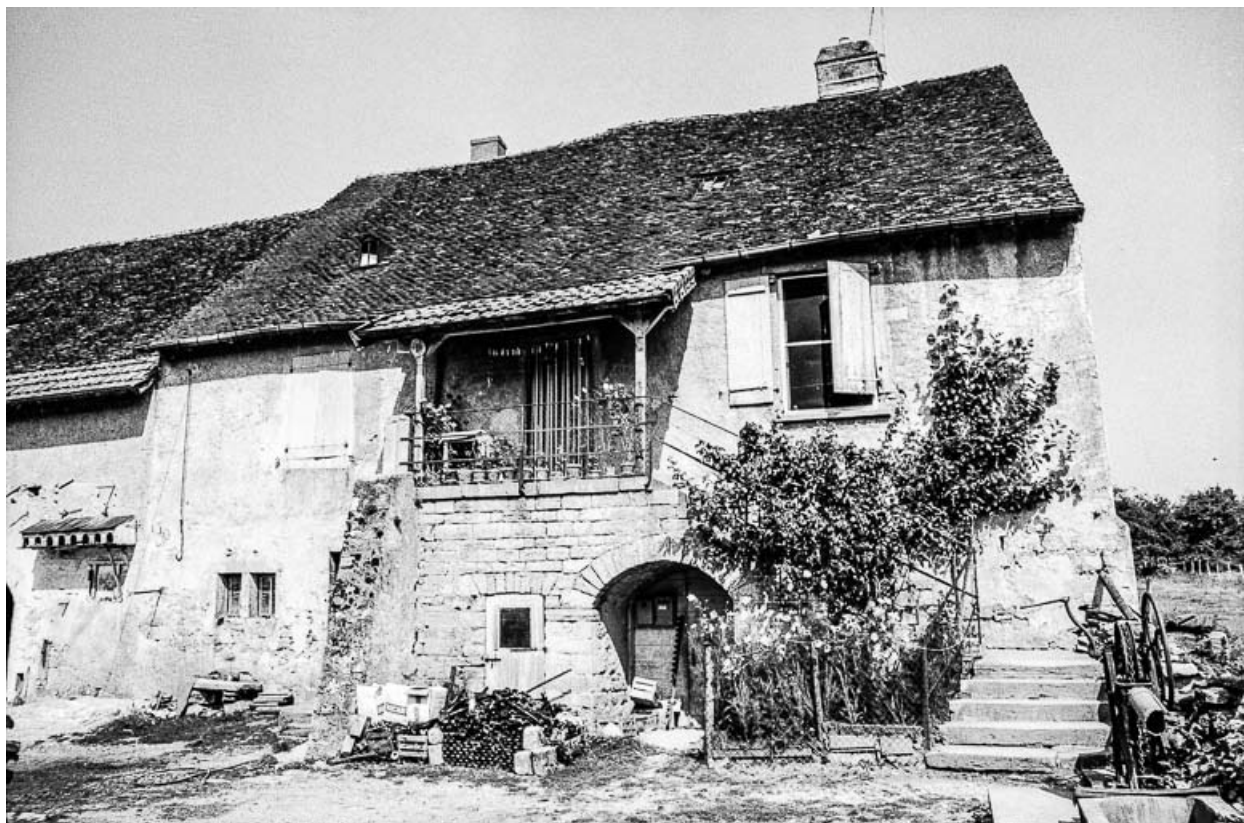
Façade antérieure : vue rapprochée.
