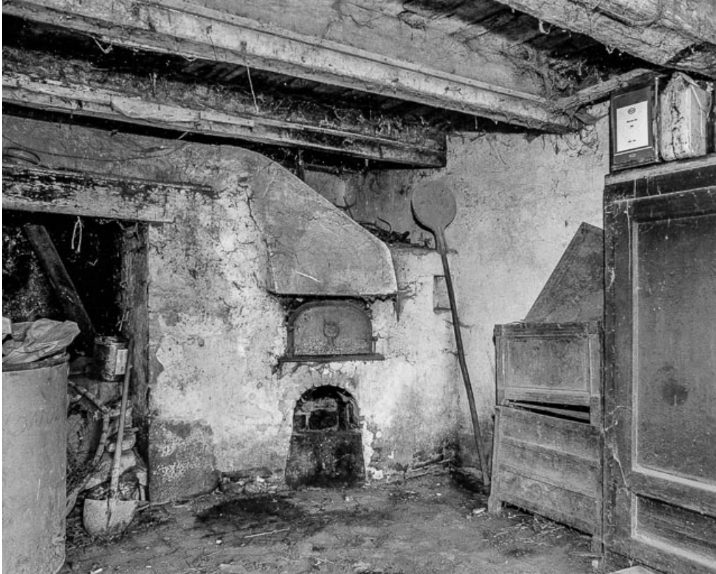
Le four au rez-de-chaussée de l'habitation.
