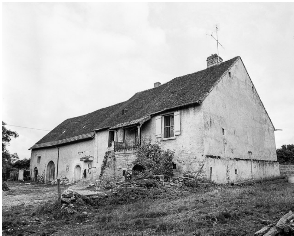
façade antérieure et face droite.
