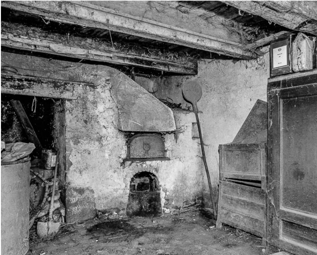
Le four au rez-de-chaussée de l'habitation.
