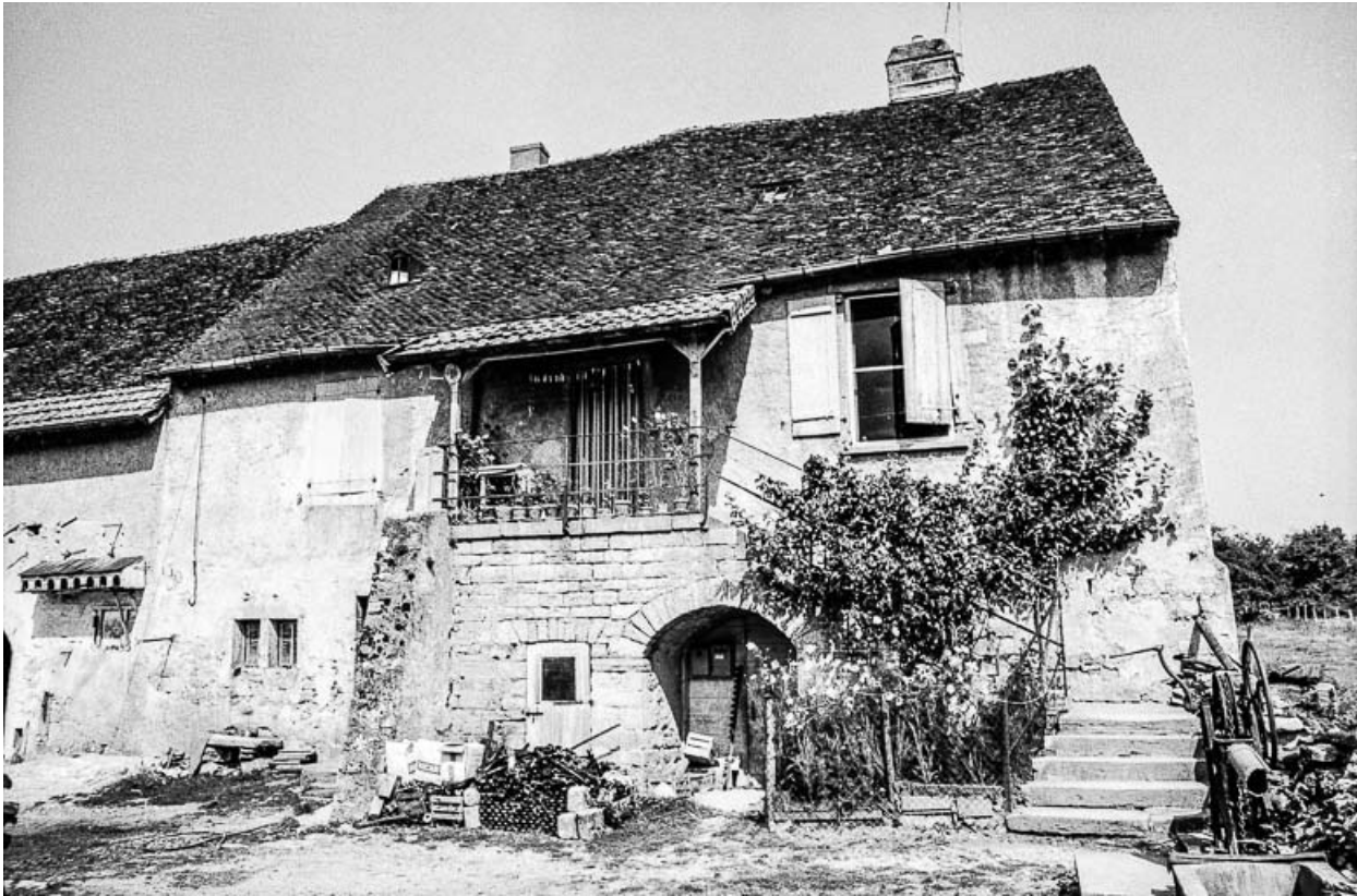
Façade antérieure : vue rapprochée. 39, Quintigny rue Charles Nodier
