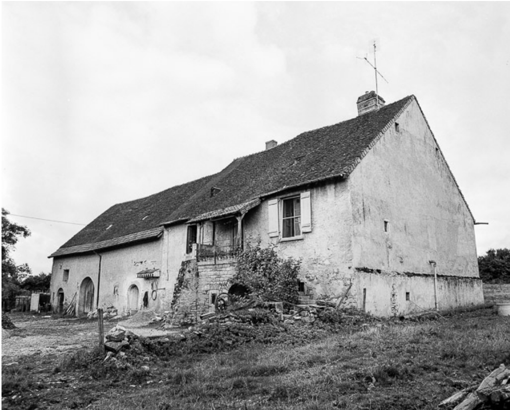
façade antérieure et face droite.
