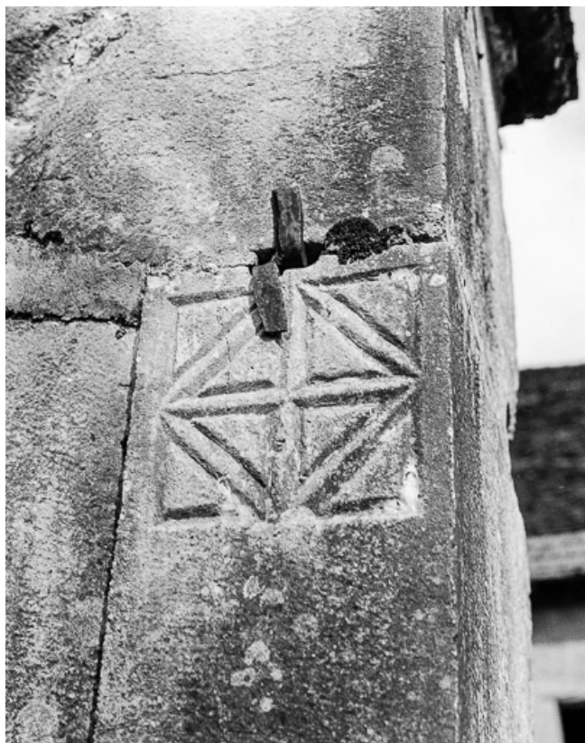
Détail : décor du pilier du portail d'entrée.
