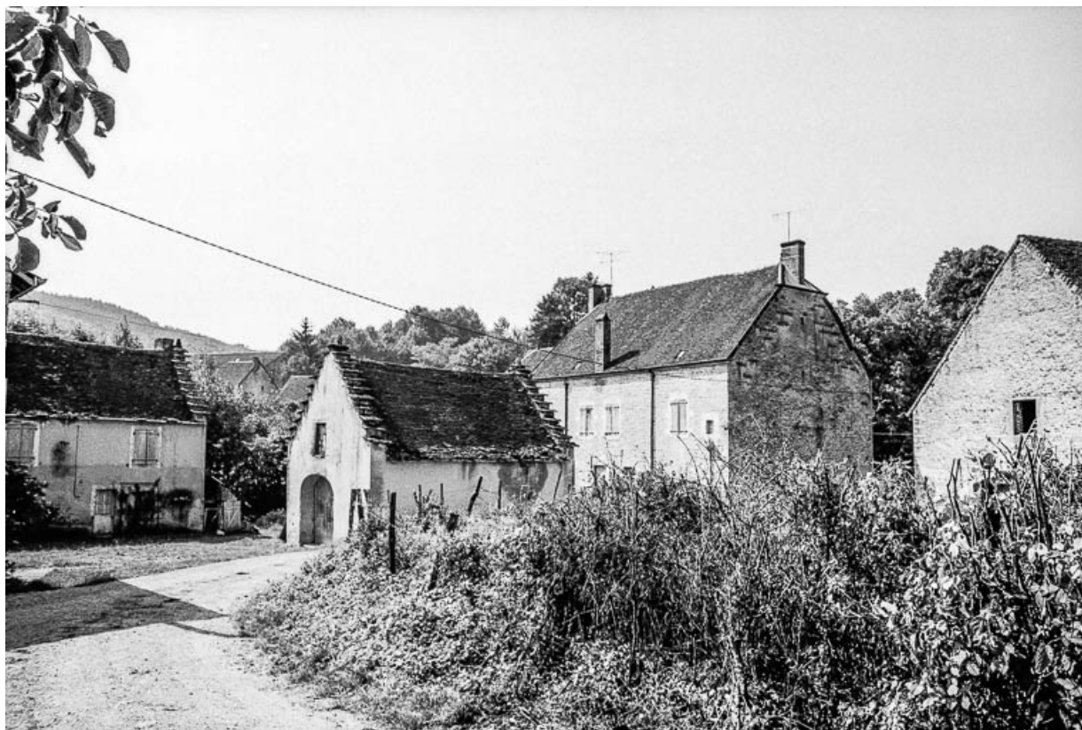
Maison cadastrée 1964 AC 182 : vue d'ensemble.
