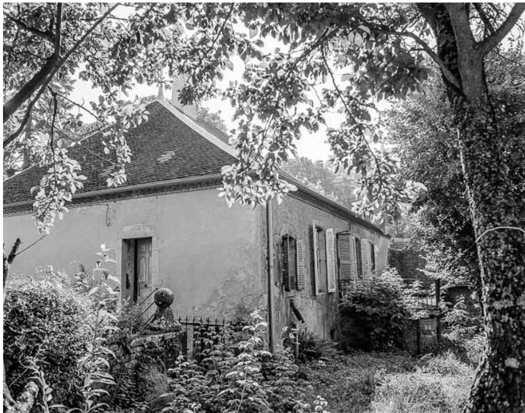
Maison de maître : façade postérieure vue de trois quarts. 39, Quintigny
