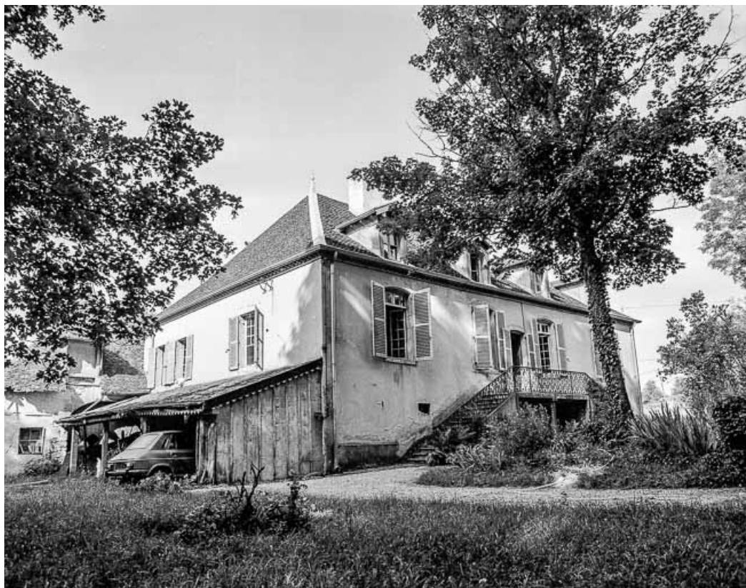
Maison de maître : façade antérieure vue de trois quarts droit.
