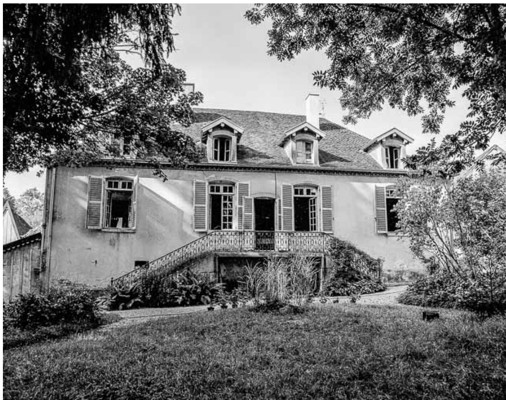
Maison de maître : façade antérieure. 39, Quintigny
