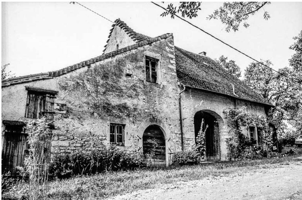
Ferme cadastrée 1964 AC 48 : vue d'ensemble. 39, Quintigny
