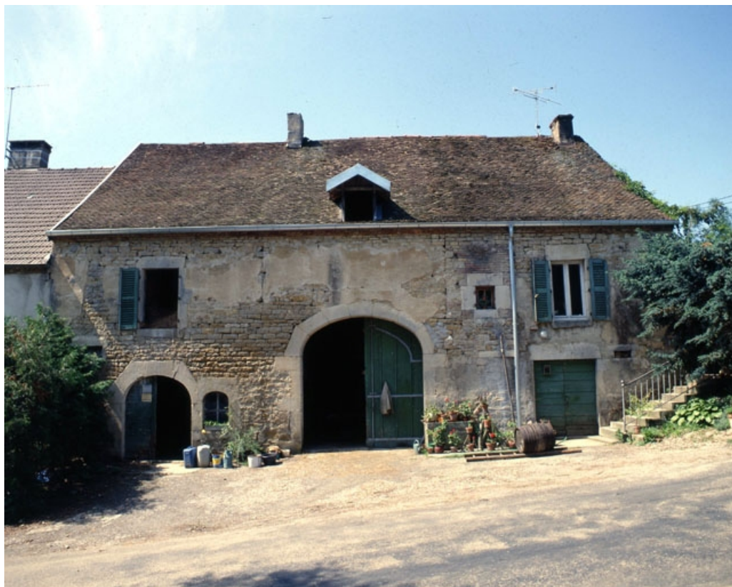
Maison de vigneron située au nord-ouest du village : façade antérieure. 39, Quintigny
