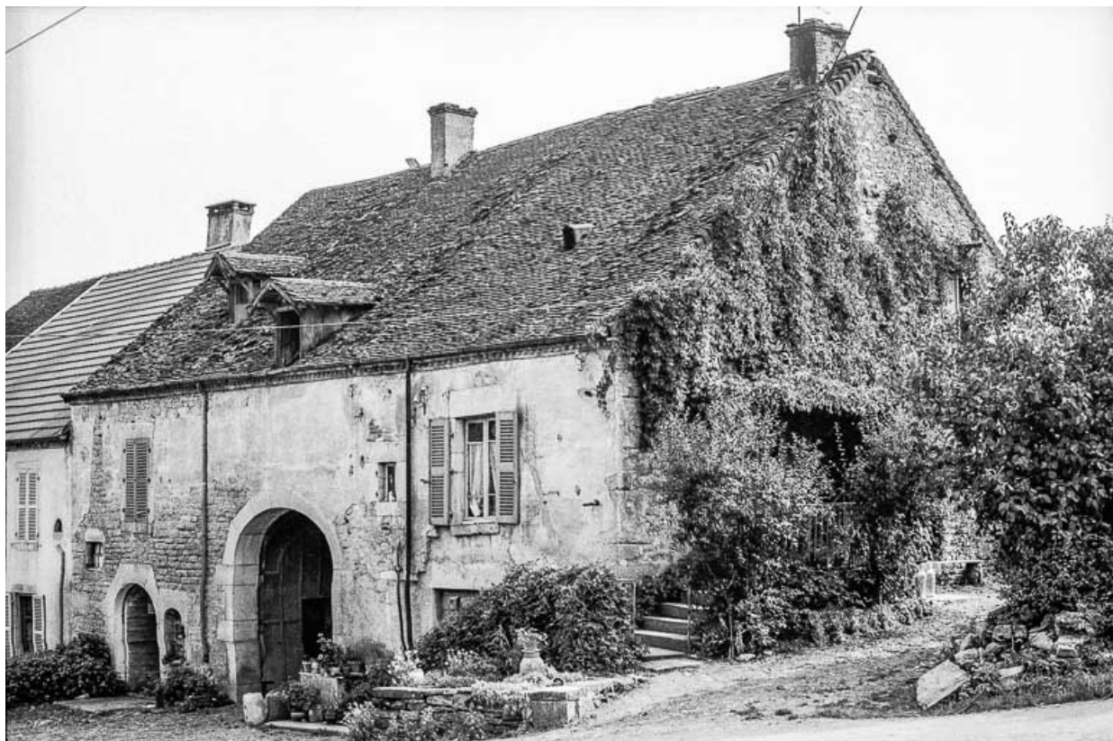
Ferme cadastrée 1964 AC 54 : façades antérieure et latérale droite. 39, Quintigny
