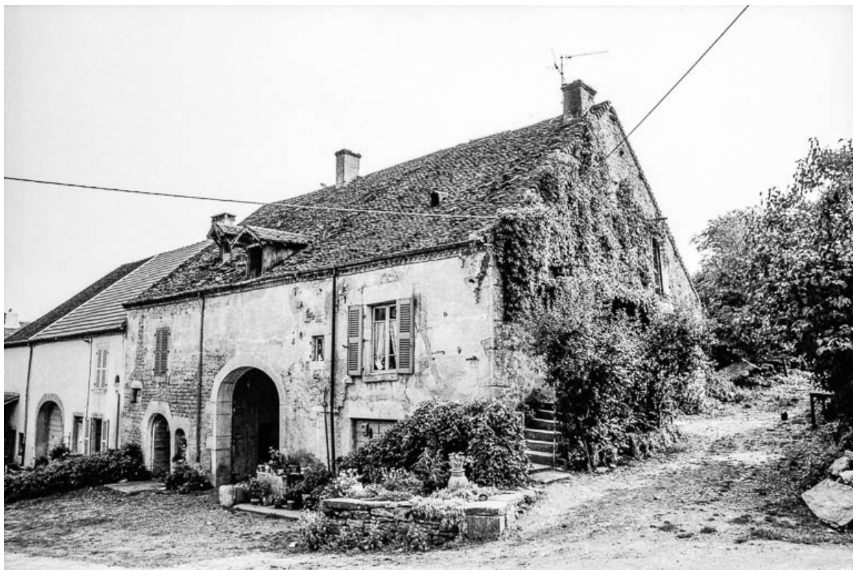
Ferme cadastrée 1964 AC 54 : vue d'ensemble. 39, Quintigny
