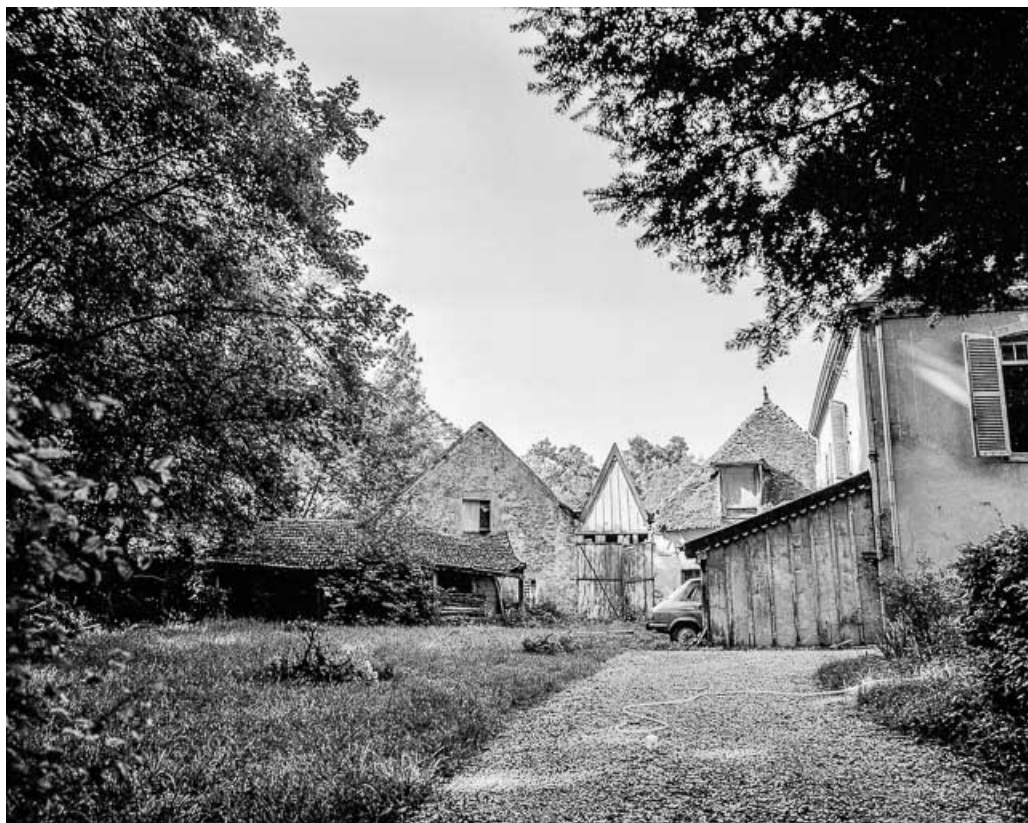
Maison de maître : bâtiments annexes. 39, Quintigny
