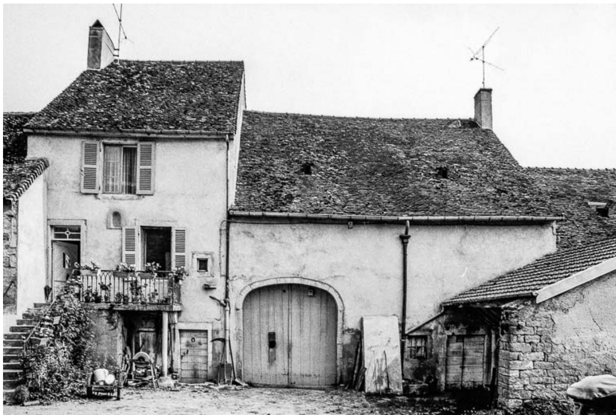
Ferme cadastrée 1964 AC 90 (droite) : façade antérieure. 39, Quintigny
