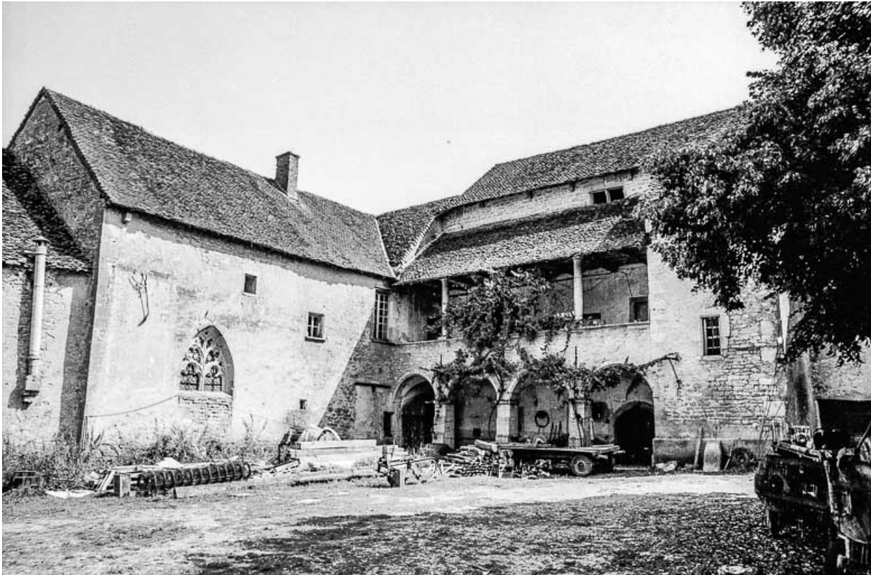
Galerie du corps de logis et partie comprenant une chapelle. 39, Quintigny
