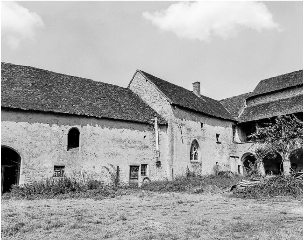
Chapelle, élévation sur cour.
