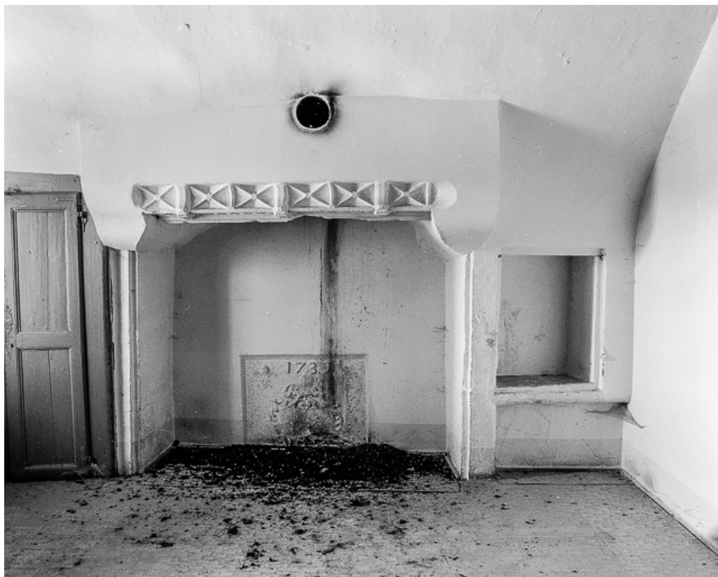
Corps de logis, cheminée.
