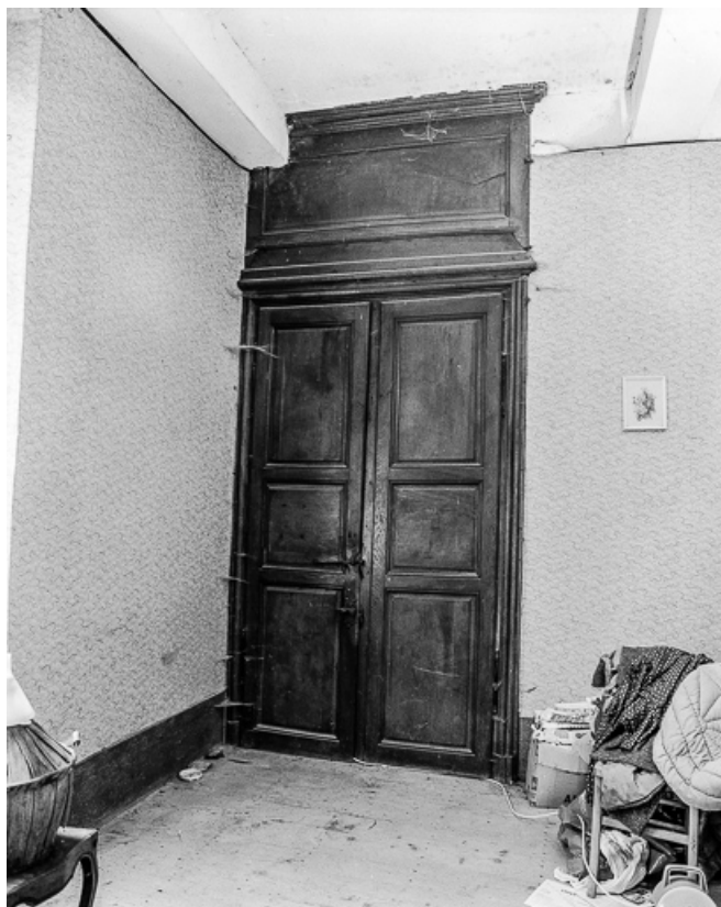
Corps de logis, détail d'une porte intérieure. 39, Quintigny
