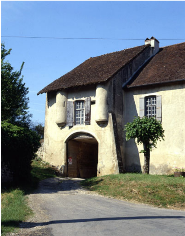
Bâtiment d'entrée : porche.
