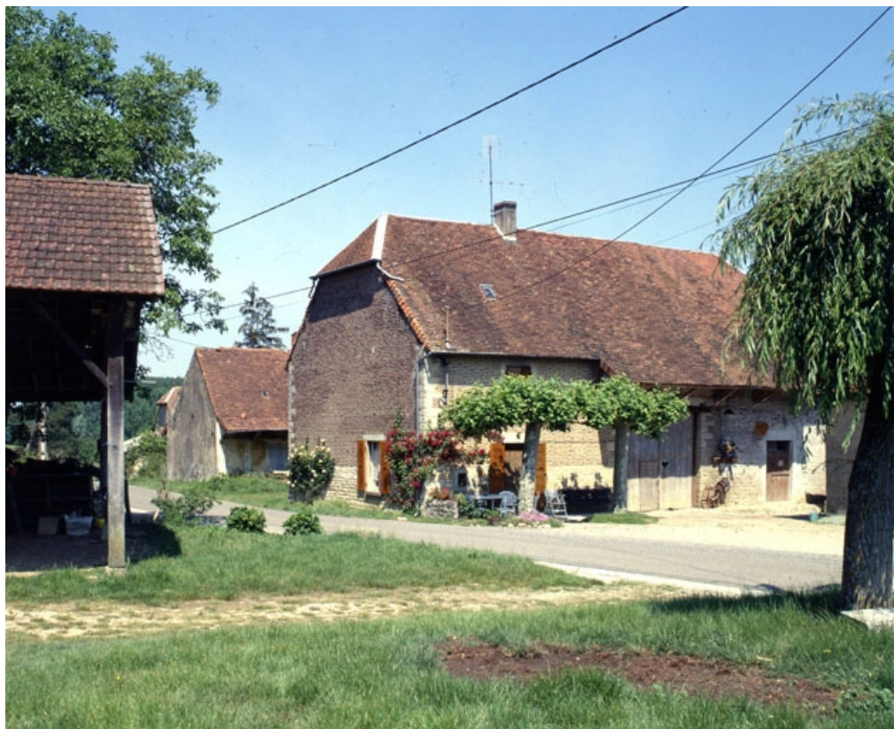
Façades antérieure et latérale gauche.
