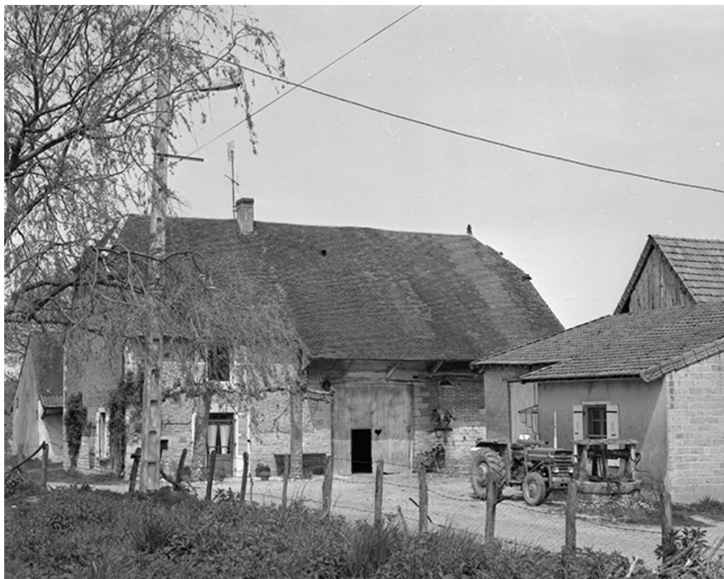
Façade antérieure et bâtiment agricole.
