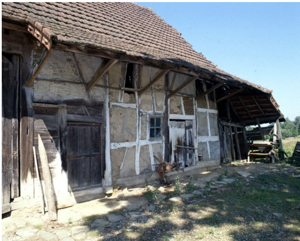
Façade antérieure : partie droite en pan de bois et en brique.
