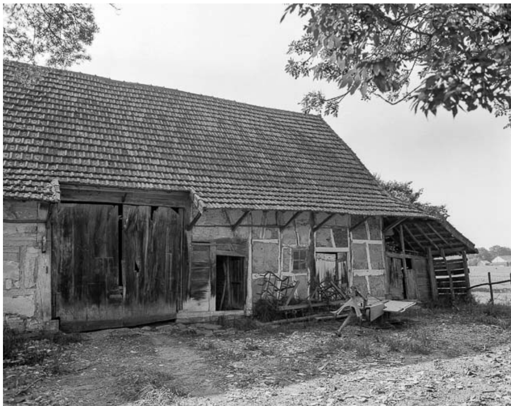
Façade antérieure : partie droite.
