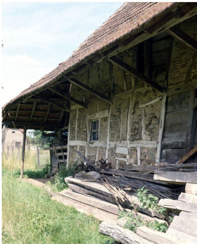
Façade postérieure en pan de bois et en brique.
