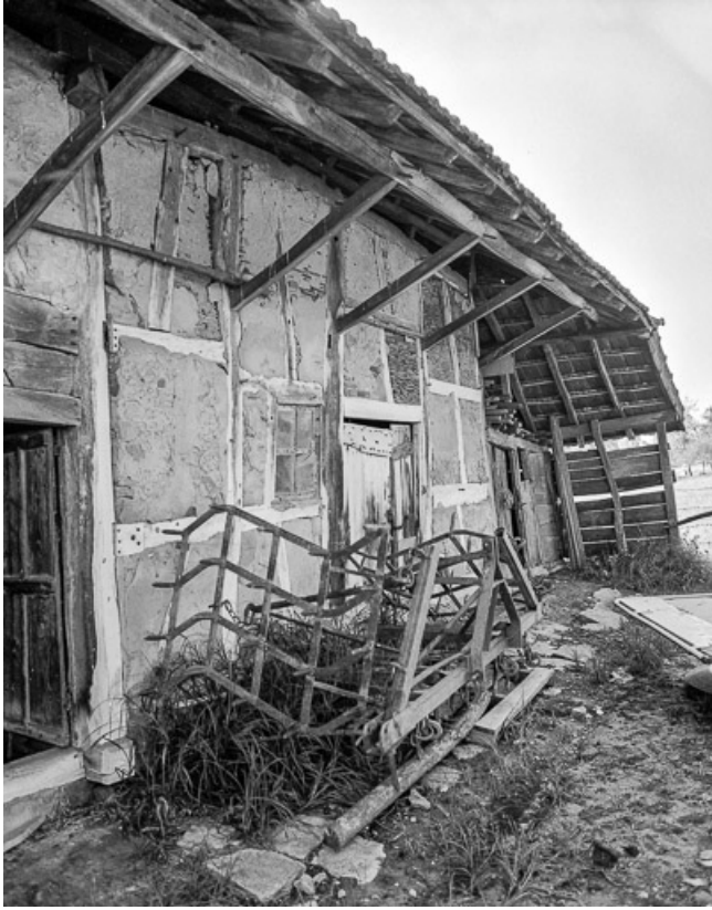
Façade antérieure : partie droite.
