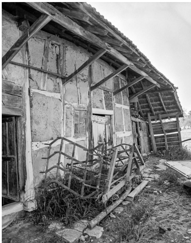
Façade antérieure : partie droite.
