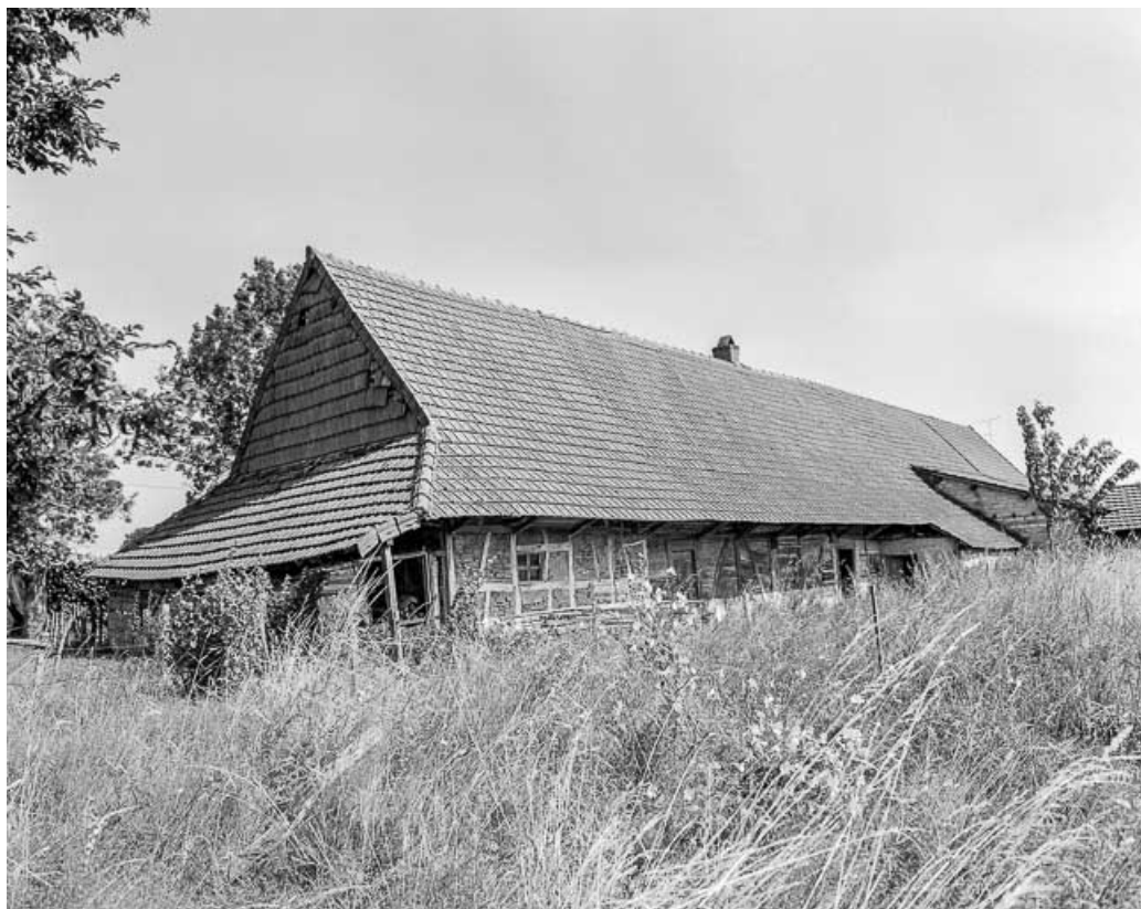
Façade postérieure et côté gauche.
