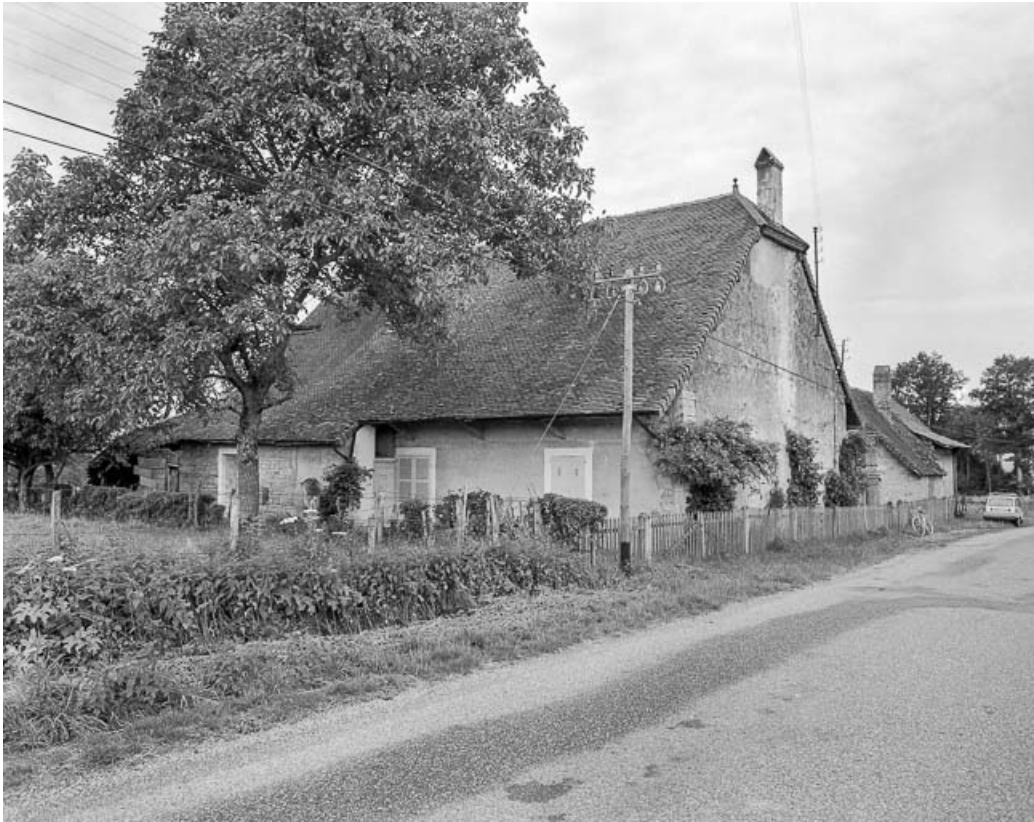
Vue d'ensemble depuis la cour (appentis et pignon droit). 39, Larnaud
