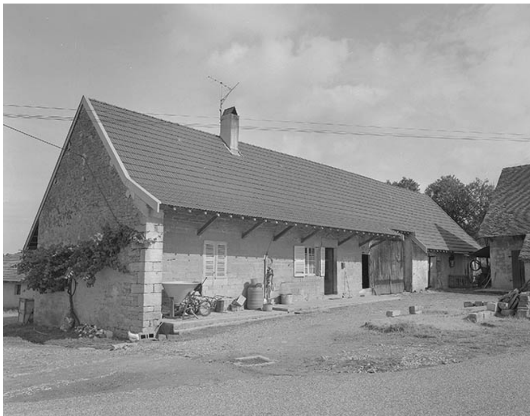
Façade antérieure vue de trois-quarts gauche.
