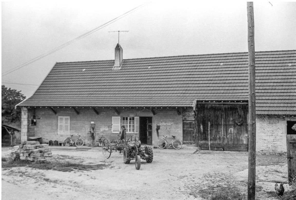
Façades antérieure vue de face.
