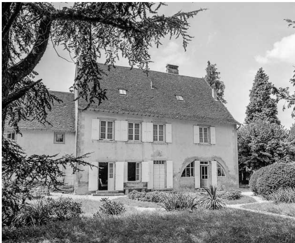
Ferme n° 16 : façade postérieure, partie gauche. 39, Larnaud
