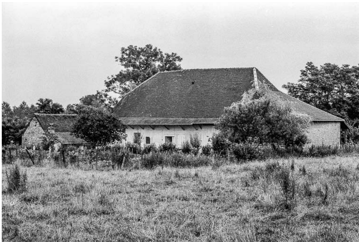
Ferme cadastrée 1969 AB 106-107 : façade antérieure 39, Larnaud
