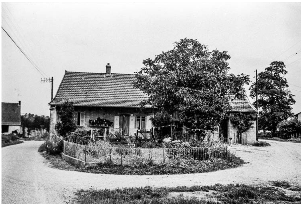
Ferme cadastrée 1969 AD 96 : façade antérieure.
