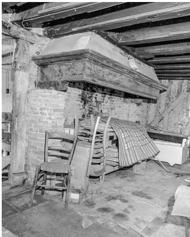
Ferme n° 16 : cheminée de la pièce d'habitation. 39, Larnaud
