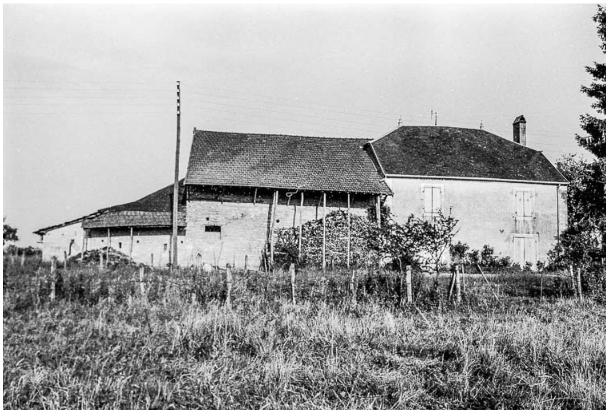
Ferme cadastrée 1969 AD 171-172 : façade postérieure. 39, Larnaud
