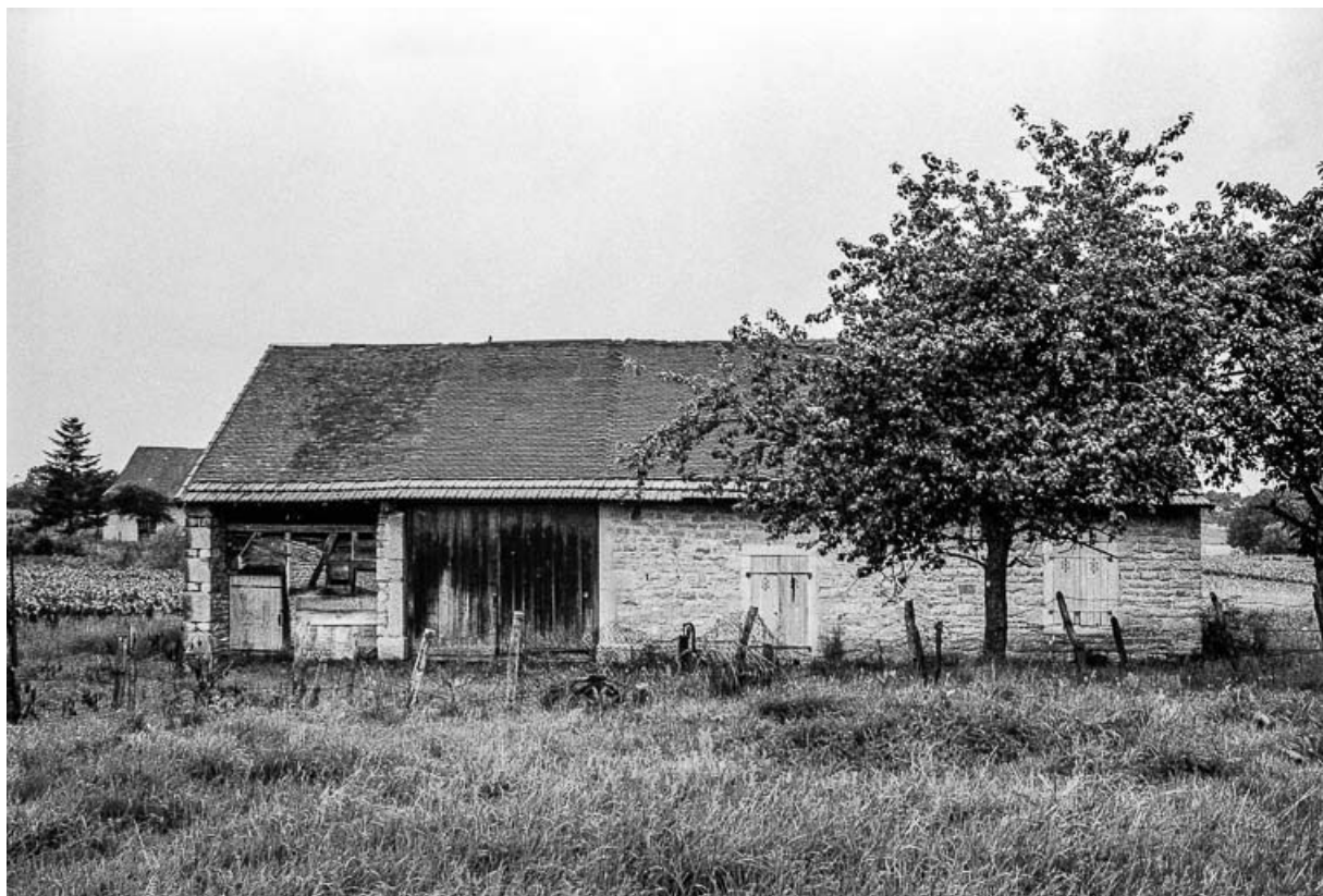
Ferme cadastrée 1969 AI 154 : façade antérieure.
