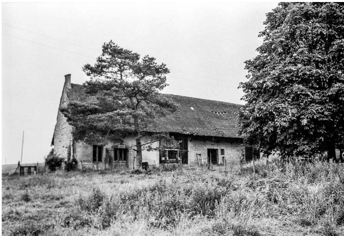
Ferme cadastrée 1969 AL 20 : façade antérieure. 39, Larnaud
