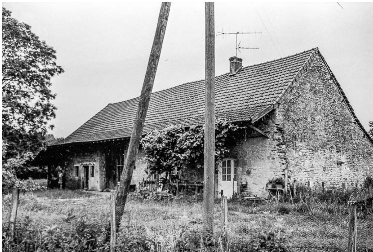
Ferme cadastrée 1969 AD 96 : façades antérieure et latérale droite. 39, Larnaud
