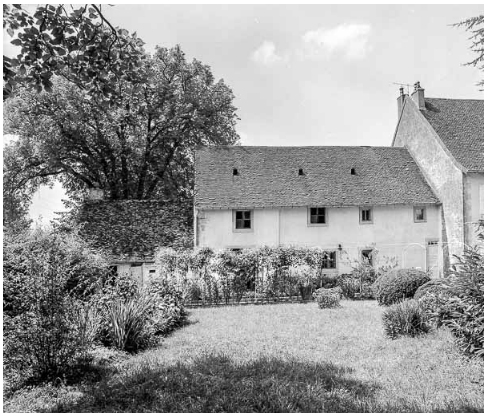
Ferme n° 16 : façade postérieure, partie droite. 39, Larnaud
