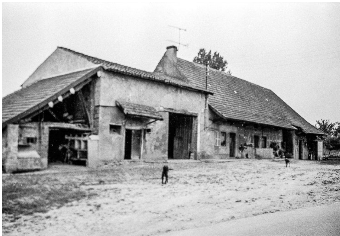
Ferme cadastrée 1969 AM 8 : façade antérieure. 39, Larnaud
