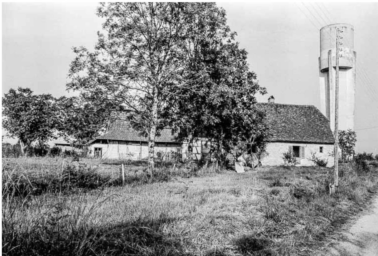
Ferme cadastrée 1969 AD 52 : façade postérieure. Le château d'eau est au fond, à droite. 39, Larnaud
