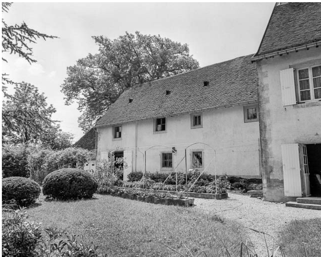
Ferme n° 16 : façade postérieure. 39, Larnaud
