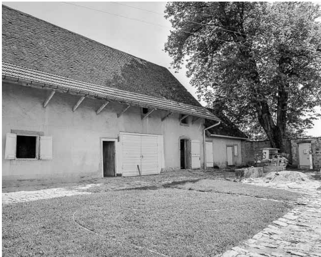
Ferme n° 16 : façade antérieure, partie droite. 39, Larnaud
