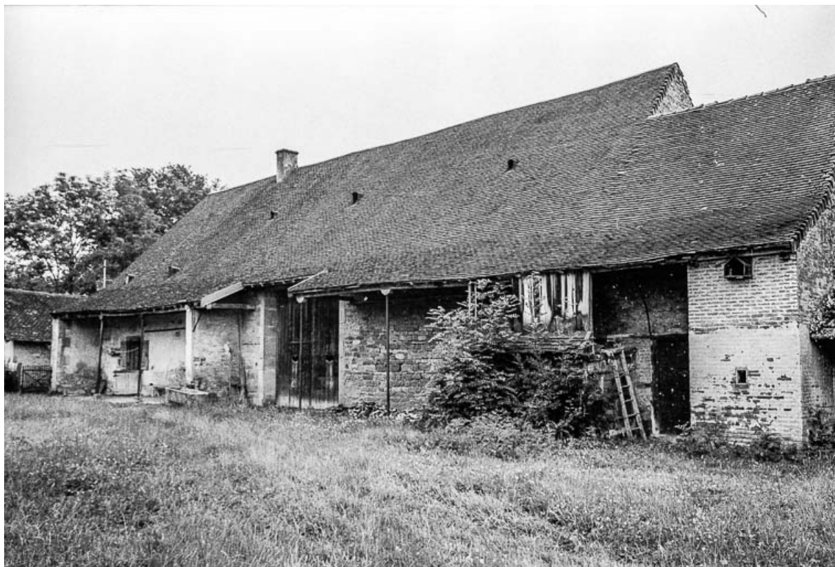
ferme cadastrée 1969 AB 111-112 : façade antérieure. 39, Larnaud
