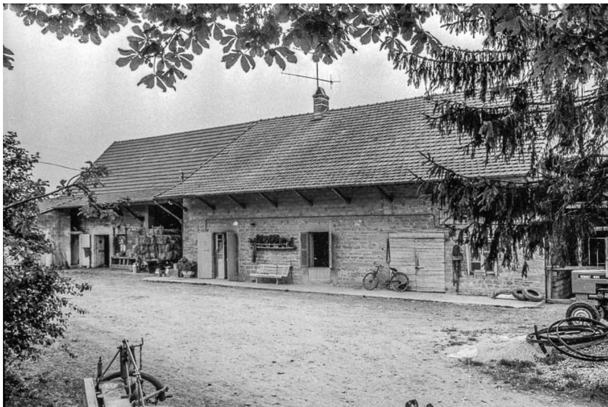
Ferme cadastrée 1969 AD 206-207 : bâtiment agricole. 39, Larnaud
