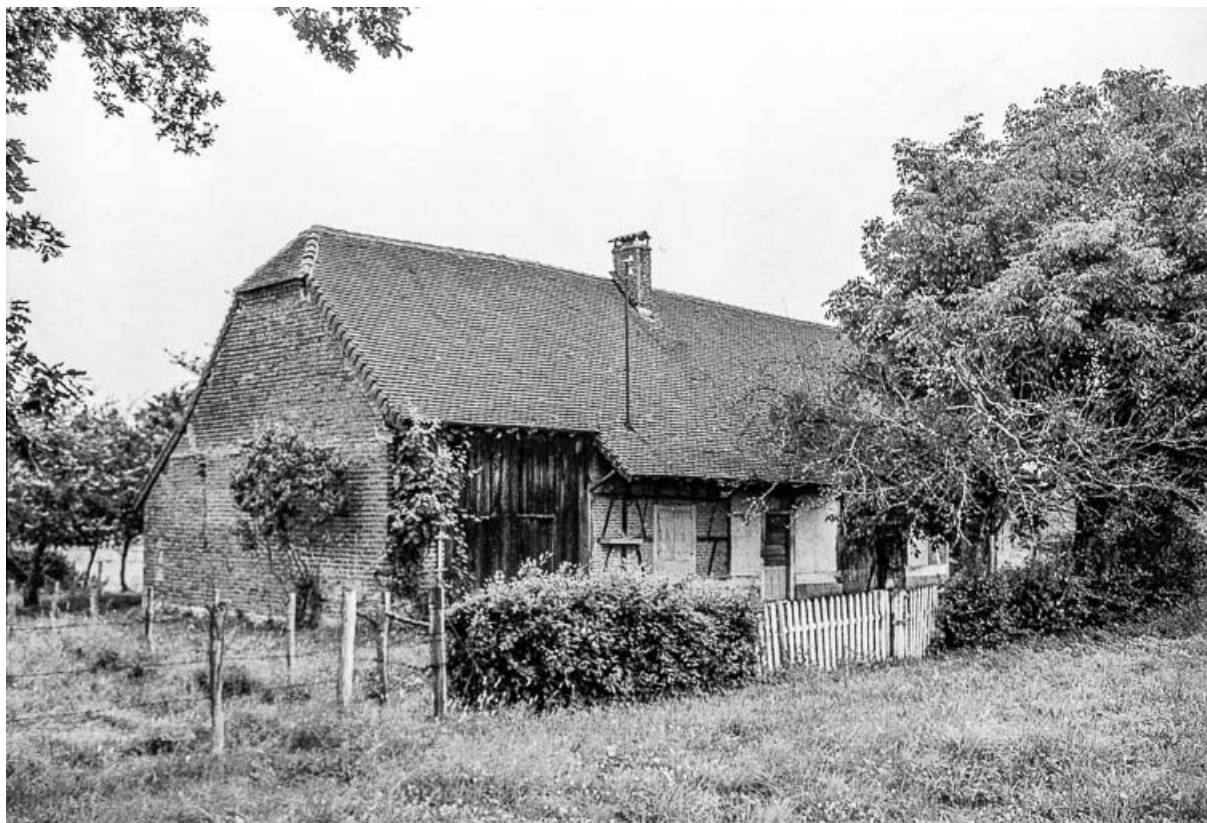
Ferme cadastrée 1969 AE 43 : façade antérieure. 39, Larnaud
