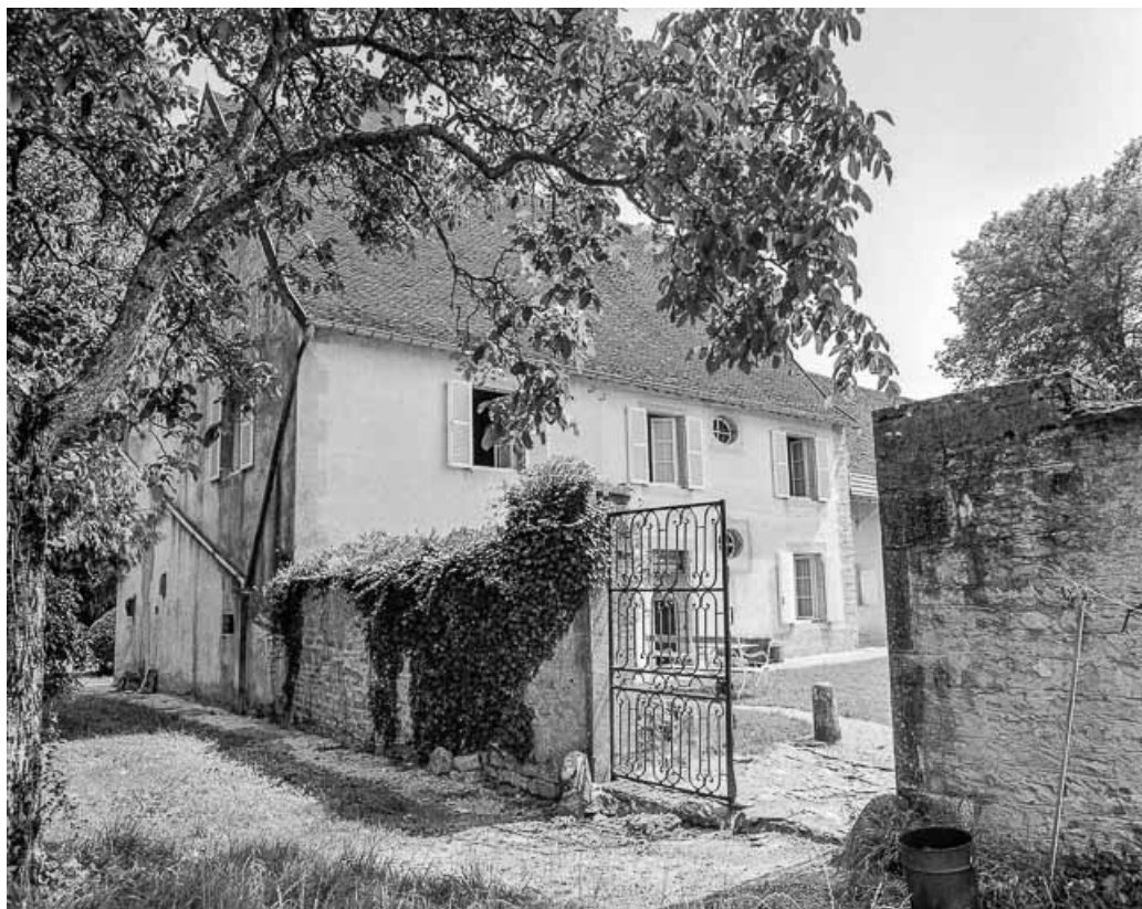
Ferme n° 16 : façade antérieure : vue de trois quarts de la partie gauche. 39, Larnaud
