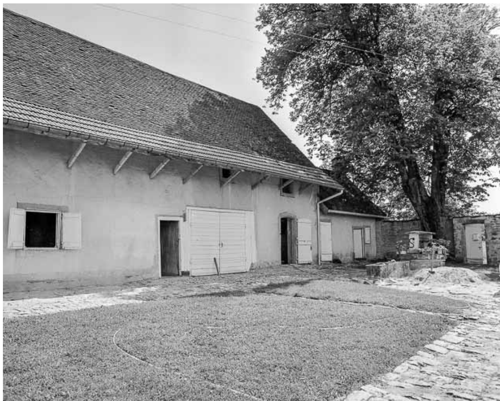
Ferme n° 16 : façade antérieure, partie droite. 39, Larnaud
