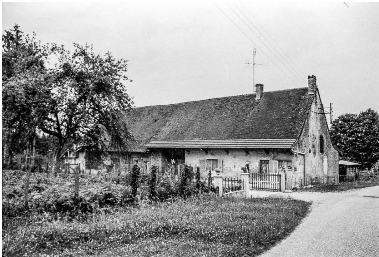
Ferme cadastrée 1969 AI 39 : façades antérieure et latérale droite. 39, Larnaud
