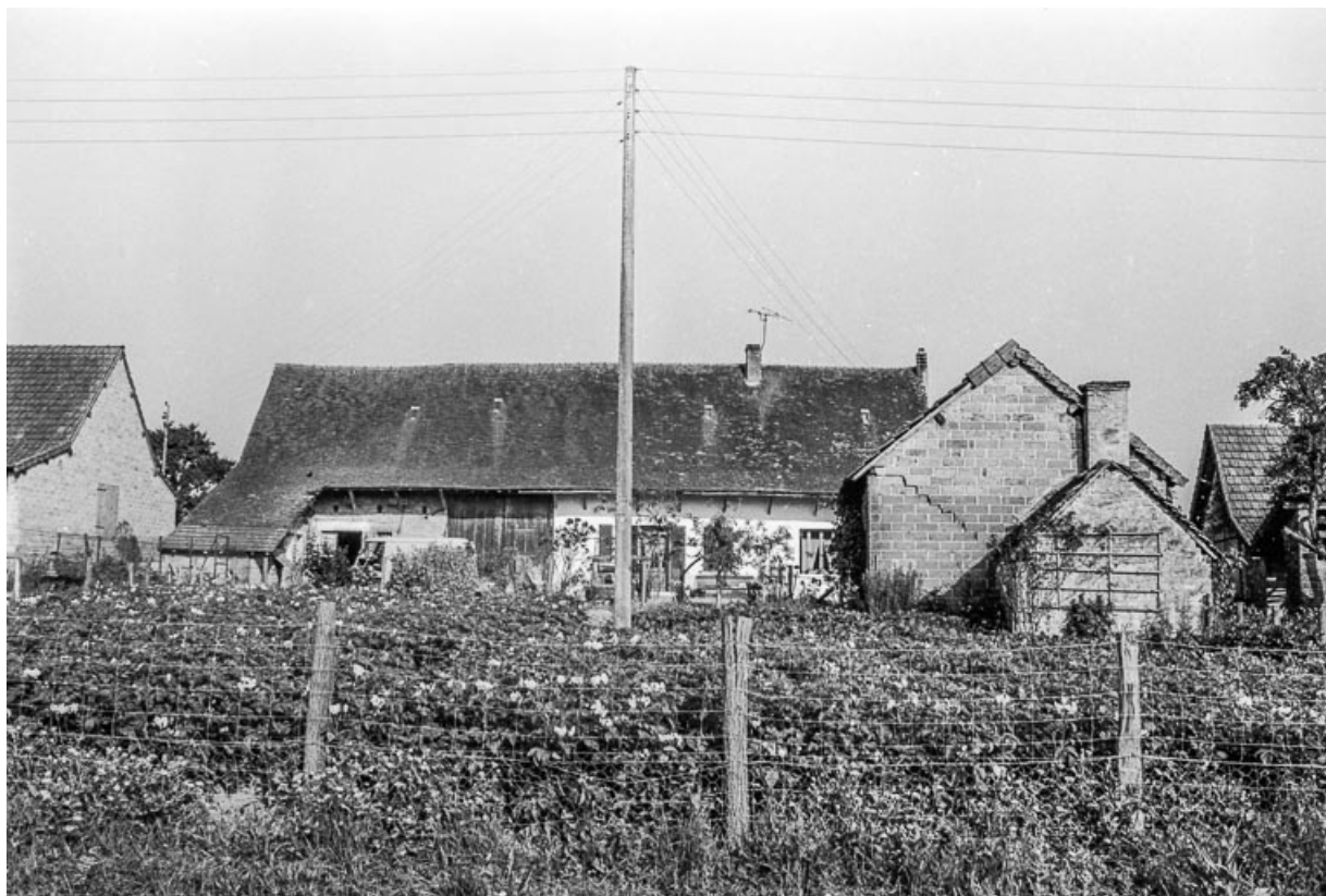
Ferme cadastrée 1956 A1 169 : façade antérieure. 39, Fontainebrux
