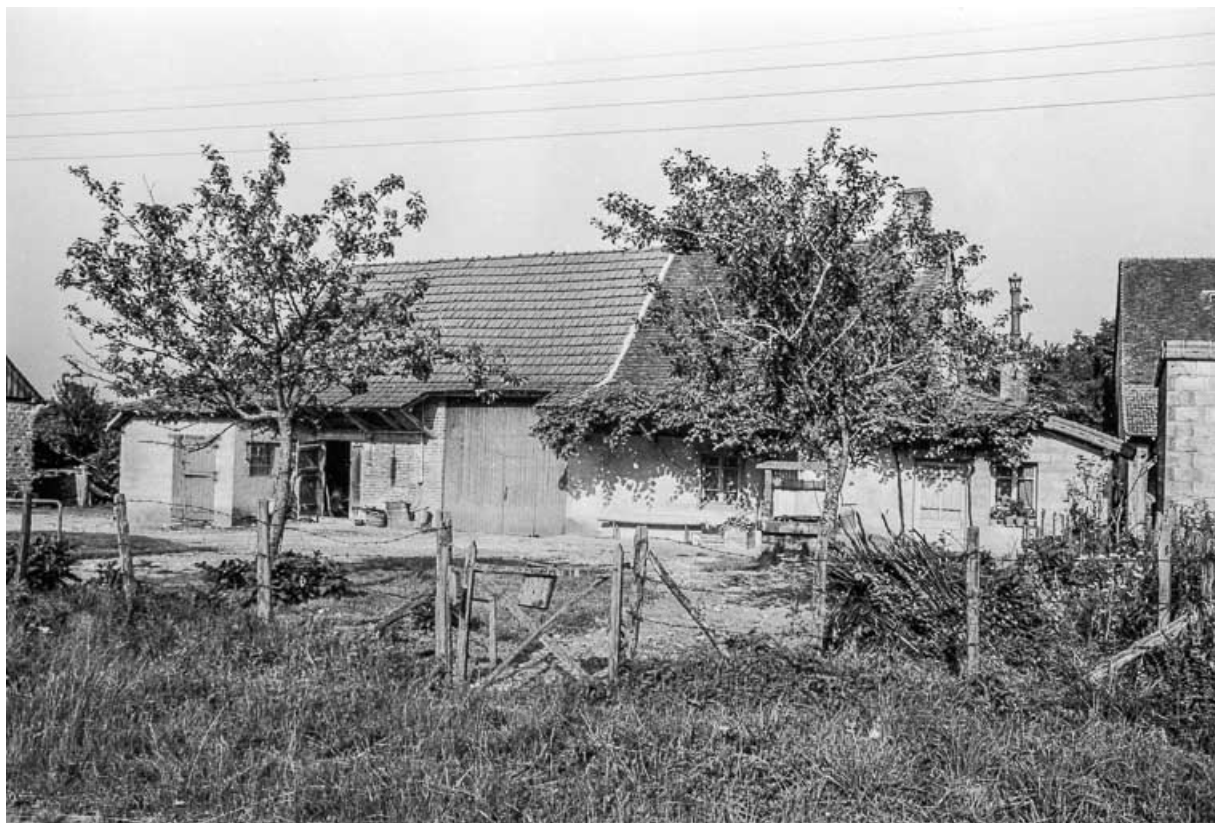
Ferme cadastrée 1956 A2 431 : façade antérieure. 39, Fontainebrux
