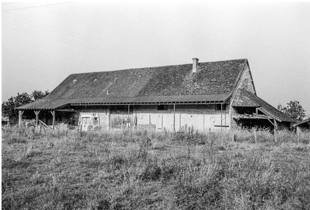
Ferme cadastrée 1956 A2 424 : façade antérieure. 39, Fontainebrux
