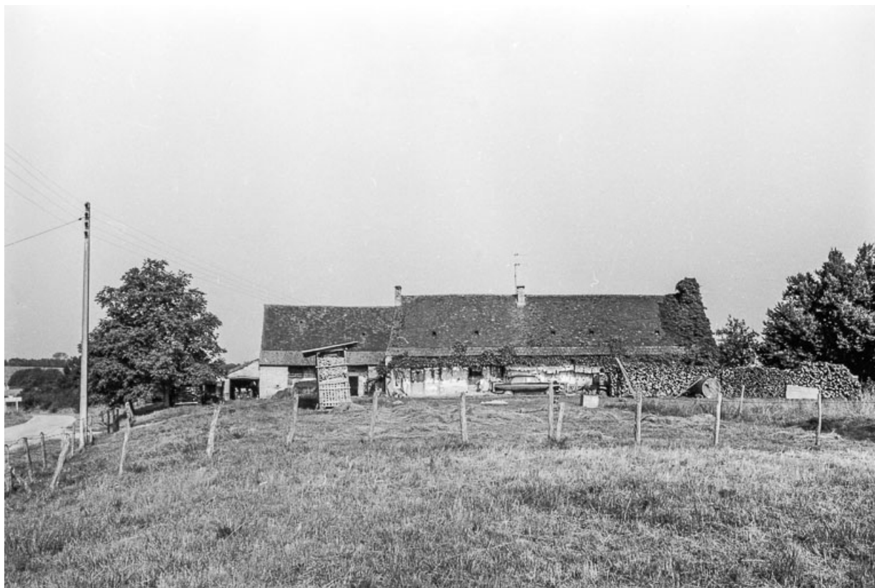
Ferme cadastrée 1956 A2 228 : vue générale. 39, Fontainebrux
