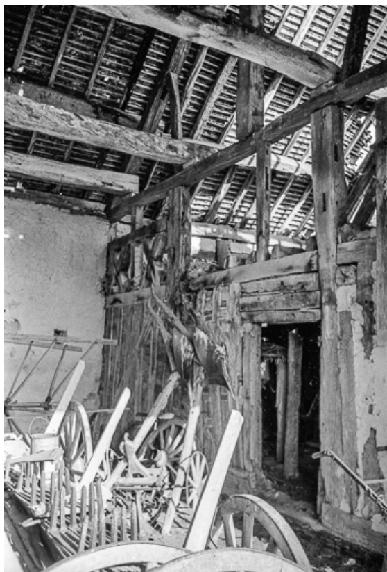
Ferme cadastrée 1956 A1 142-143 : détail de la charpente. 39, Fontainebrux
