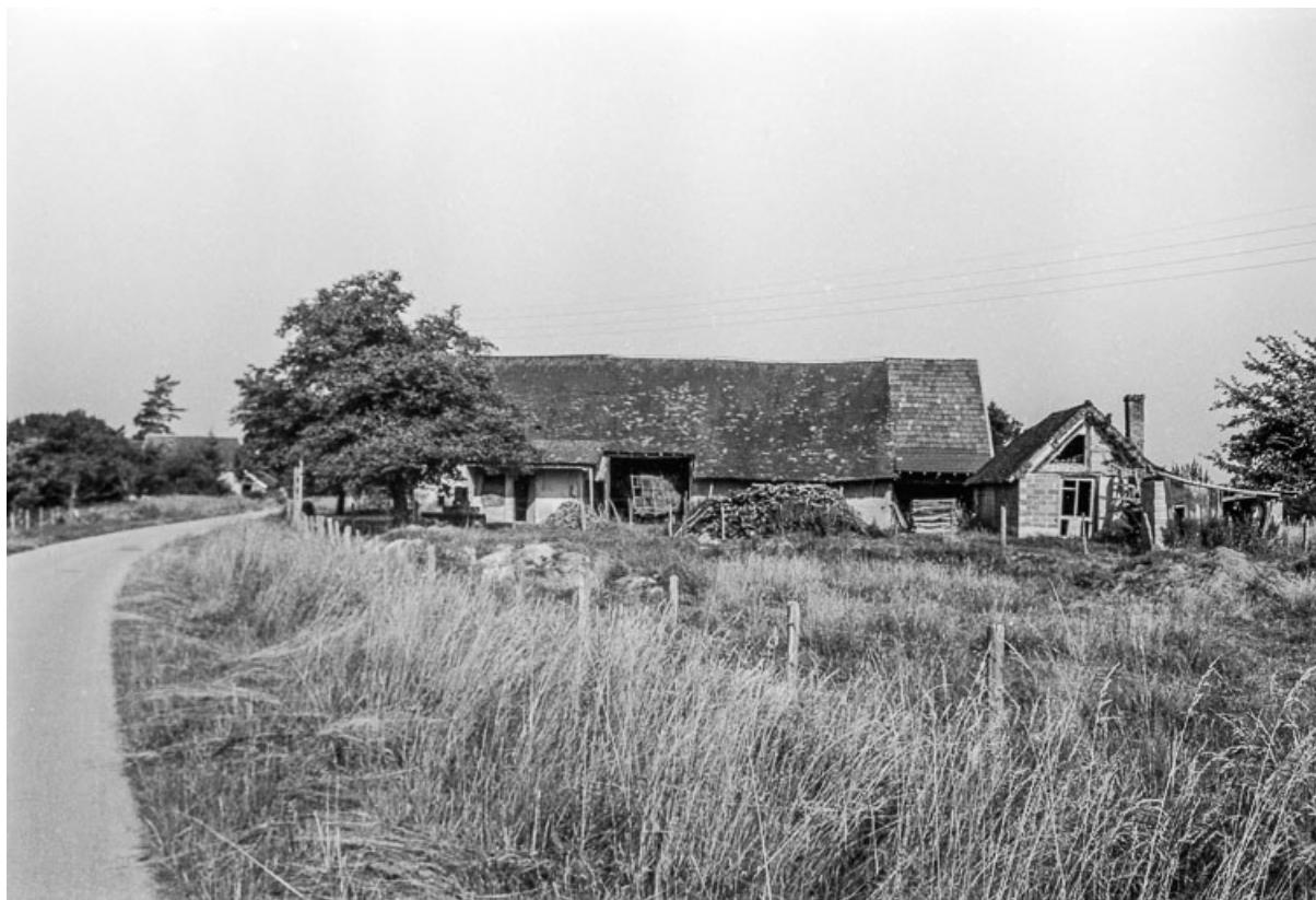
Ferme cadastrée 1956 A2 496 : vue générale. 39, Fontainebrux
