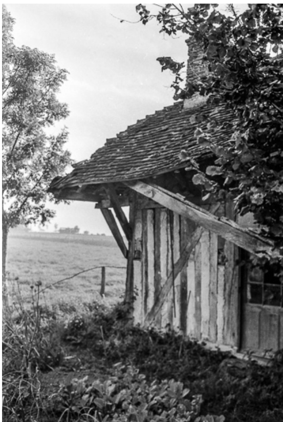
Ferme cadastrée 1956 A1 142-143 : détail du auvent. 39, Fontainebrux
