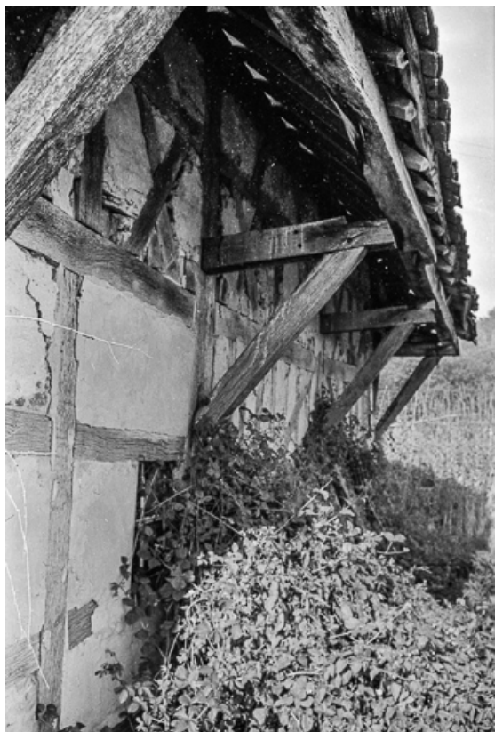
Ferme cadastrée 1956 A1 142-143 : détail du auvent. 39, Fontainebrux
