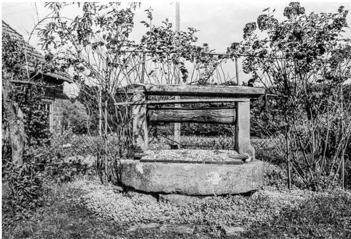
Ferme cadastrée 1956 A1 169 : puits. 39, Fontainebrux
