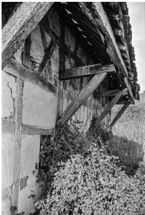
Ferme cadastrée 1956 A1 142-143 : détail du auvent. 39, Fontainebrux
