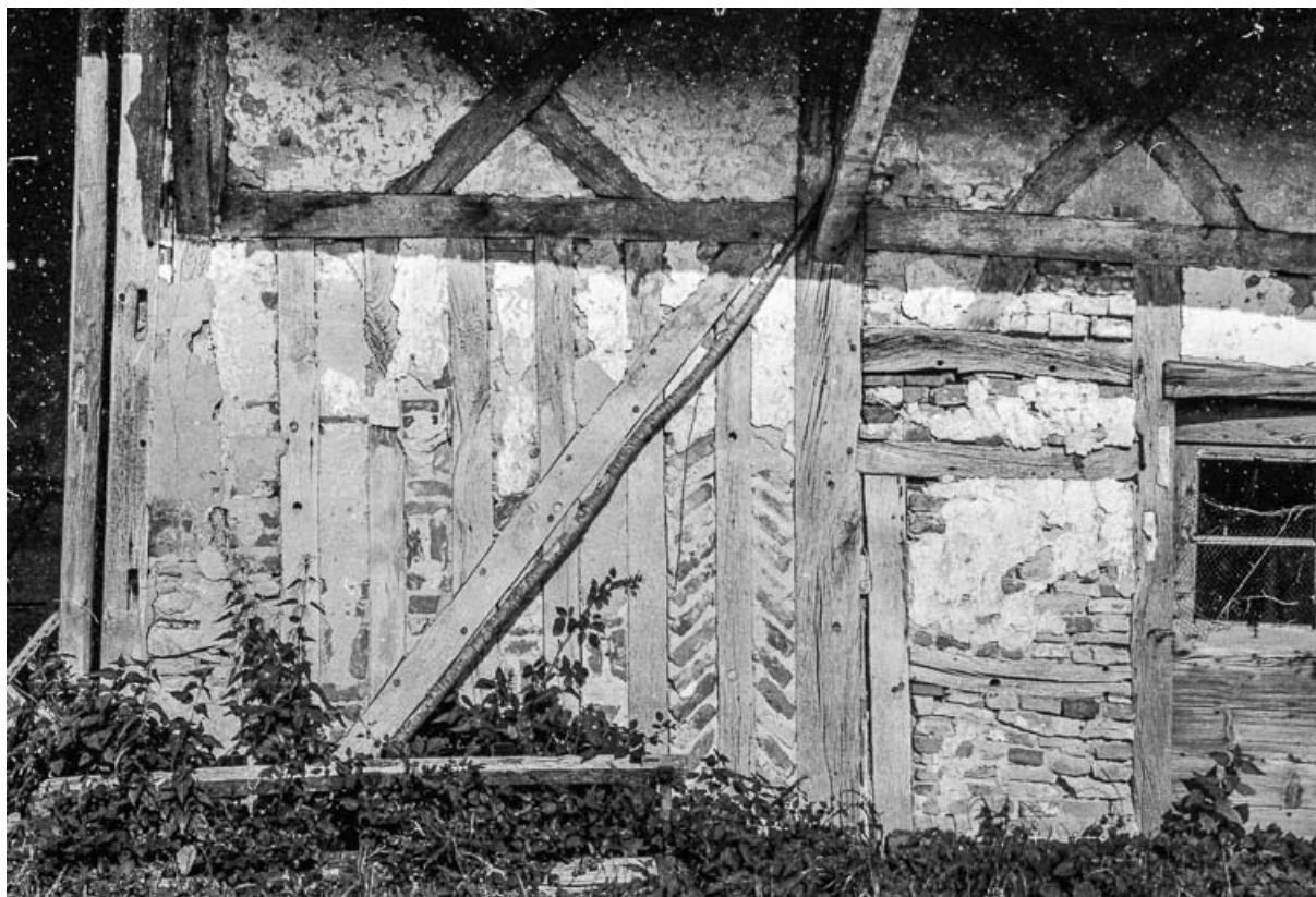
Ferme cadastrée 1956 A1 142-143 : détail du mur. 39, Fontainebrux
