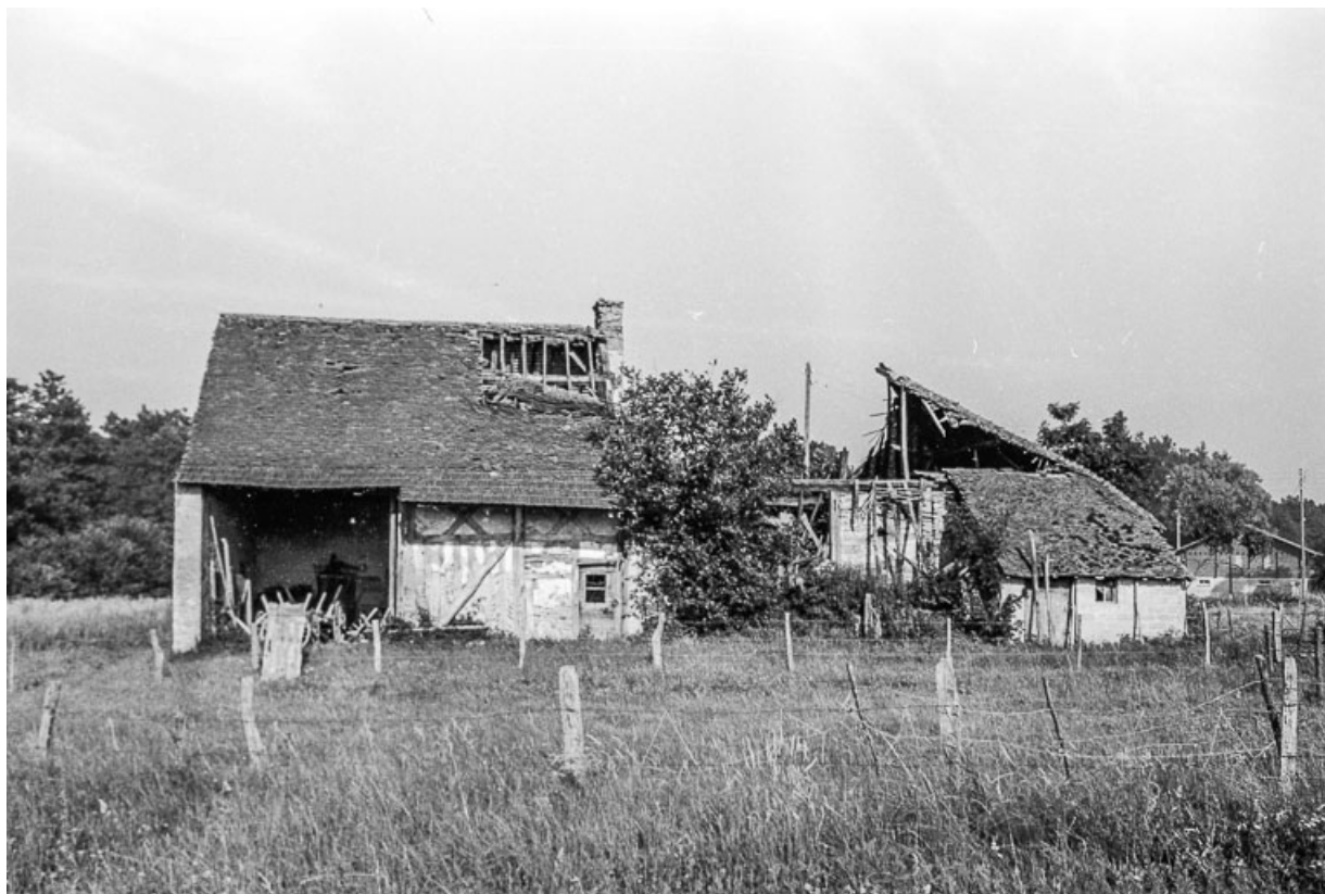
Ferme cadastrée 1956 A1 142-143 : vue générale.
