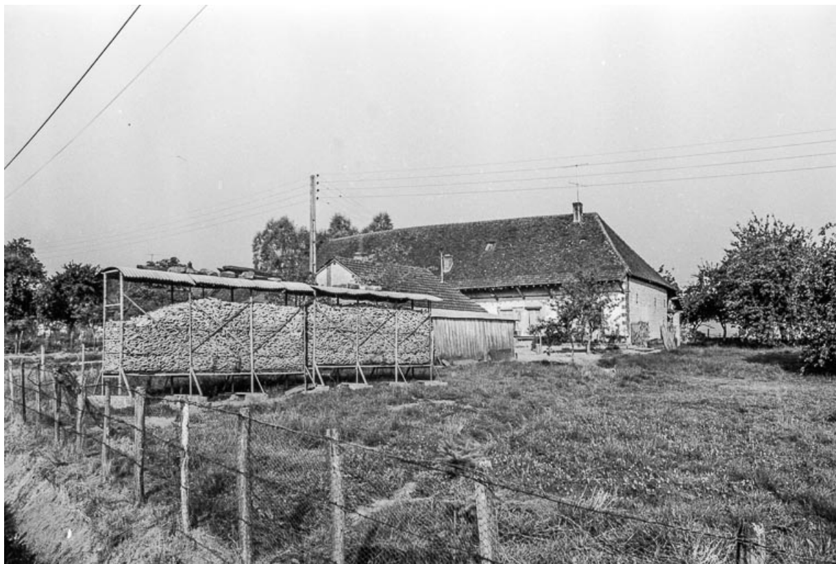
Ferme cadastrée 1956 A1 168 : façade antérieure. 39, Fontainebrux
