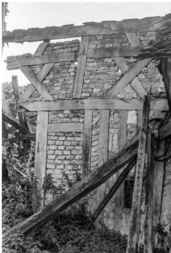
Ferme cadastrée 1956 A1 142-143 : détail du mur. 39, Fontainebrux
