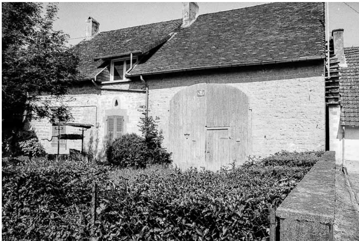
Ferme cadastrée 1984 B 502 : façade antérieure et grange. 39, Desnes
