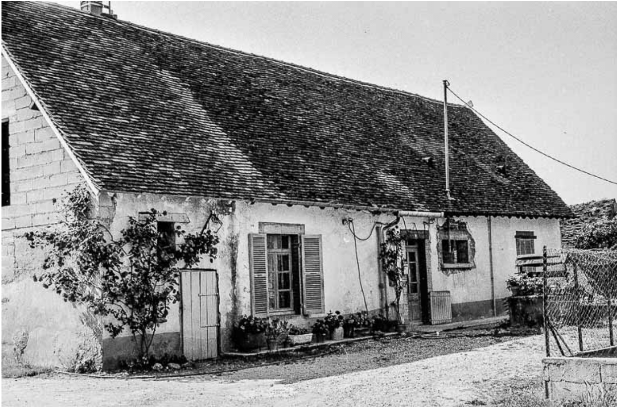
Ferme cadastrée 1984 B 545 : façade antérieure. 39, Desnes
