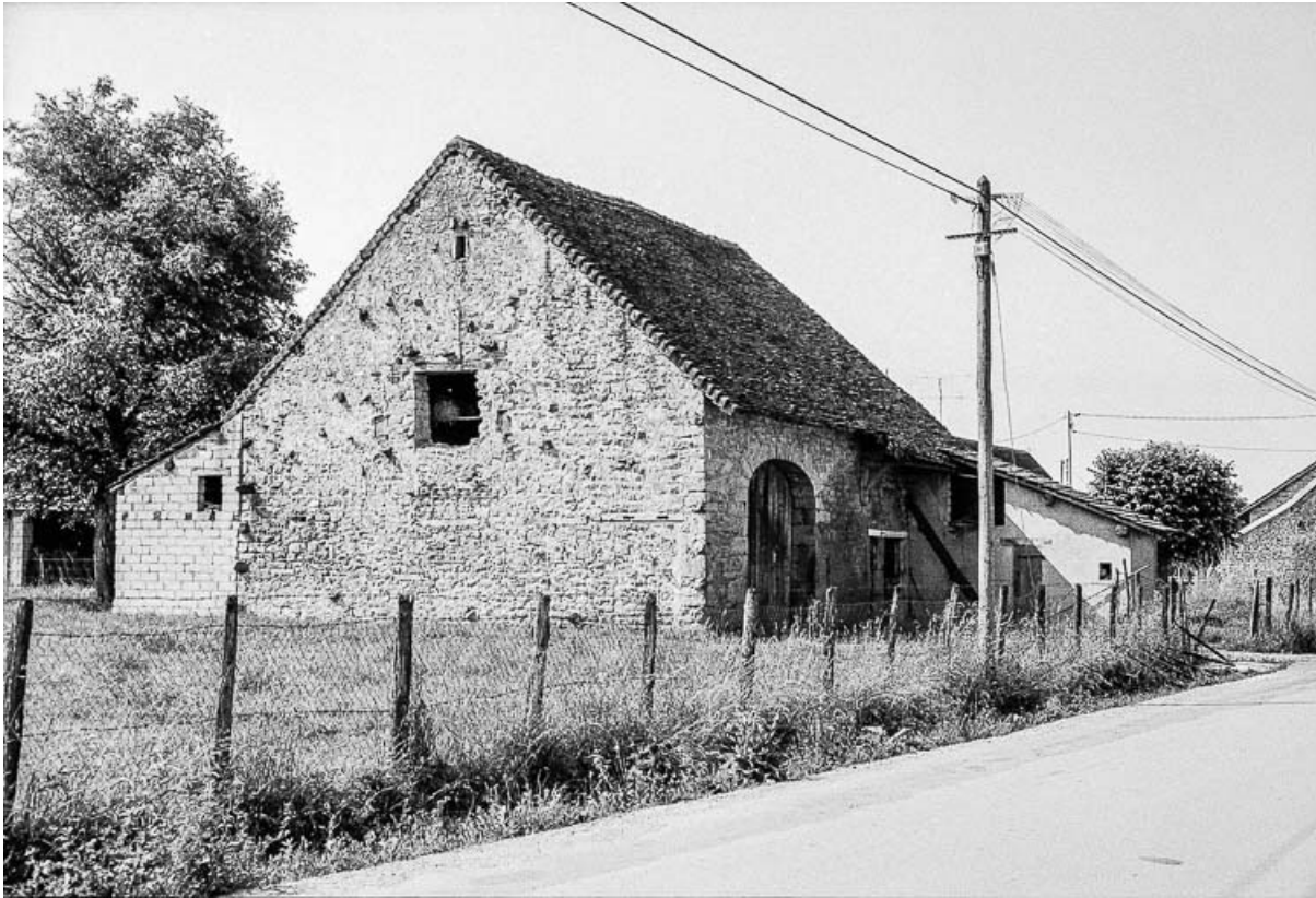
Ferme cadastrée 1984 B 552 : vue d'ensemble. 39, Desnes
