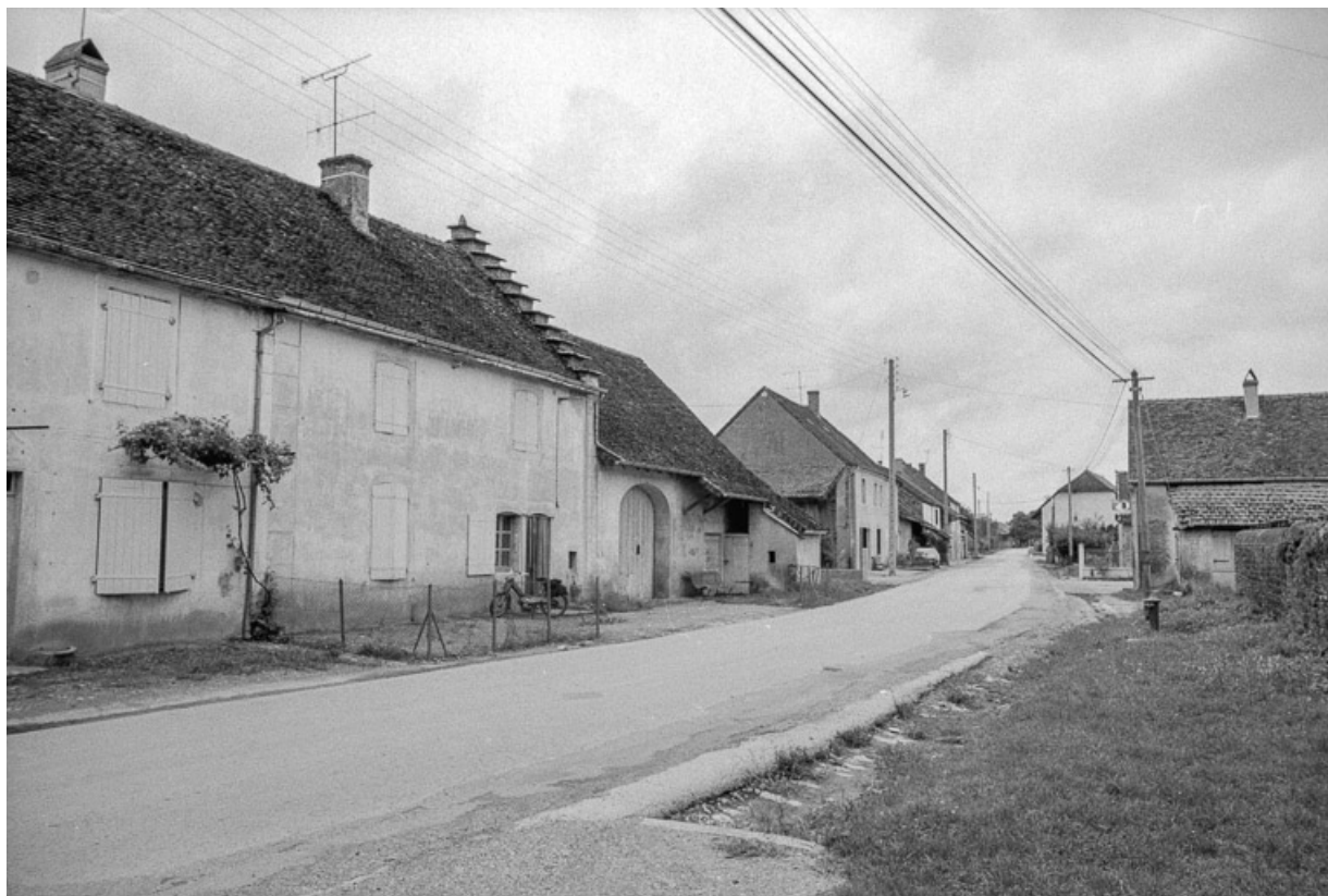
Vue générale de la route de Sellières à Louhans. 39, Desnes
