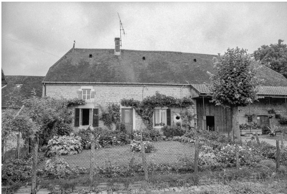
Ferme cadastrée 1984 B 84 : partie gauche de la façade antérieure. 39, Desnes
