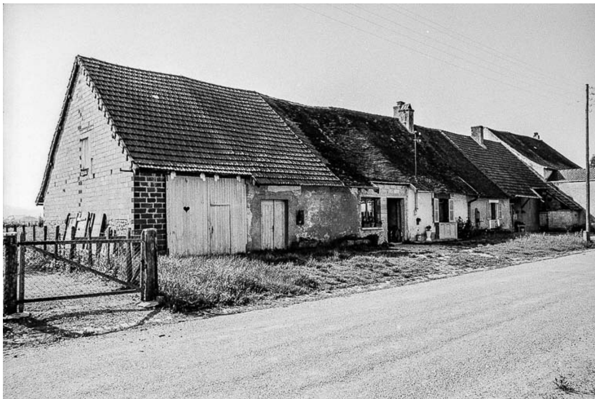
Ferme cadastrée 1984 B2 569-570 : vue d'ensemble. 39, Desnes
