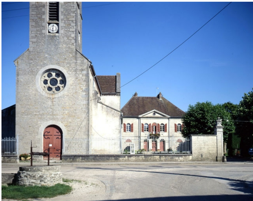
Façade antérieure en 1990 avec la mairie en arrière-plan 39, Desnes
