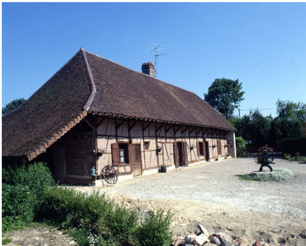
Bâtiment d'habitation : façade antérieure et cour en 1990.
