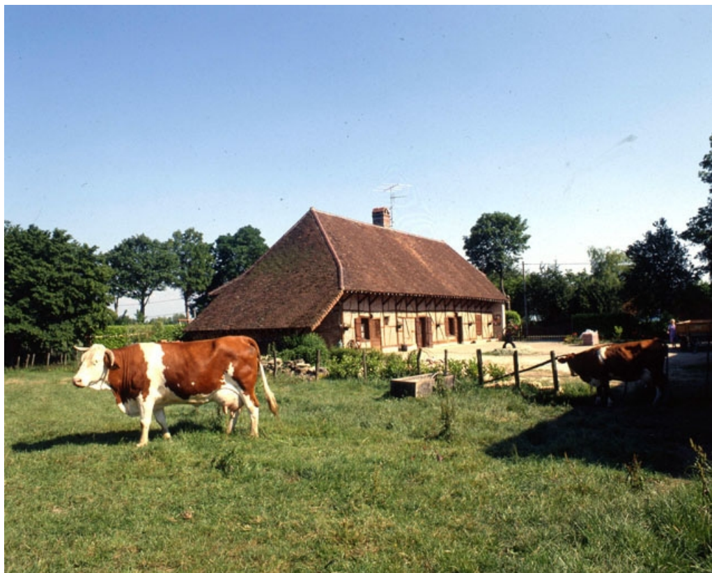
Bâtiment d'habitation : vue d'ensemble de trois quarts gauche.
