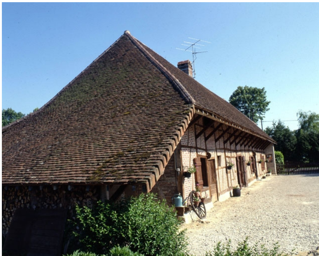
Bâtiment d'habitation : façades antérieure et latérale gauche en 1990.
