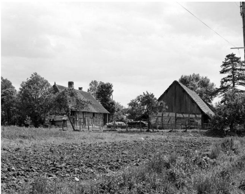
Vue d'ensemble avec le bâtiment agricole en 1979.
