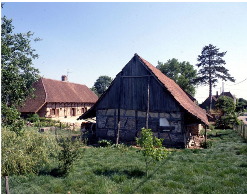
Vue d'ensemble avec le bâtiment agricole en 1990.
