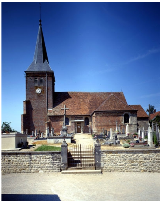
Façade latérale droite.
