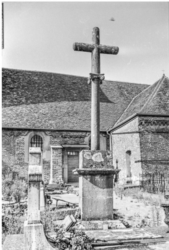
Croix du cimetière autour de l'église : vue d'ensemble. 39, Cosges
