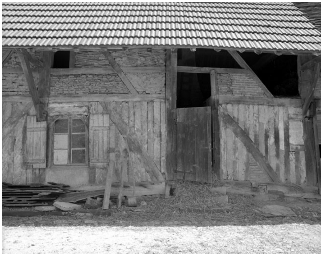
Bâtiment d'habitation : détail de la façade antérieure.
