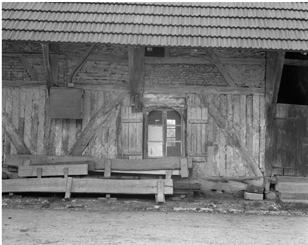
Bâtiment d'habitation : détail de la façade antérieure.
