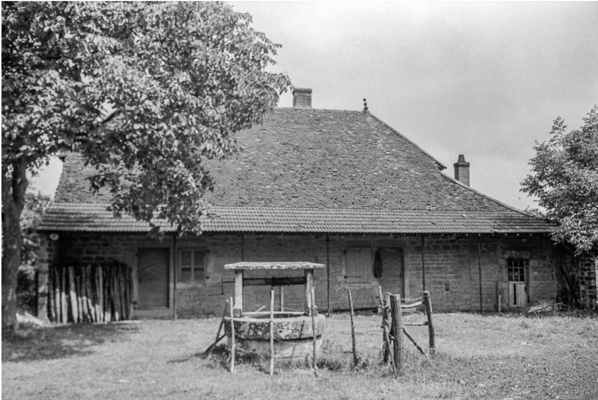
Bâtiment d'habitation : façade antérieure.
