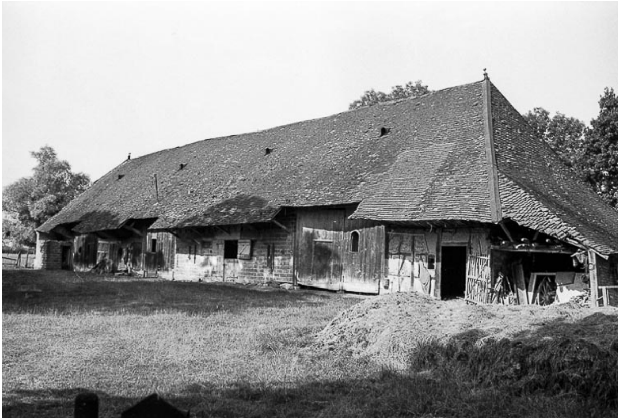
Façade postérieure en 1975.
