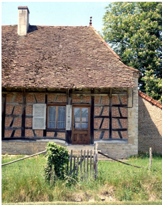
Bâtiment d'habitation en 1990 : partie droite.
