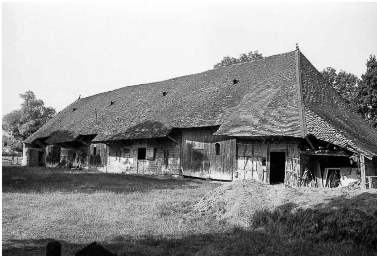
Façade postérieure en 1975.
