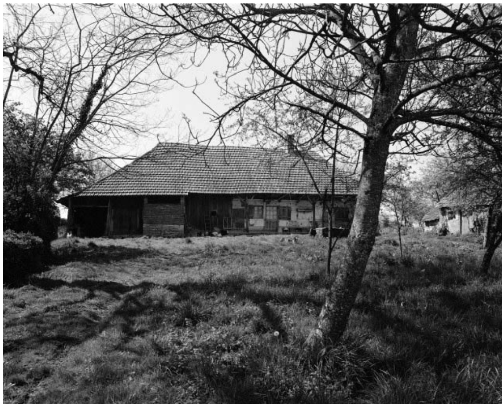
Façade antérieure. 39, Chapelle-Voland
